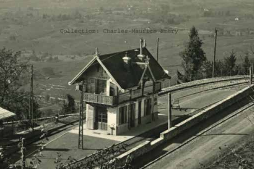
▲ Gare de Chamby avant-après
