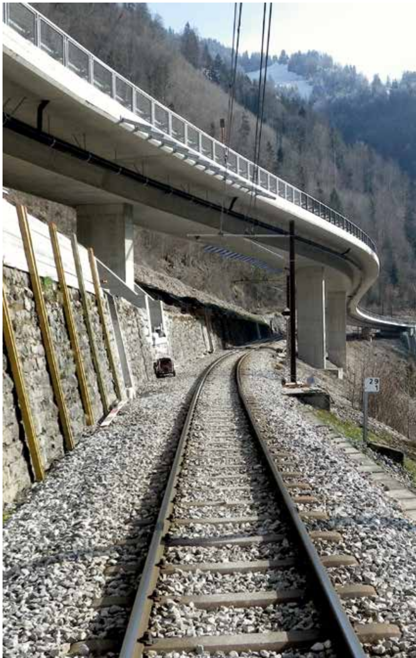
Assainissement du passage à niveau de la Chaudanne.
