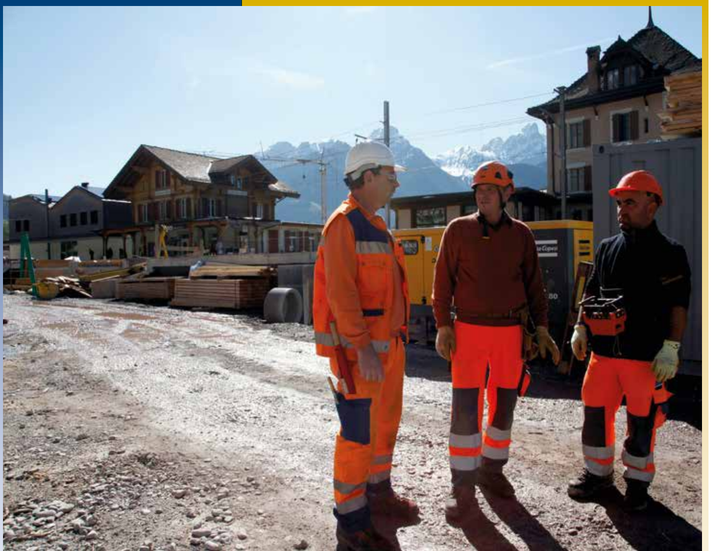
Ouvriers sur le chantier du renouvellement de la gare de Château-d'Oex.
