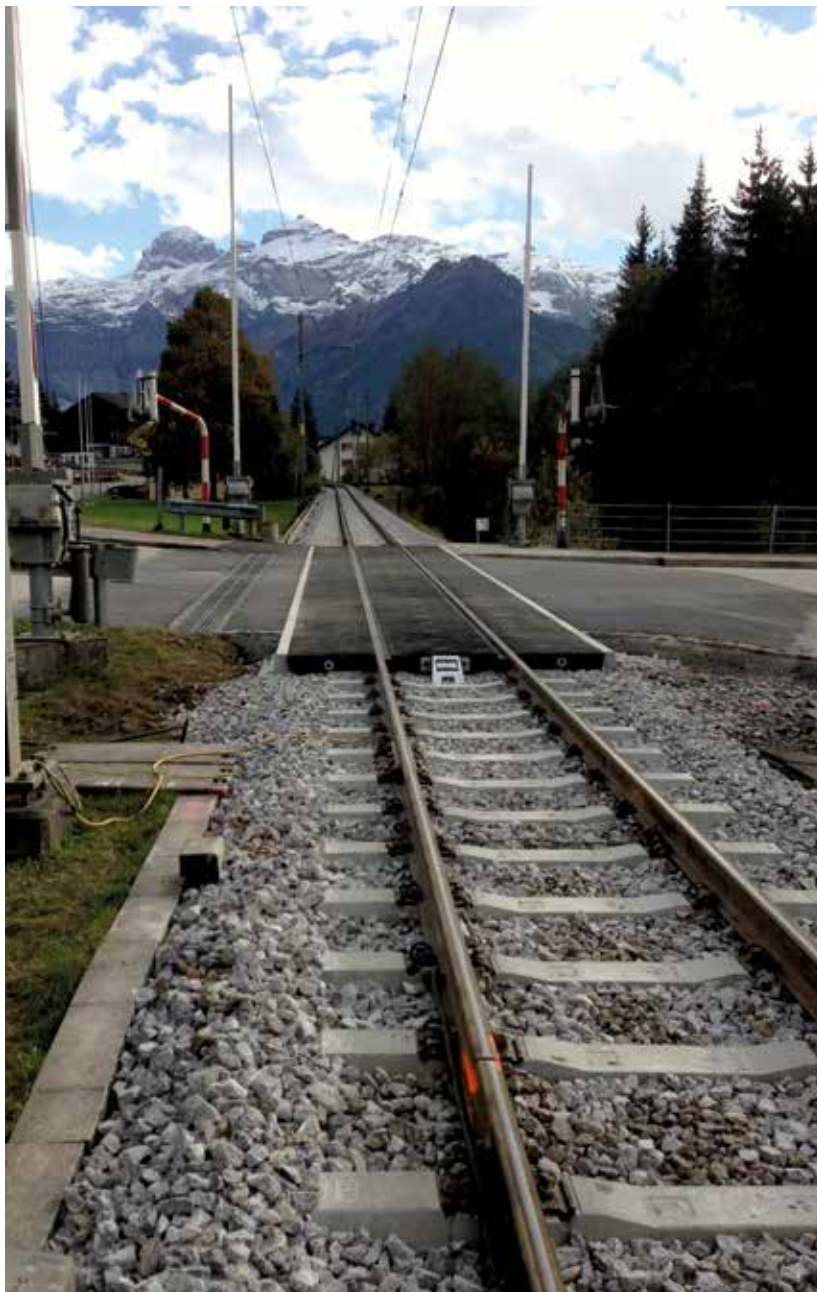
Assainissement de la voie Matten – Lenk.
