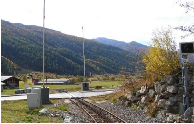
Bahnübergang Bogen Oberwald
