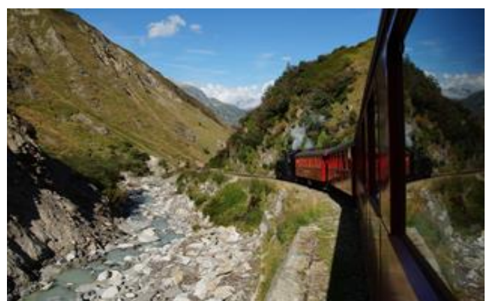
Nach den drei Tunnels vor Realp
