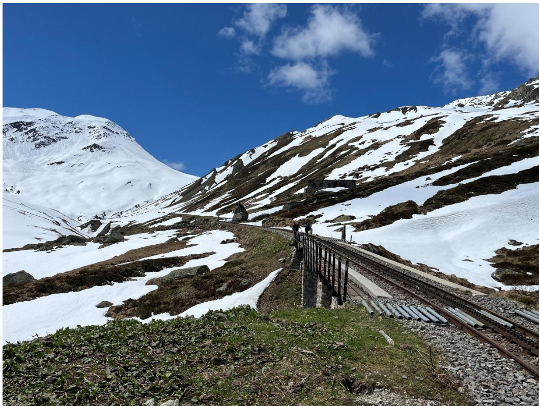
Sidelenbrücke. Bild: Patrick Smit
