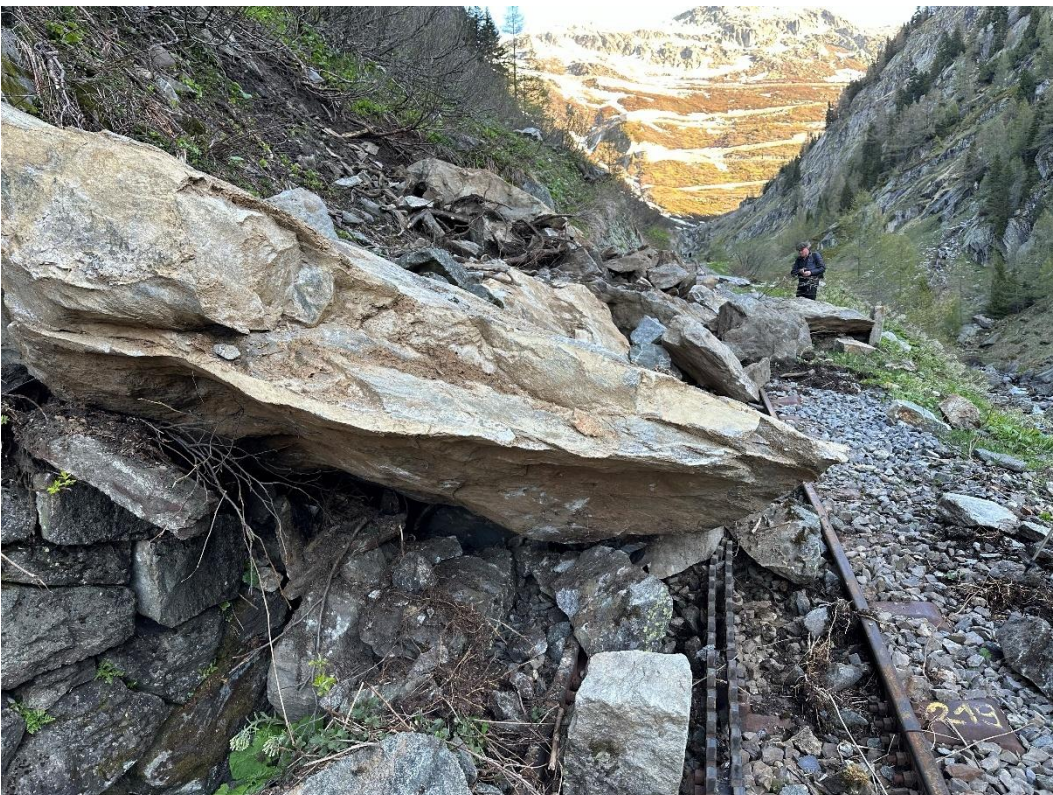
Felssturz zwischen km 44,1 und km 44,5. Bild: Andreas Kleeb
