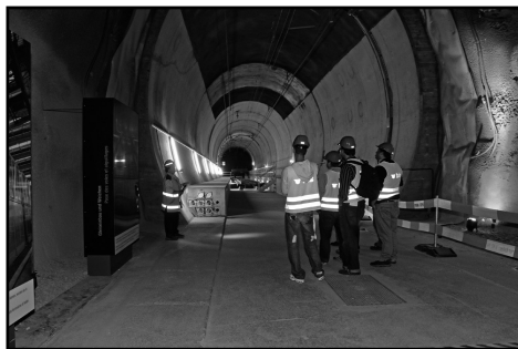
Besichtigung des noch im Rohbau belassenen Tunnelabschnitts. (BLS)
