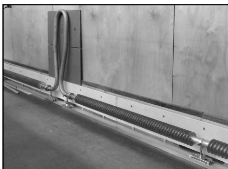
Heizrohre noch unverschalt (hw)
