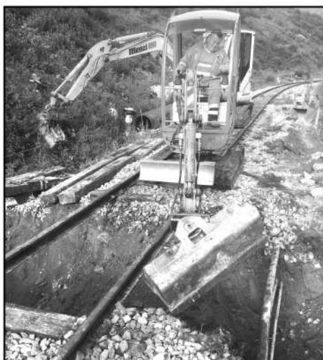
Vergrößerung von Wasserdurchlässen zum Schutz des Trassees
