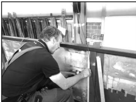
Montage der Leisten für die Befestigung der Innenwandplatten
