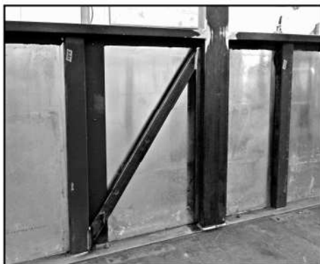
Verstärkung der Wände mit Diagonalrohren
