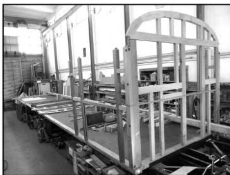
Die Kastenstruktur des AB 4463 ist im Entstehen
