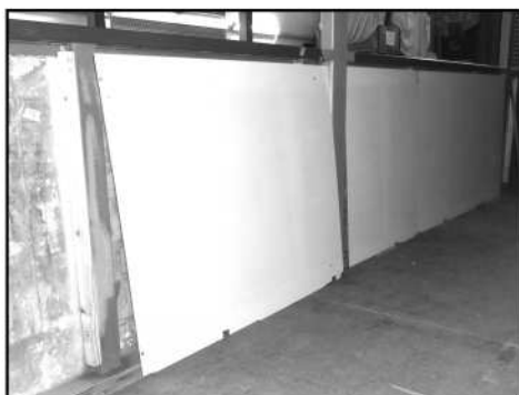
Die Innenwandplatten sind bereits zugeschnitten
