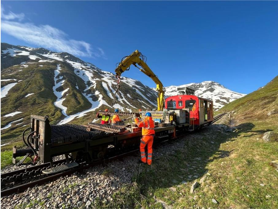
Ablad der Zahnstangen zwischen Tiefenbach und Sidelenbachbrücke. Diese Zahnstangen ersetzen diejenigen Zahnstangen, die vor 10 Tagen markiert wurden.
