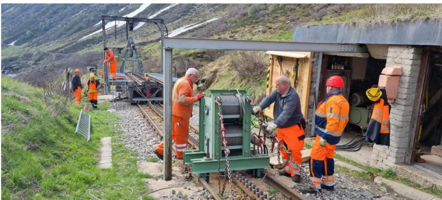
Fred Schönthal, Patrick Gisin und Fritz Gerber verankern die schweren hydraulischen Seilwinden an eigens für diesen Zweck in einer Betonplatte eingelassenen Anschlagpunkten.
