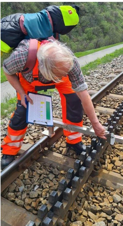
Nach der Auswinterung des Bahnhofs Realp messen Achim Schüler und Ed Groenendijk die Zahnstangenlage zwischen Realp und Wilerbrücke aus. Diejenigen Zahnstangen, deren Lage ausserhalb der Toleranz liegt, markieren sie mit einem weissen Punkt. Die Position der markierten Zahnstange dokumentieren sie zudem in der Streckentabelle.
