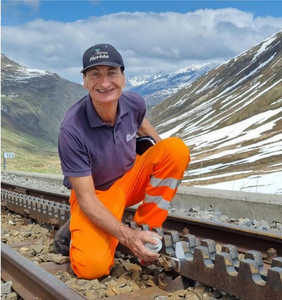
Urs Züllig markiert eine Zahnstange zwischen Tiefenbach und Furka, die ausgetauscht werden muss, weil die Zahnstangenlage ausserhalb der Toleranz liegt.
