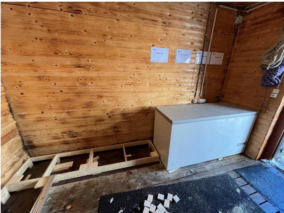
Fred Schönthal konstruiert die Fundamente für die neuen Holzgestelle zur Lagerung des Gastronomiematerials. Der über 30 Jahre alte Holzboden ist vor allem im hinteren Teil des Raums wegen der Feuchtigkeit nicht mehr tragfähig. Aus diesem Grund musste der Holzboden im Bereich der Fundamente für die neuen Holzgestelle herausgerissen werden.
