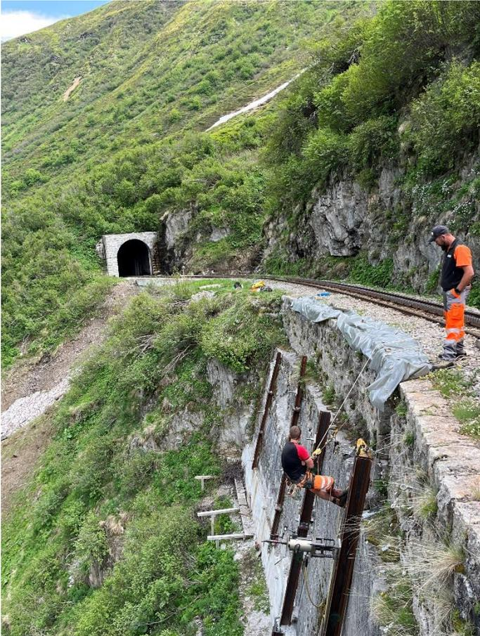
Thilo Fock unterstützt einen externen Fachspezialisten bei der Prüfung der Felsanker der grossen Stützmauer oberhalb des Tunnels 1. Martin Wieland beobachtet den Spezialisten bei seiner Höhenarbeit.
