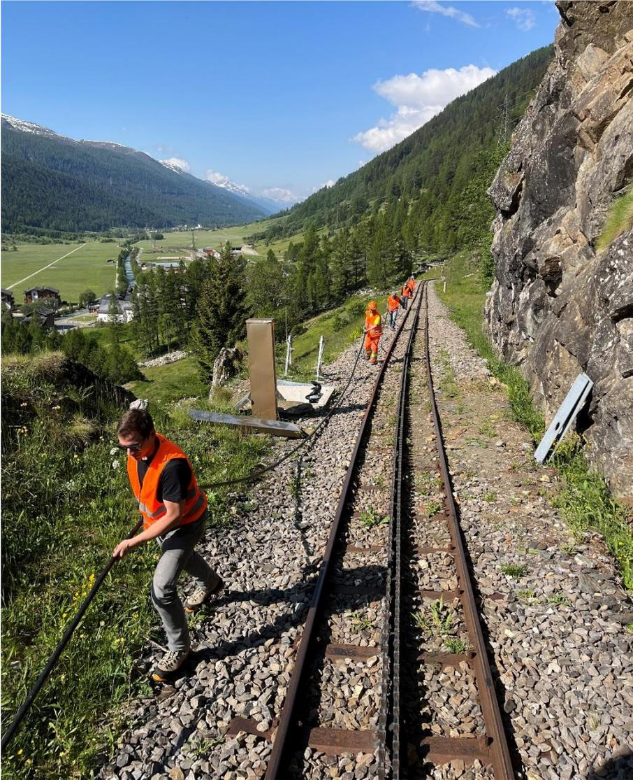
Unter der Leitung von Manfred Willi bereitet das Team der VFB-Sektion Innerschweiz das BLA-Steuerkabel zum Einziehen im Kabelkanal vor. Dieses Kabel ersetzt das vor 12 Jahren eingezogene defekte Kabel.
