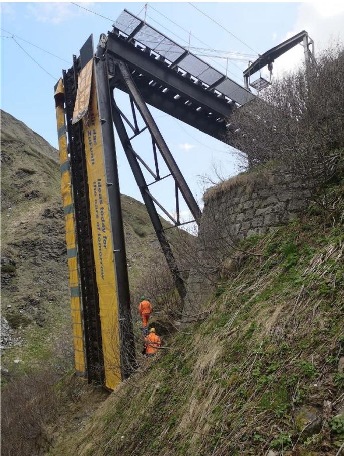
Nachdem das talseitige Brückenelement in die Sommerstellung gebracht wurde, werden die Flaschenzüge so vorbereitet, dass anschliessend das bergseitige Brückenelement in die Sommerstellung verschoben werden kann.
