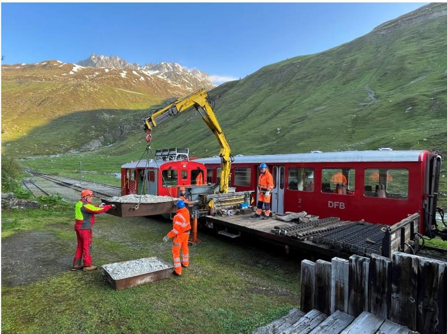
Nach der Montage des Wasserkrans wird der am Vortag ausgespitzte Aushub des Wasserreservoirs profilfrei deponiert.
