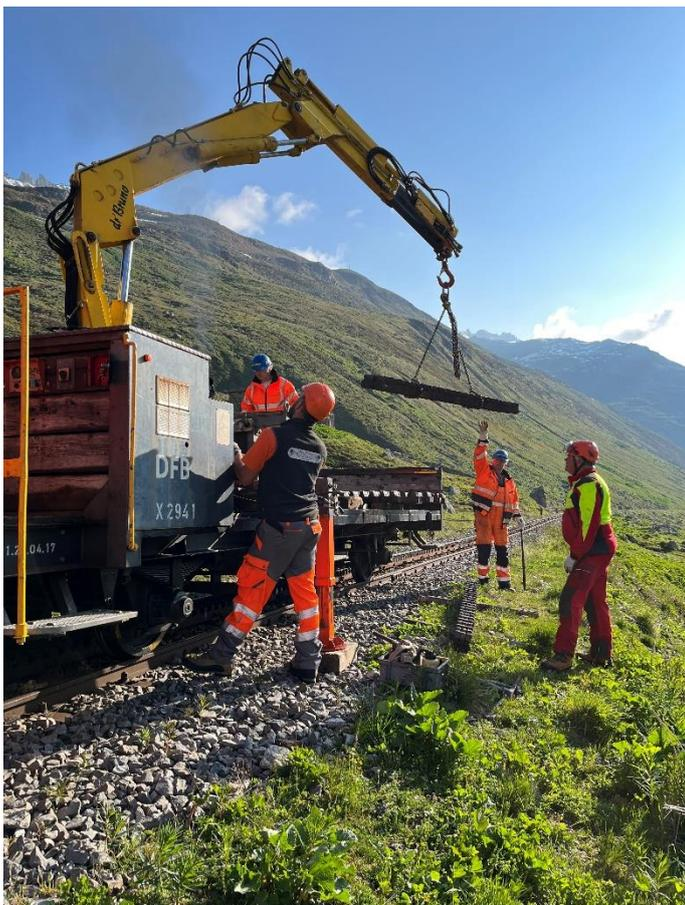
Zwischen dem Steinstafelviadukt und Station Furka wurden innert 2 ½ Tagen 50 Zahnstangen ausgetauscht.
