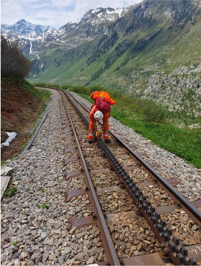
Werner Spahni und Bruno Zimmermann erfassen die knapp 12'000 Zahnstangensattel zwischen Muttbach und Oberwald. Mit Schraubenzieher und Stahlbürste muss zuerst der Kopf des Sattels gereinigt werden. Anschliessend kann der Satteltyp abgelesen und dokumentiert werden.
