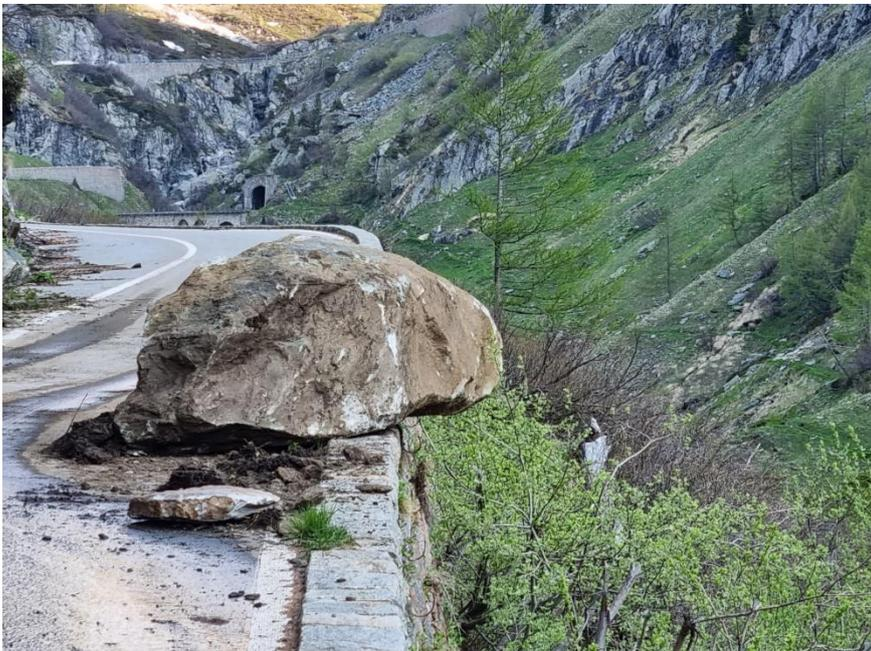
In der Rottenschlucht führt das Tiefbauamt des Kantons Wallis Felsräumungen durch. Zum Glück ist dieser rund 3 m<sup>3</sup> mächtige Felsblock nicht auf das darunterliegende Bahntrasse gestürzt.
