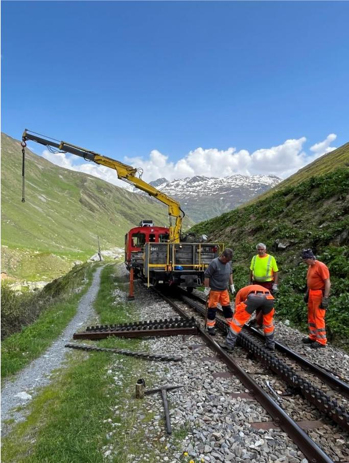
Durch die warme Witterung am frühen Nachmittag dehnt sich das Eisen aus. Aus diesem Grund ist das Einpassen und Verschrauben der Zahnstangen unterhalb des Steinstafelviadukts ein mühsames Unterfangen.
