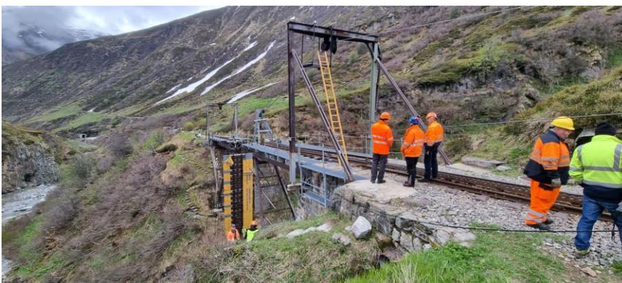
Das bergseitige Brückenelement ist in der Sommerstellung. Nun wird der Flaschenzug für das Hochziehen des mittleren Brückenelements vorbereitet.
