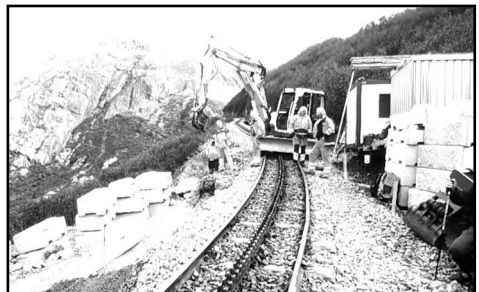
Stützmauerbau mit RECON-Steinen
