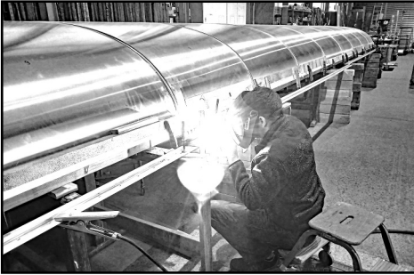
Zusammenschweissen der Teilstücke der Dachrinne
