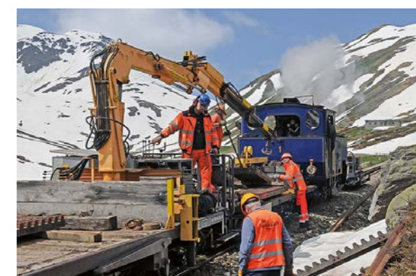
Fotos von Urs W. Züllig: Freiwillige bei Arbeiten auf über 2100 Meter über Meer oberhalb der Station Furka
