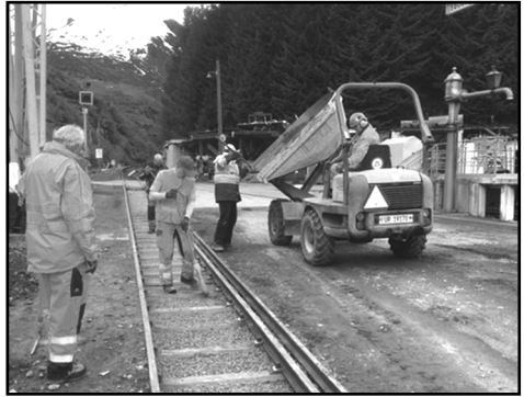
Schottererneuerung beim Depot Realp
