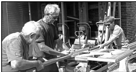
Zuschneiden des Dachtäfers
