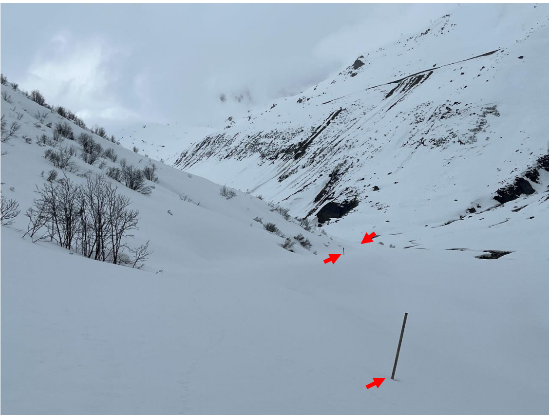
Bahnhof Tiefenbach. Vorderster Pfahl: Zahnstangeneinfahrt Ost. Mittlerer «Pfahl»: Steigrohr Wasserkan. Hinterer Pfahl: Zahnstangeneinfahrt West Bild: Patrick Smit
