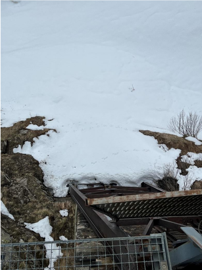
Die Stütze des bergseitigen Brückenelements der Steffenbachbrücke ist fast schneefrei Bild: Patrick Smit
