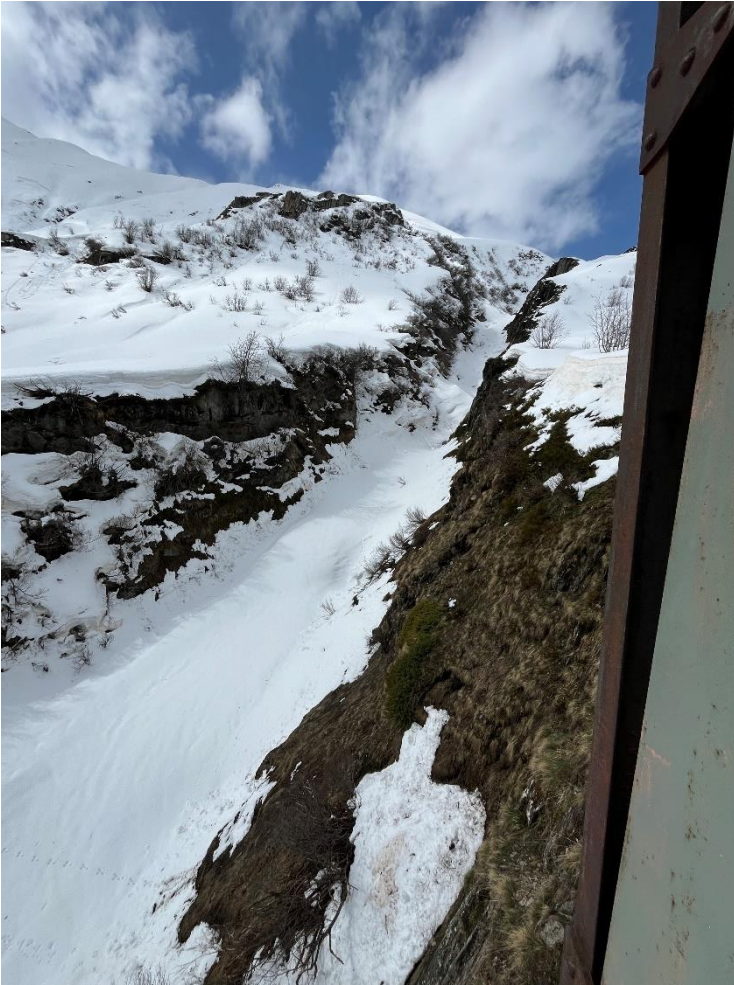
Steffenbachtobel unmittelbar oberhalb der Steffenbachbrücke Bild: Patrick Smit
