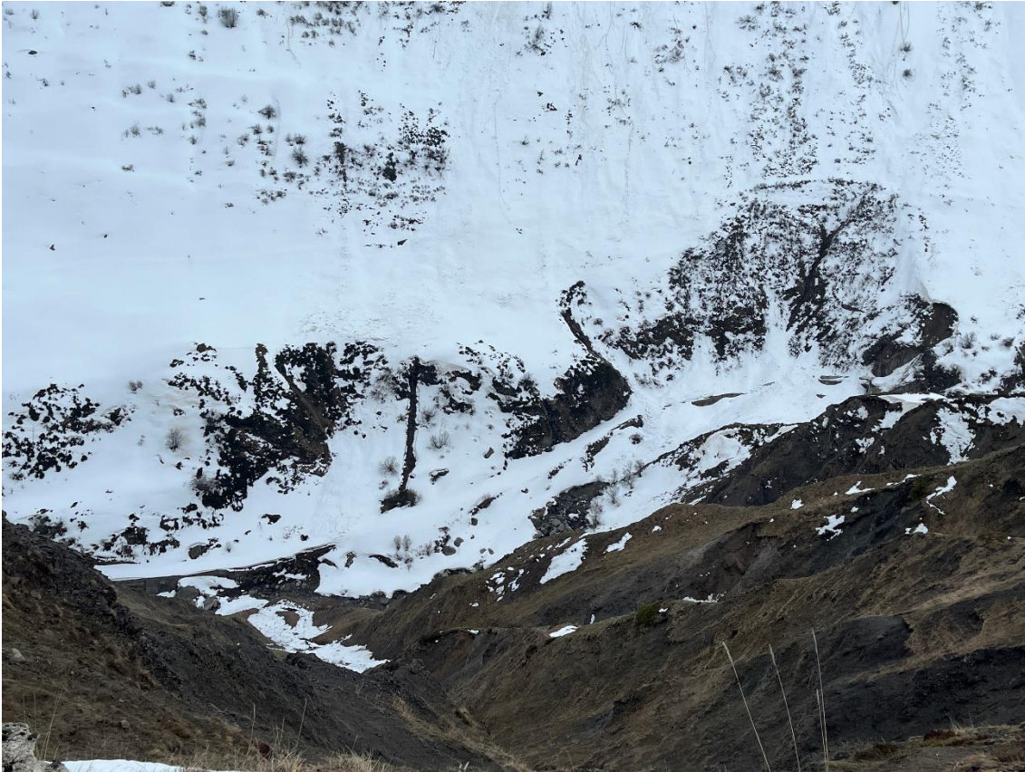
Bahntrasse unterhalb Tunnel 3 Bild: Patrick Smit
