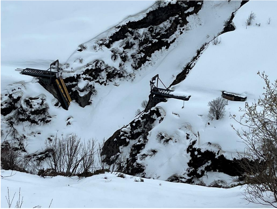
Steffenbachbrücke Bild: Patrick Smit
