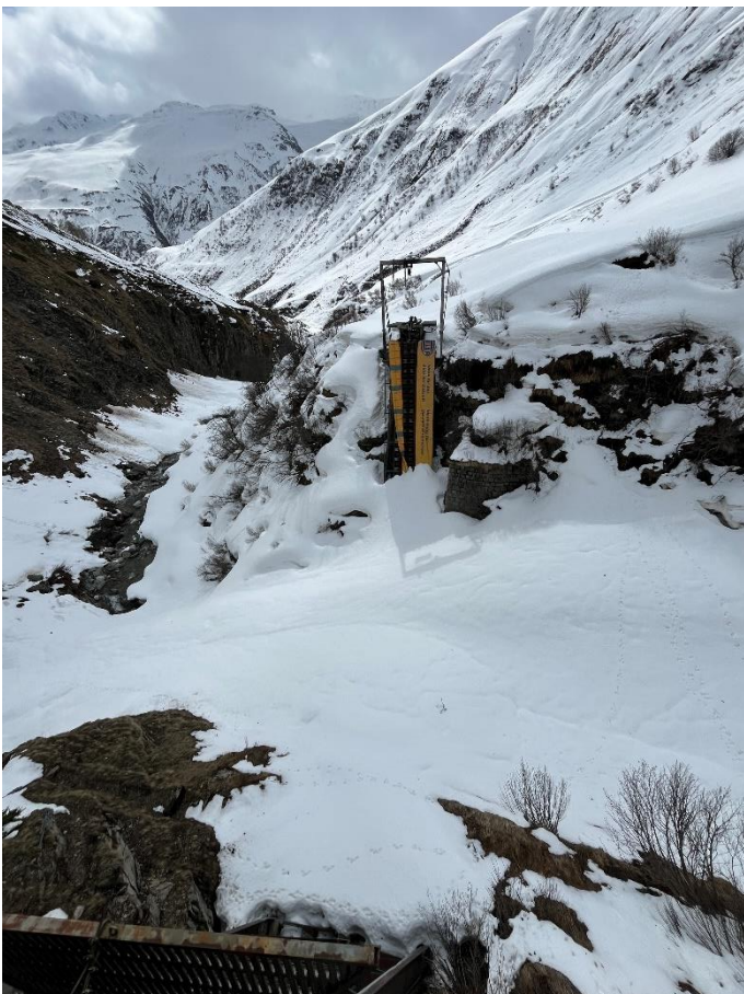
Im Bereich der Steffenbachbrücke ist das Steffenbachtobel zurzeit nur geringmächtig mit (Lawinen-) Schnee verfüllt. Die Vorbereitung der Zugangswege, des Schneekanals und der Arbeitsplätze wird rund zwei bis drei Arbeitstage beanspruchen Bild: Patrick Smit
