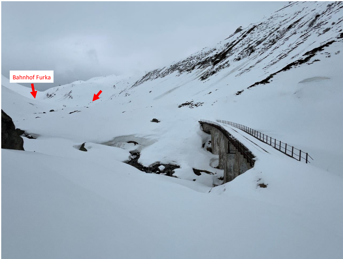
Blick vom Steinstafelviadukt bergwärts. Das Bahntrasse ist bis zum Scheiteltunnel durchgehend mit einer bis ca. 2 m mächtigen Schneeschicht bedeckt. An vielen Orten sind Schneerutsche und Gletschneelawinen niedergegangen. Die Talstation der ehemaligen Militär-Seilbahn bei der Sidelbachbrücke ragt allmählich aus dem Schnee bzw. Schneeverwehungen hervor Bild: Patrick Smit
