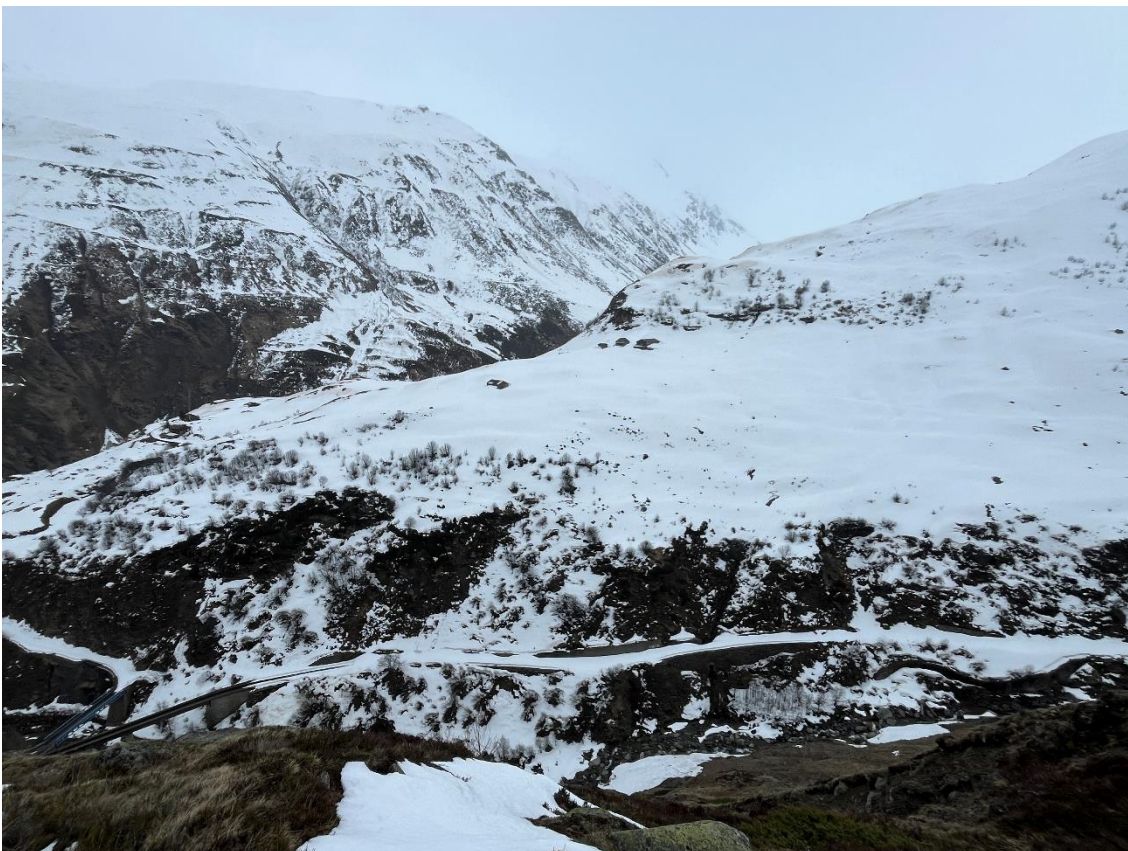
Bis zur Wilerbrücke wurde das Bahntrasse für die zwischen 11. und 15. Mai 2024 ge- planten Bremspro- benfahrten geräumt Bild: Patrick Smit
