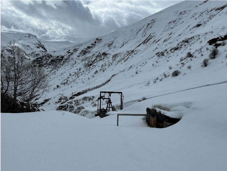
Kein Strom im Windenhaus der Steffenbachbrücke Bild: Patrick Smit
