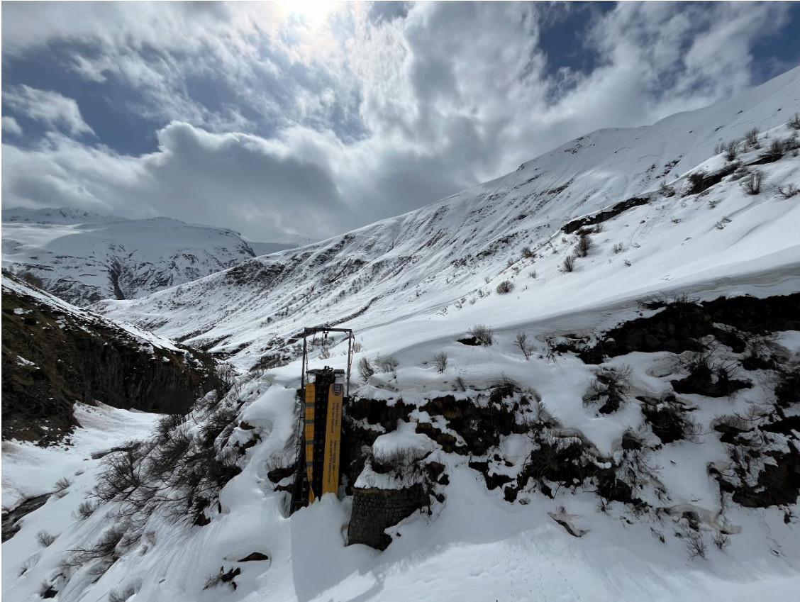
Die talseitigen Brückenelemente und die Hänge unterhalb der Steffenbachbrücke im Sonnenschein Bild: Patrick Smit
