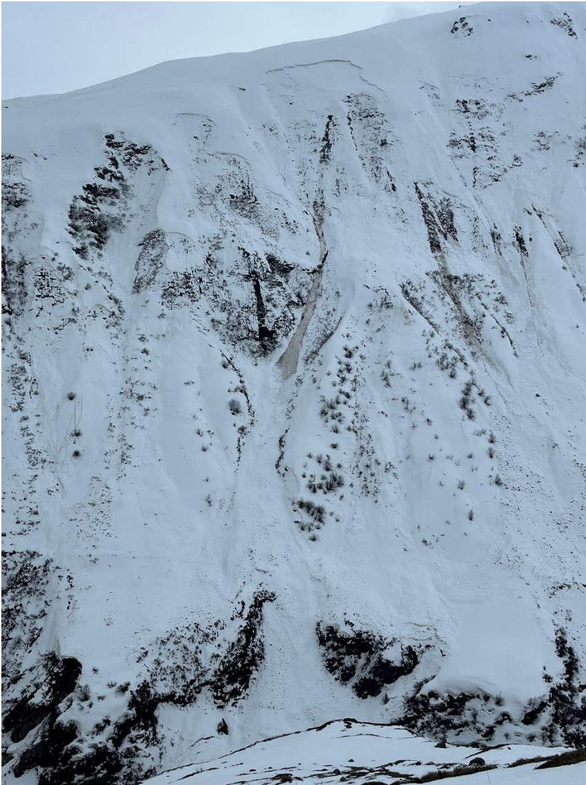
Bahntrasse und Bergflanken zwischen Tunnel 3 und Tunnel 2 Bild: Patrick Smit
