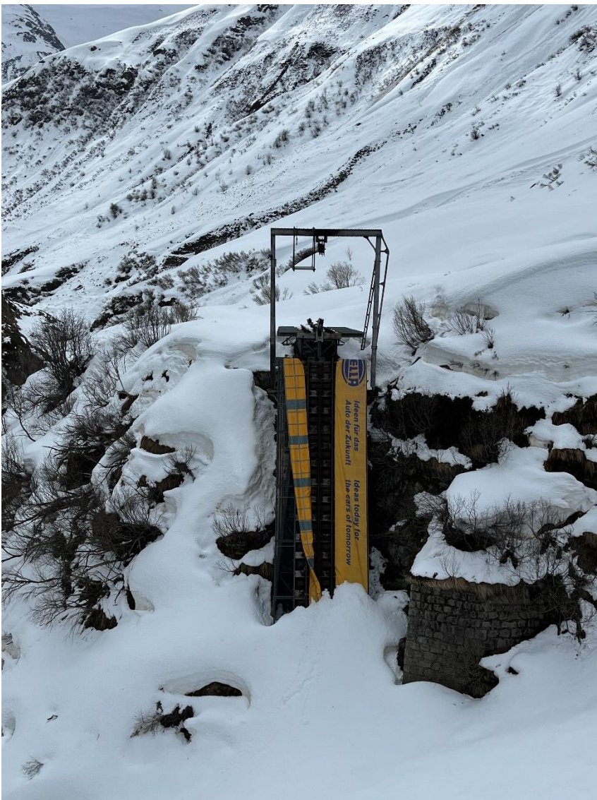
Die talseitigen Brückenelemente der Steffenbachbrücke . Die Schneeverwehungen an den Flanken des Widerlagers sind bemerkenswert gross Bild: Patrick Smit
