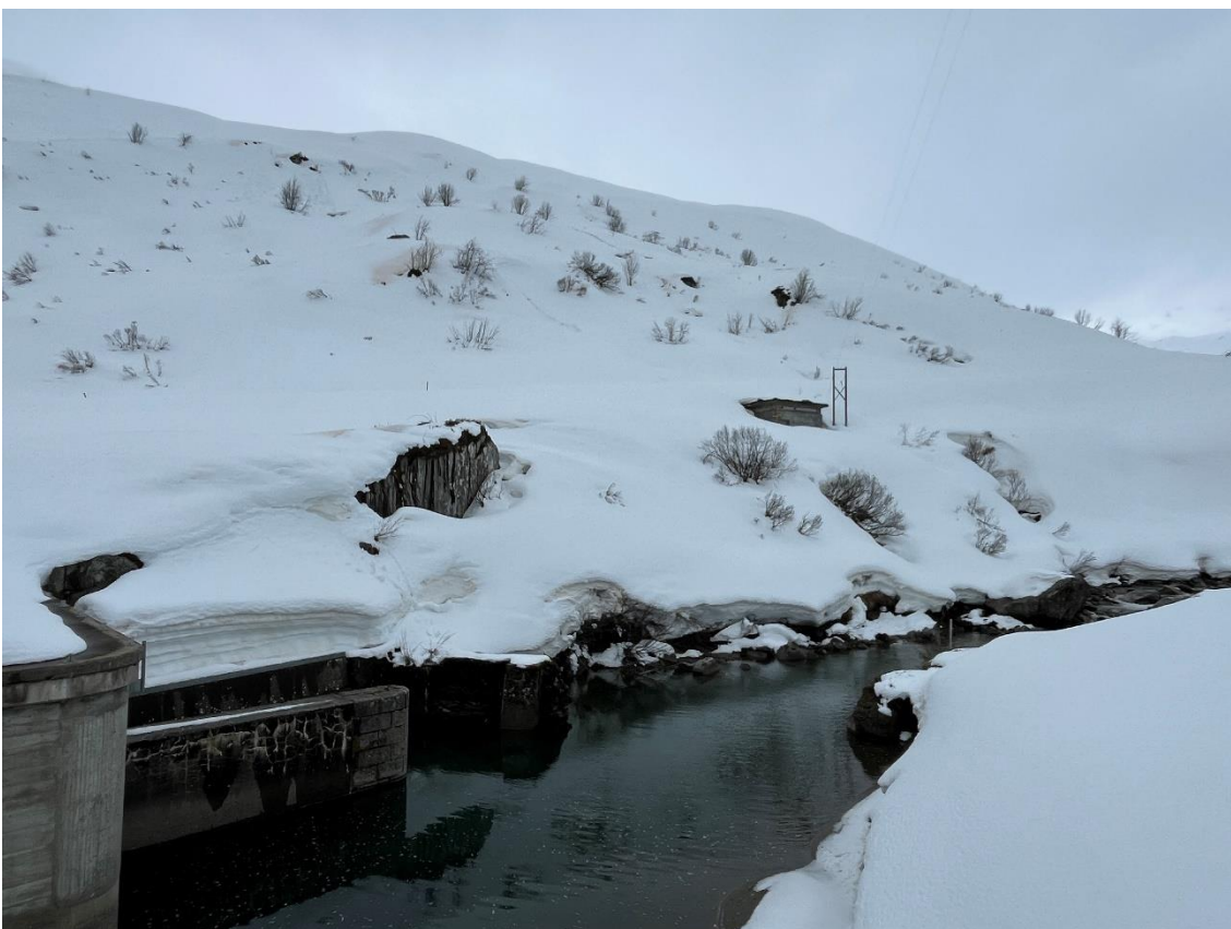
Wasserfassung Tiefenbach Bergseite Bild: Patrick Smit
