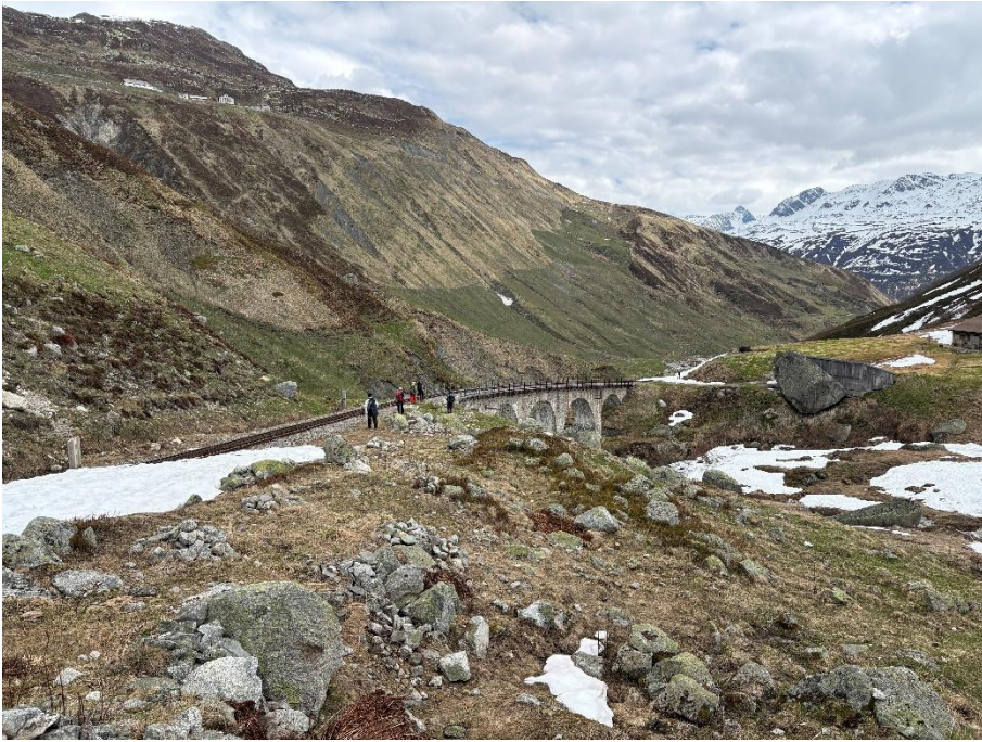
Steinstafelviadukt. Bild: Patrick Smit.
