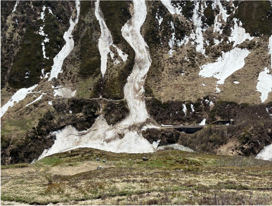
Die Lawinengegel an der Bergseite des Tunnels Altsenntumstafel II. Bild: Patrick Smit.
