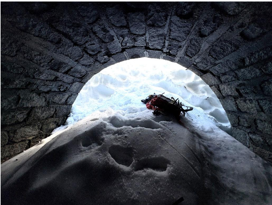
Blick vom Tunneltor Richtung Tunnelleingang.
