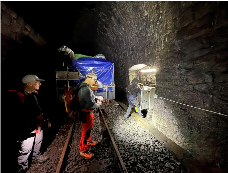
Inbetriebnahme der Stromversorgung der Tunnelbeleuchtung und Kontroll- ruf mit den neuen Telefonen in den Verteilkästen des Scheiteltunnels. Im Hintergrund ist der vierachsige Gü- terwagen mit den Signalen, Weichen- böcke und Perronausrüstungen der Bahnhöfe Muttbach-Belvédère und Furka abgestellt. Bild: Patrick Smit.
