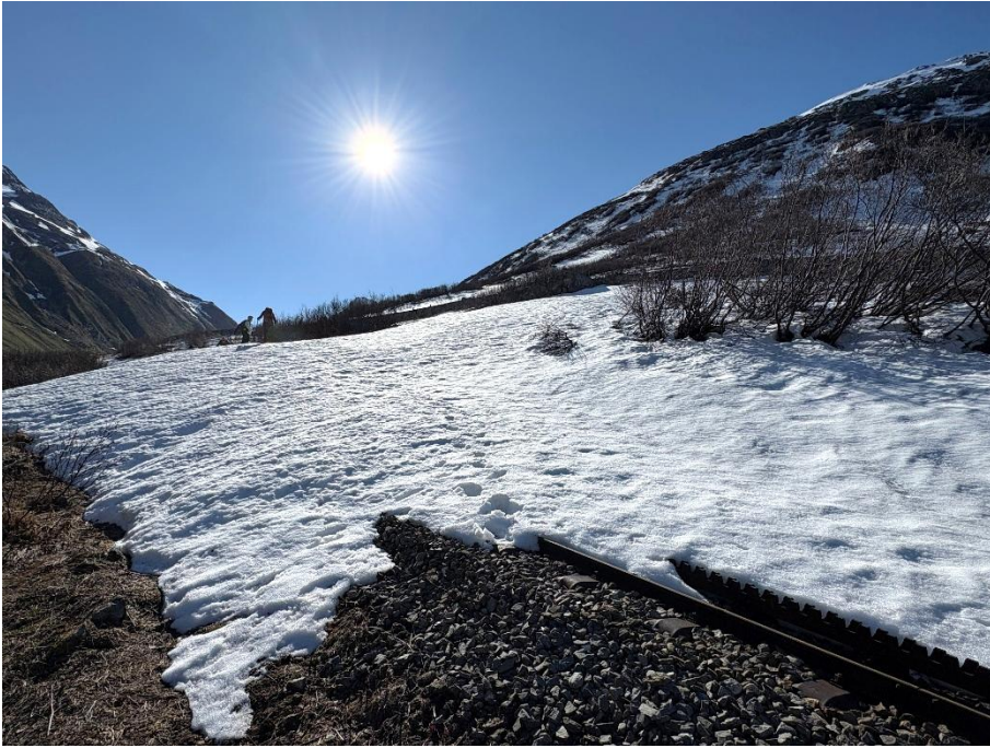
Unterhalb des Bahnübergangs Furkastrasse. Bild: Patrick Smit.
