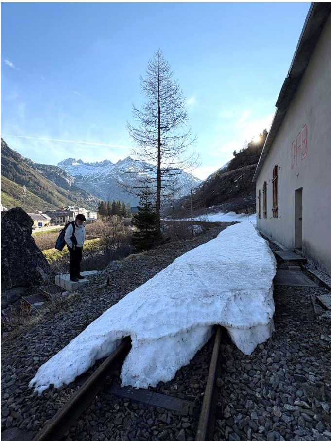
Bernhard Lang beäugt den Restschnee auf der Nordseite der Remise Gletsch.
