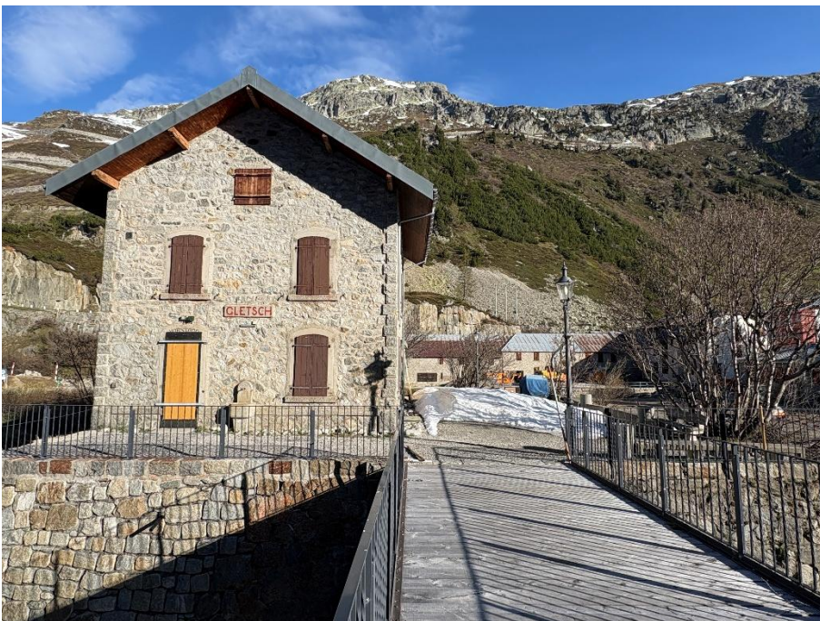
Das Bahnhofsgebäude von Gletsch. Bild: Patrick Smit.
