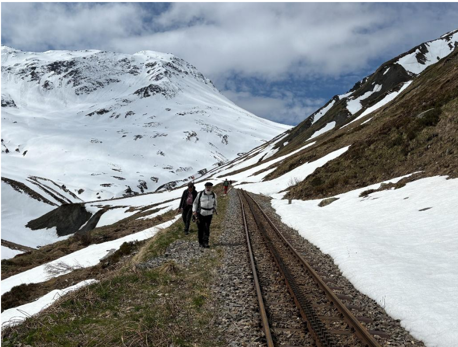
Zwischen Bahnhof Furka und Side- lenbachbrücke. Bild: Patrick Smit.
