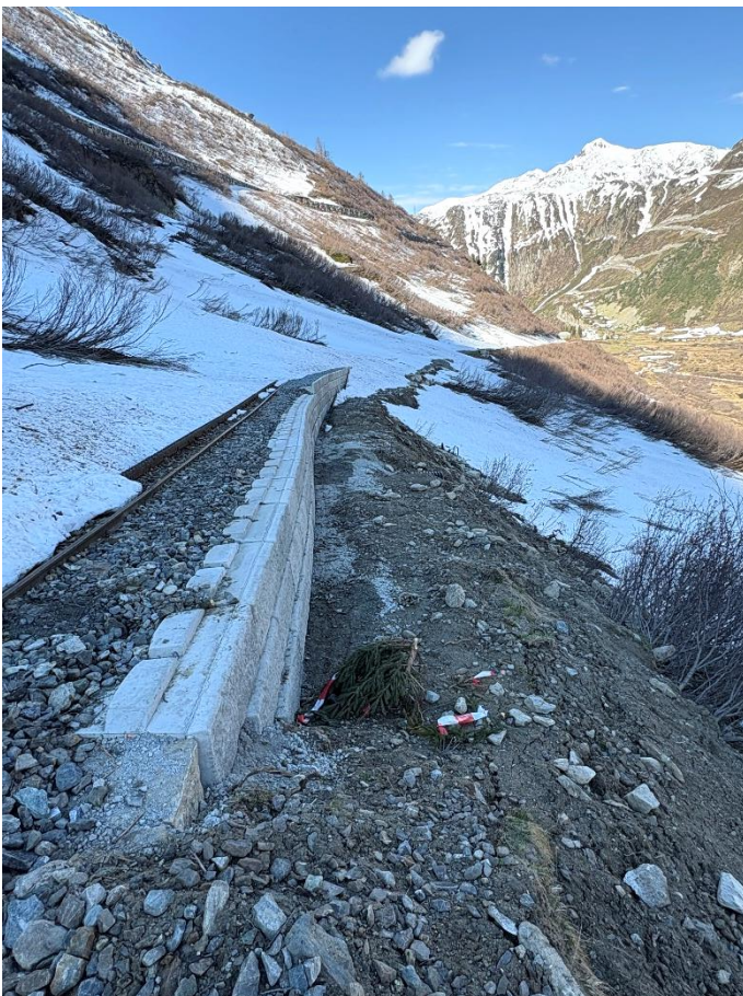
Die neue Stützmauer bei km 47,0. Bild: Patrick Smit.
