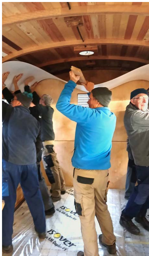
Foto von Werner Beer: AB 4463: Einsetzen der Deckenplatten
