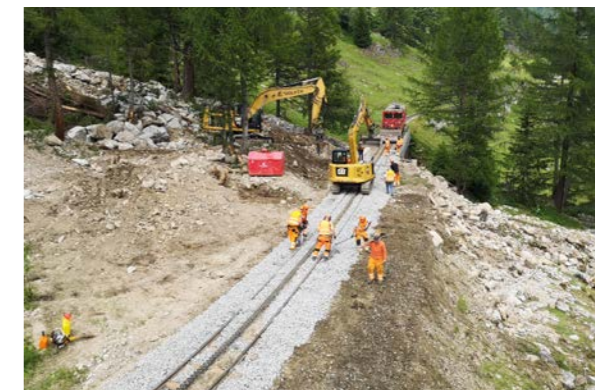
Bilder von Gian-David Fluri: (linke Seite) Gleiseinbau auf dem Viadukt Mässweid
