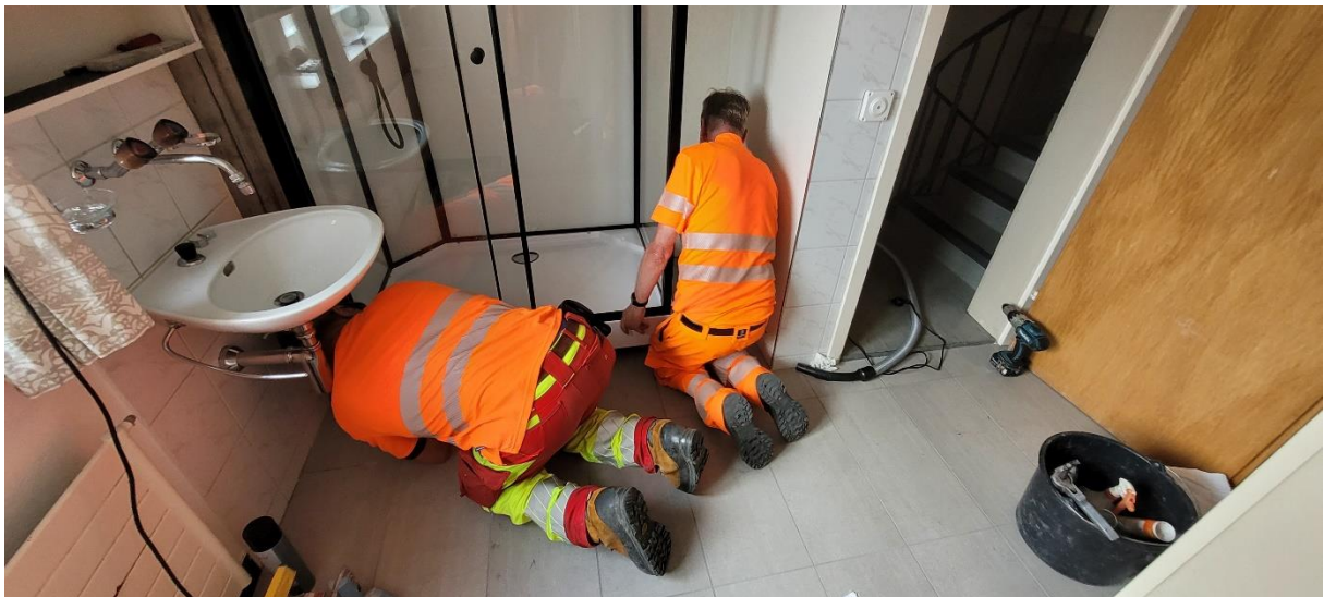
Installation der Dusche im Des Alpes.
