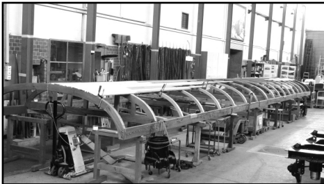
Das Dachgerippe mit den ersten probe-weise aufgelegten Täferbrettern
