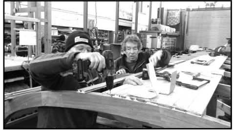
Fixierung der ersten Bretter
