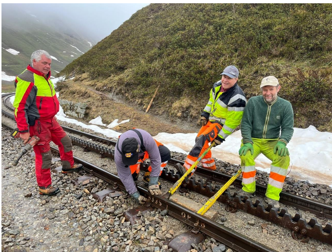
Von links: Beat Suter, Daniel Ernst, Marcel Schild und Ruedi Schwarz beim Korrigieren der Höhenlage der Zahnstange zwischen Tiefenbach und Steinstafelviadukt, Bild: Patrick Smit
