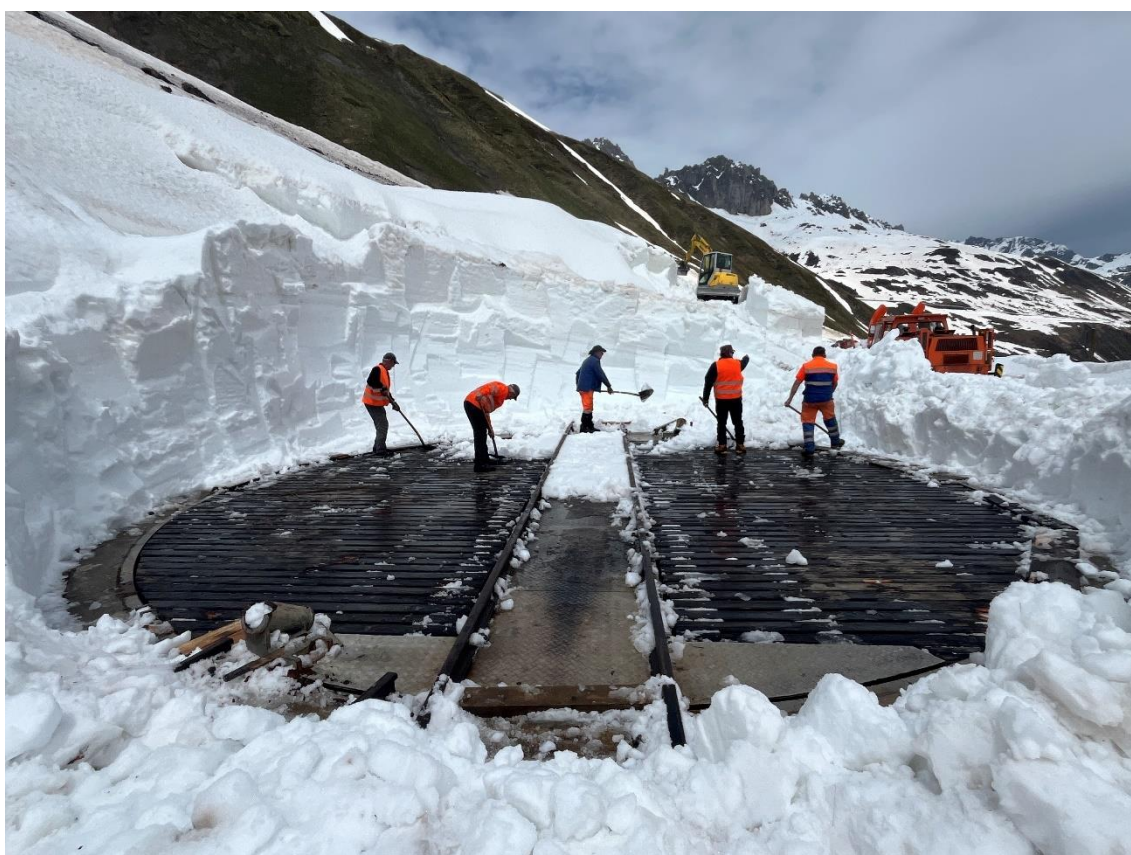
Freischaufeln der Drehscheibe des Bahnhofs Furka. Bild: Patrick Smit
