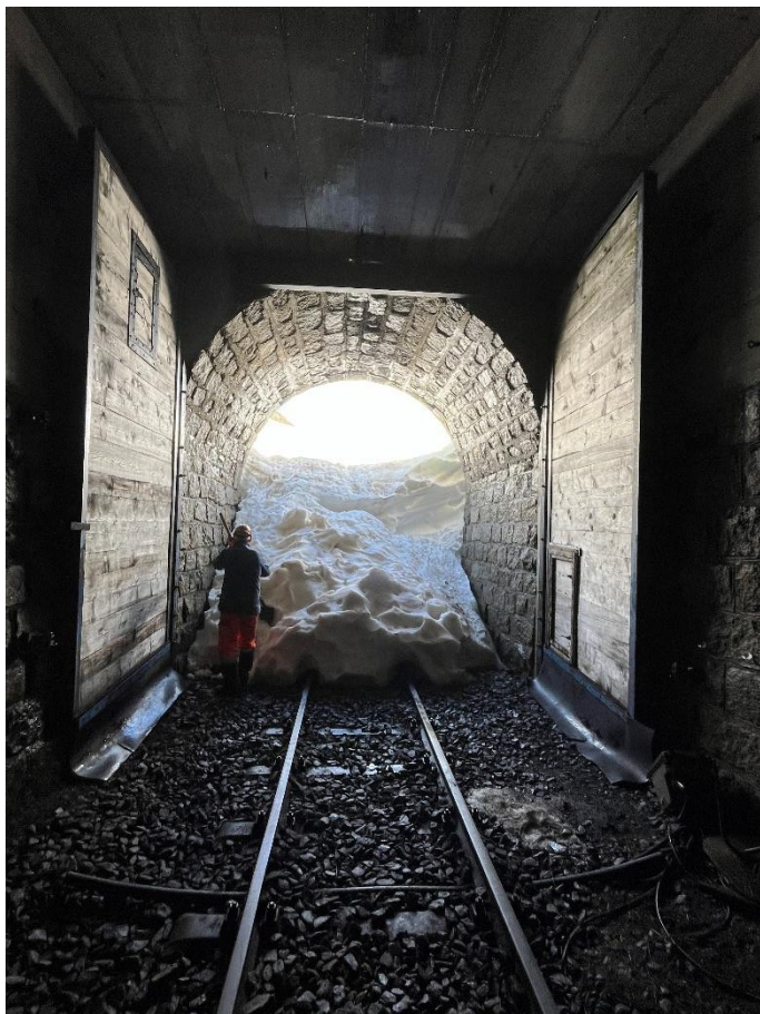
Das Westportal des Scheiteltunnels nach Öffnung der Tunnel Tore.
