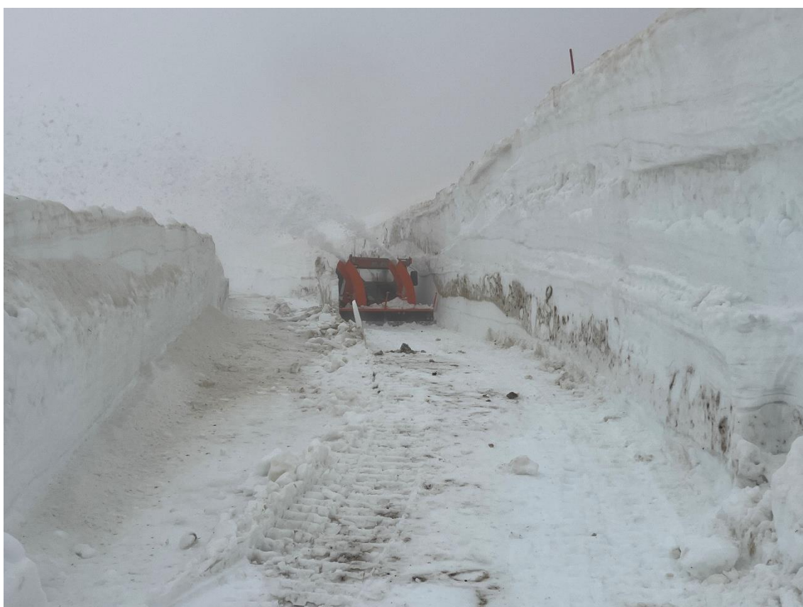
Stephan Stauber fräst einen weiteren Schnitt im stark vereisten Lawinenschnee kurz vor dem Bahnhof Furka. Bild: Patrick Smit
