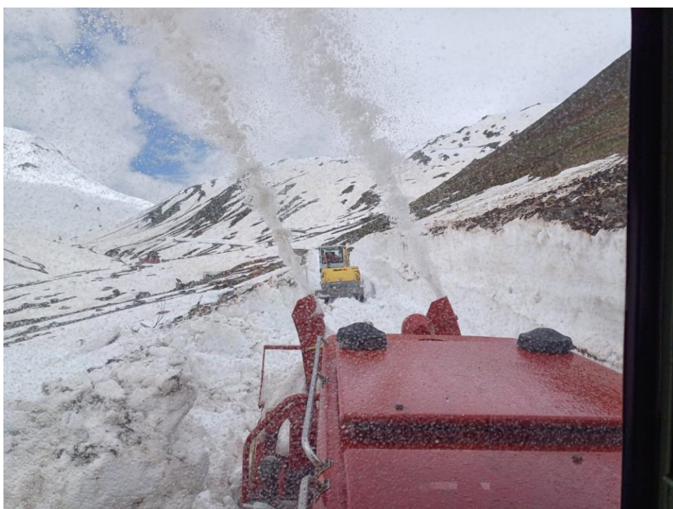
Der Bagger bricht den hartgepressten und vereisten Schnee auf, der anschliessend mit der HGm 51 mit Anbaufräse geräumt wird. Bild: Ernst Demonti
