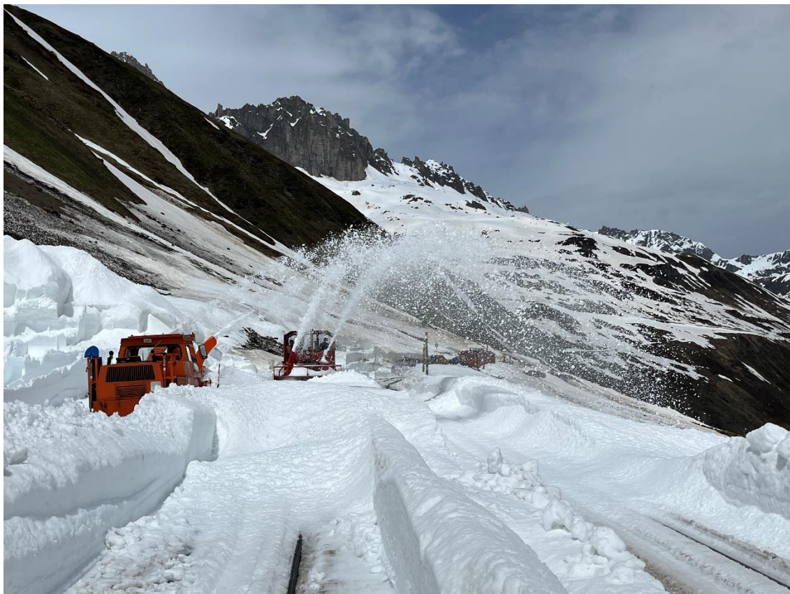
Die HGM 51 mit Anbaufräse räumt laufend den Schnee von den Gleisen, welche die INTRAC Raupenfräsen während der Räumung des Vorplatzes und der «Empore» des Bahnhofs Furka auf die Gleise geworfen haben.
