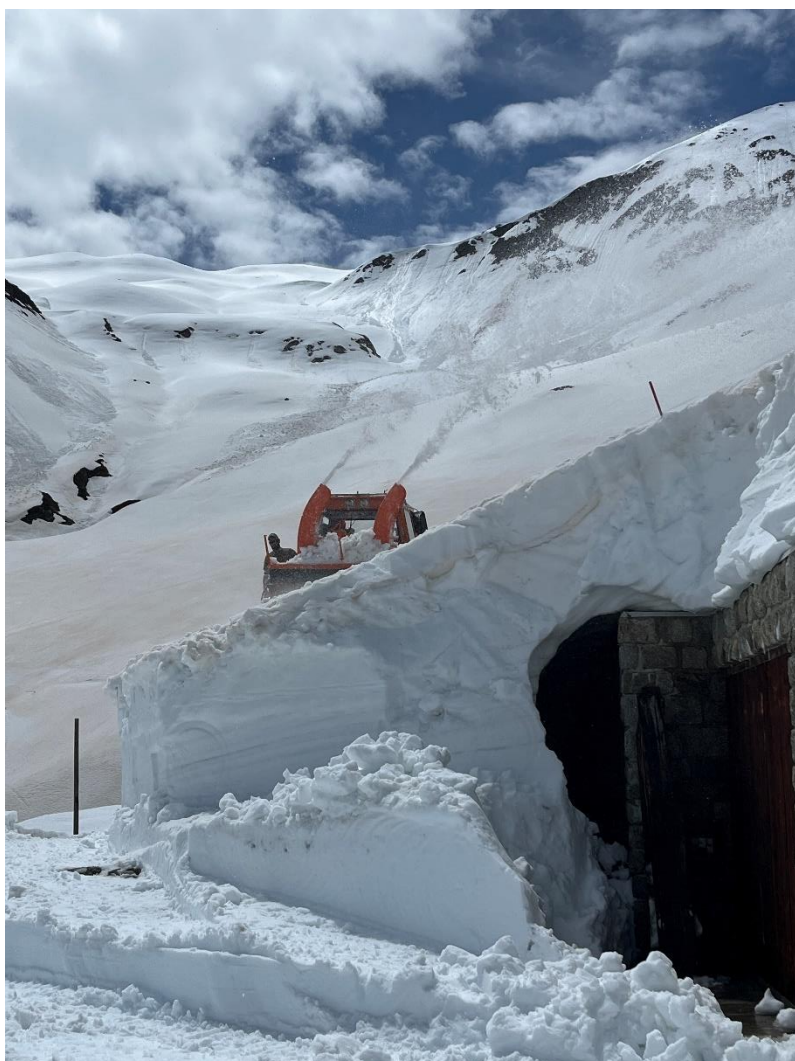
Der Hohlraum zwischen Relaisgebäude, die Neigung, die Platzverhältnisse und der wenig tragfähige Frühjahrsschnee macht die Räumung auf der «Empore» anspruchsvoll.
