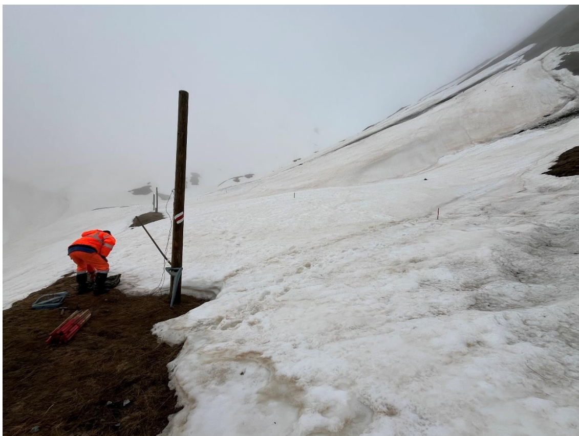
Mit dem Messgerät sucht der Vermessungstrupp die Kante der Drehscheibe und das bergseitige Stumpengleis. Die Kante und die Gleisachse werden anschließend mit Holzpflocken markiert. Bild: Patrick Smit
