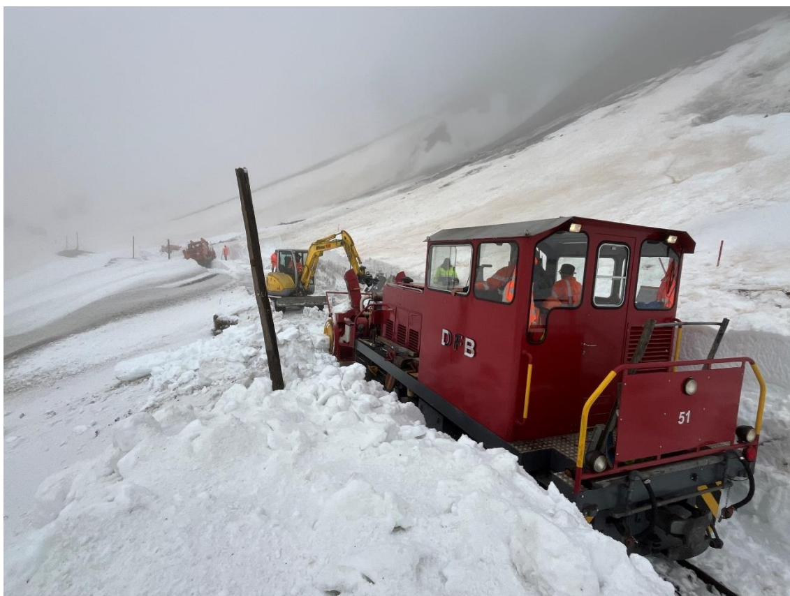
Der Schneeräumungs-Tross erreicht den Bahnhof Furka.
