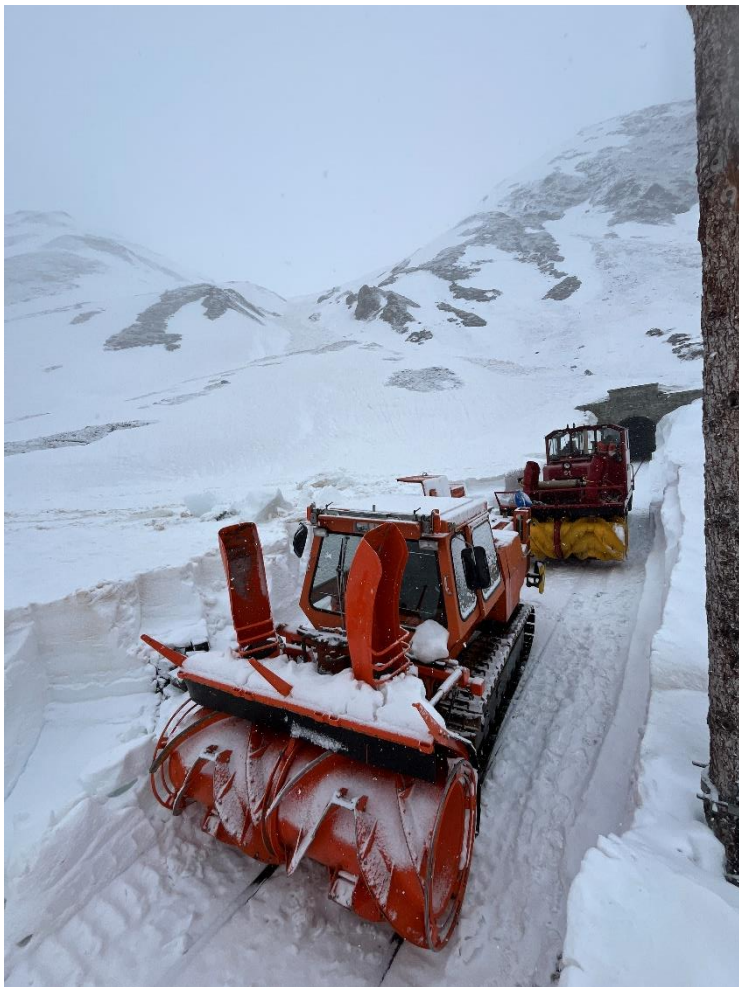
Bei stürmischem Schneefall machen die Maschinen in Muttbach-Belvédère die INTRAC Rau- penfräsen und den Bagger betriebsbereit.
