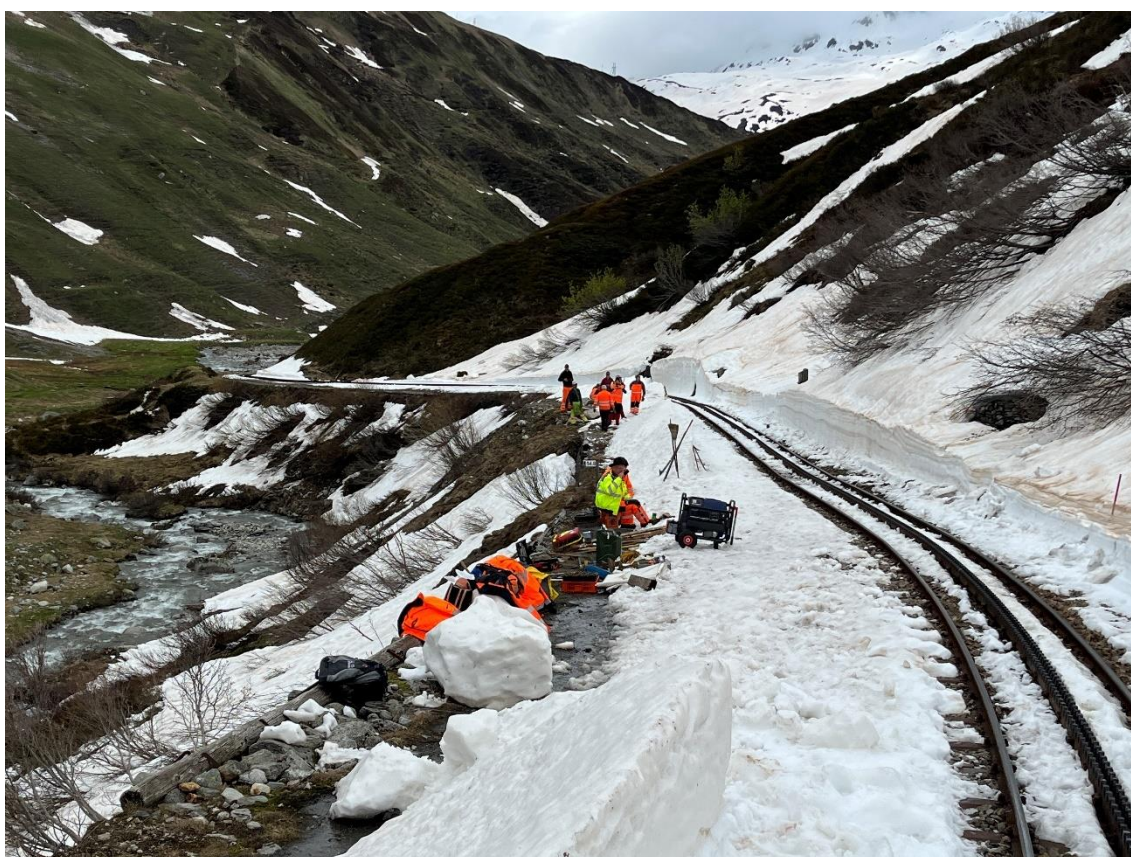
Die Gleissanierungsgruppe wartet im Fluchraum die Durchfahrt des Bauzuges zwischen Tiefenbach und Steinstafelviadukt ab.
