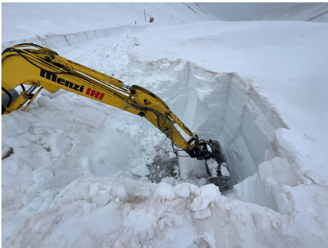
In 3 m Tiefe finden wir die Fundamente des Tastenkastens des Bahnhofs Muttbach-Belvédère. Bild: Patrick Smit
