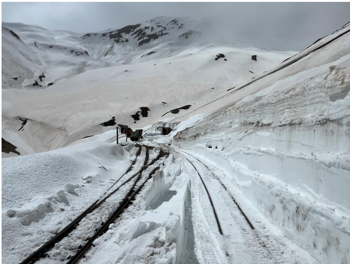
Blick von der Einfahrweiche Seite Realp des Bahnhofs Furka gegen Westen. Regen und Sonne wechseln sich ab.
