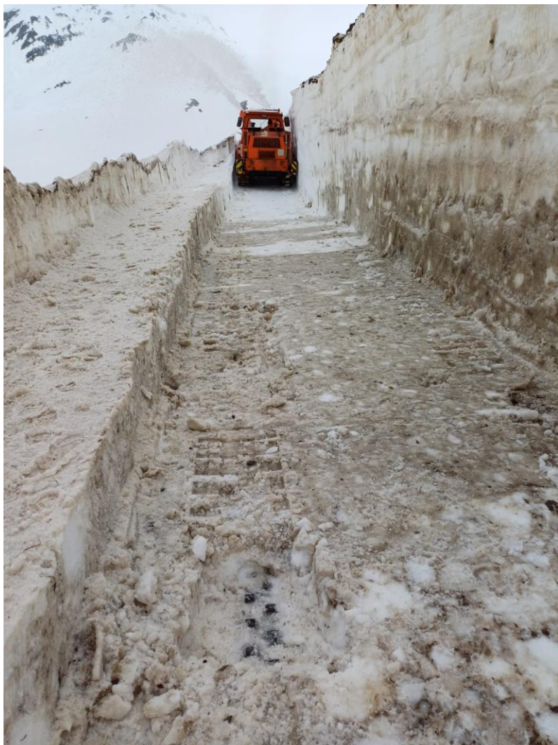
Auf Schienen- und Zahnstangenhöhe ist der hartgepresste Schnee stark vereist – eine Herausforderung für Mensch und Material. Bild: Ernst Demonti
