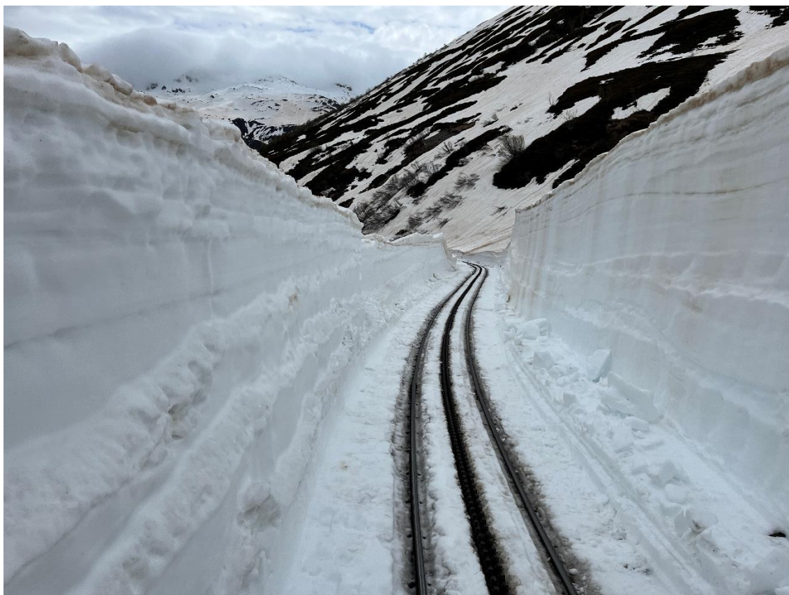
Der obere Teil der Arbeitsstelle der Gleissanierungsgruppe unterhalb des Steinstafelviadukts.
