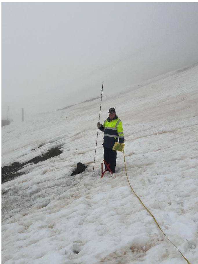
Bruno Zimmermann (im Bild), Andreas Simmen und Patrick Smit messen die exakte Lage der Zahnstangeneinfahrt Furka ein. Dies ist wichtig, weil weder die INTRAC Raupenfräse noch der Bagger und die HGm 51 mit Anbaufräse im Bereich der Weichen und Zahnstangeneinfahrten tief fräsen bzw. graben dürfen. Bild: Patrick Smit
