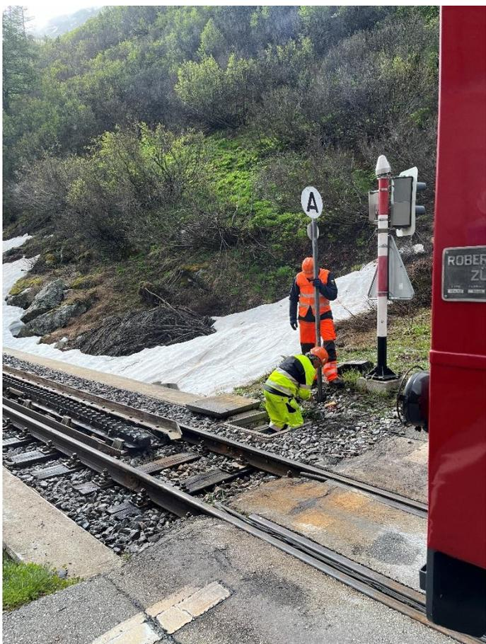
Beat Mühlemann und Werner Spahni montieren das A/E-Signal bei der bergseitigen Zahnstangeneinfahrt von Gletsch.
