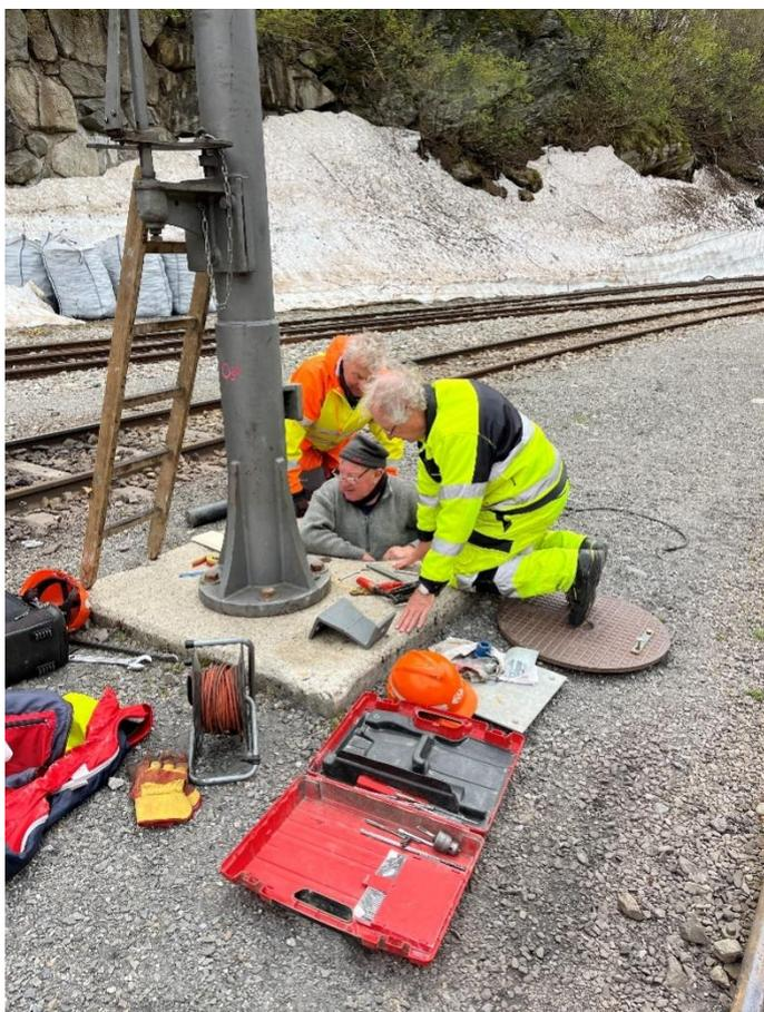
Die Montage des Wasserkrans 1 und der neuen Spindel hat viel Zeit gekostet, weil der Schieber zuerst gerichtet werden musste.
