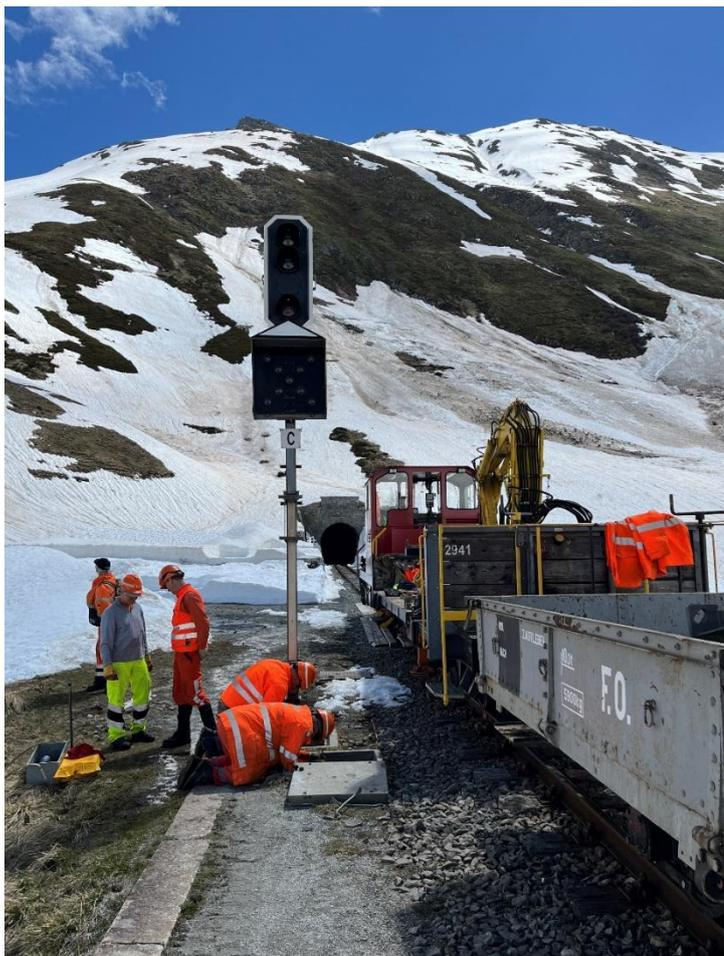
Montage des Ausfahrsignals des Bahnhofs Muttbach-Belvédère.
