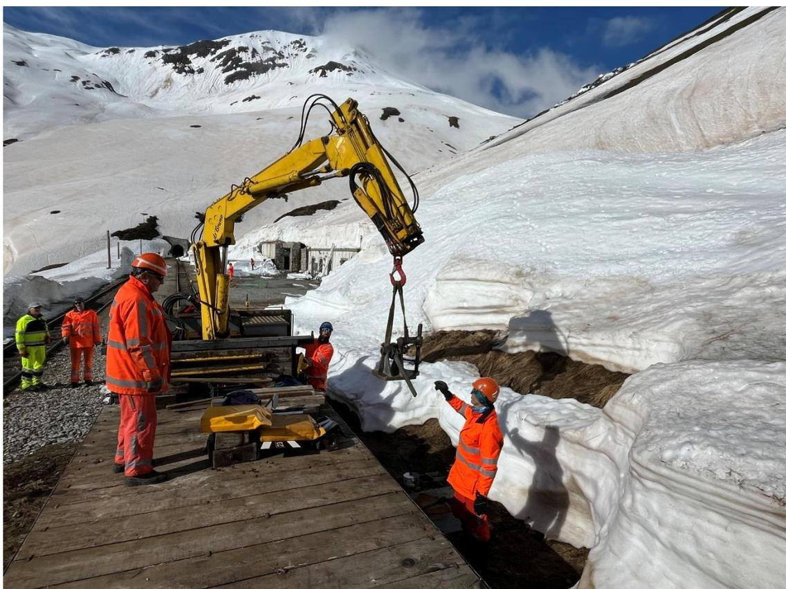
Montage des reparierten Weichenhebels, der während der Schneeräumung demoliert wurde. Zukünftig werden alle Weichenhebel im Herbst demontiert.
