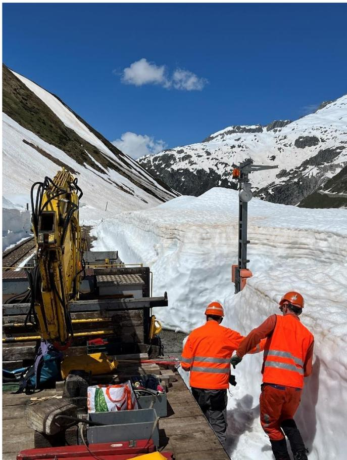
Der Tastenkasten des Bahnhofs Muttbach-Belvédère ist montiert.
