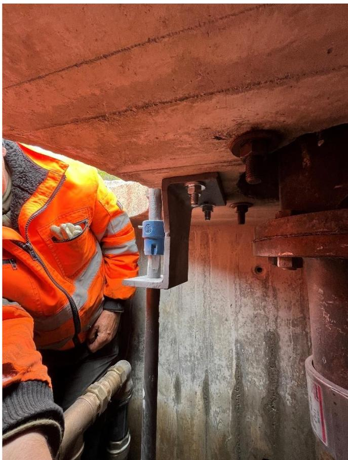
Dank der neuen Konstruktion muss beim Einwintern nur noch die Spindel oberhalb der blauen Muffe ausgebaut werden.
