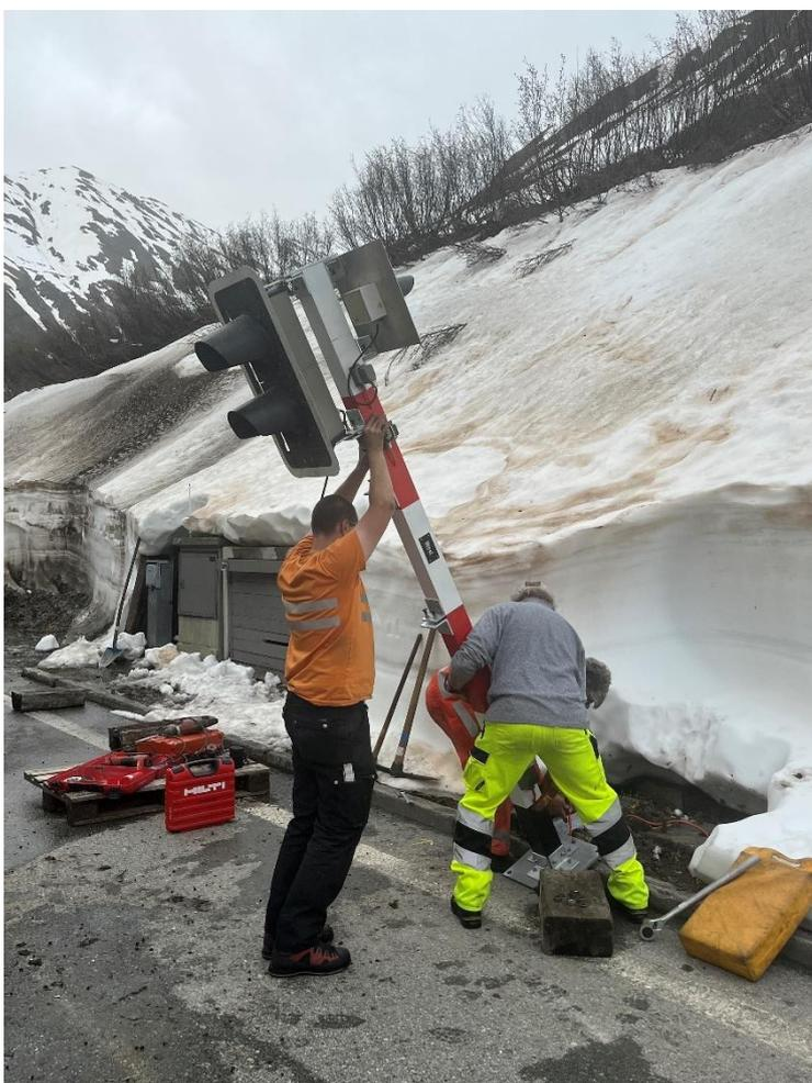
Dank den neuen Signalanlagen ist für deren Montage und Demontage kein Kran mehr notwendig.
