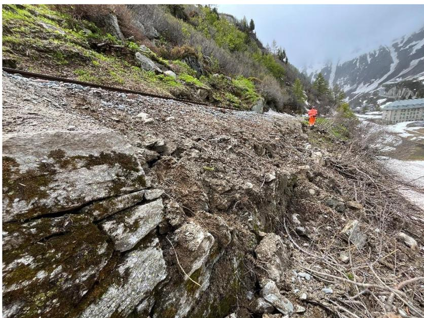
Oberhalb der bergseitigen Zahnstangeneinfahrt von Gletsch hat eine Lawine eine Trockenmauer des Bahntrasses beschädigt.
