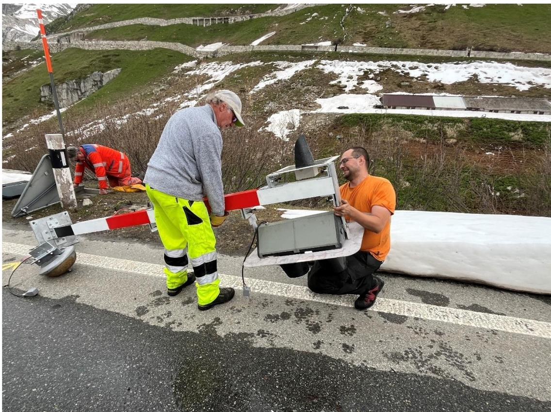
Die Signale können dank Schnappverschlüssen und -Steckern einfach und schnell montiert und demontiert werden.
