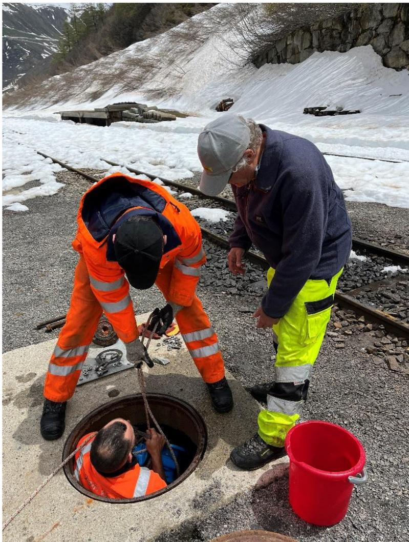
Einbau des revidierten Schiebers des Wasserkrans 1 des Bahnhofs Gletsch.
