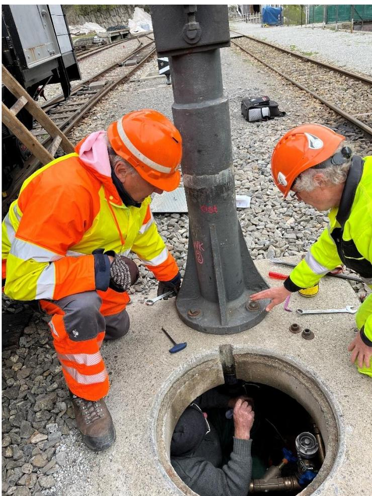
Montage des Wasserkrans 2 und der neuen Spindel.
