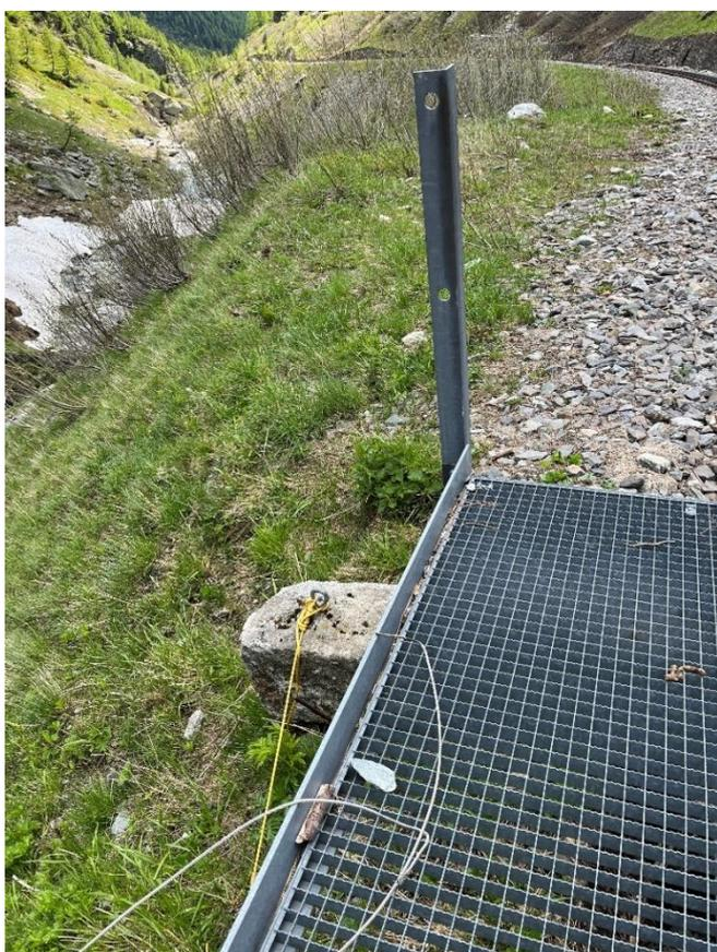
Leider können wir die Führungsseile des Geländers des Rottenviadukts nicht abspannen, weil die Abspannvorrichtungen unauffindbar sind. Auch nach telefonischen Abklärungen mit einem Kollegen des Einwinterungsteams bleiben die Abspannvorrichtungen unauffindbar. Da die Drahtseile nicht abgespannt sind, fädeln wir die Drahtseile wieder aus den Geländerpfosten aus.
