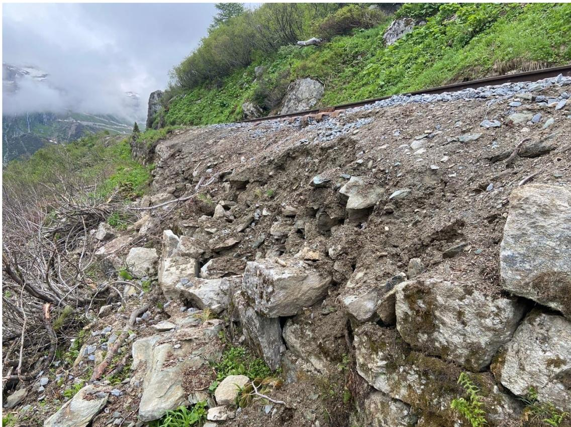
Die von einer Lawine beschädigte Trockenmauer oberhalb der bergseitigen Zahnstangeneinfahrt Gletsch.
