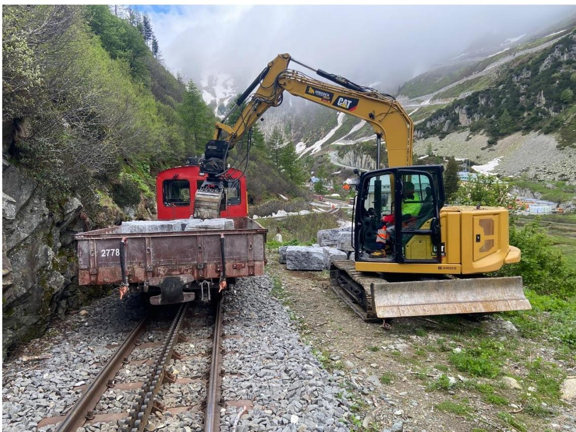
Tobias Hardmeier führt die Granitquader für die Reparatur der beschädigten Trockenmauer auf. Mit einem Mietbagger platziert Beat Suter die Steinquader.
