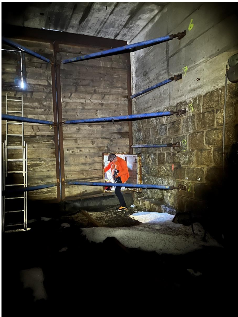
Andreas Kleeb zwingt sich durch den Durchlass im westlichen Tunneltor des Scheiteltunnels.
