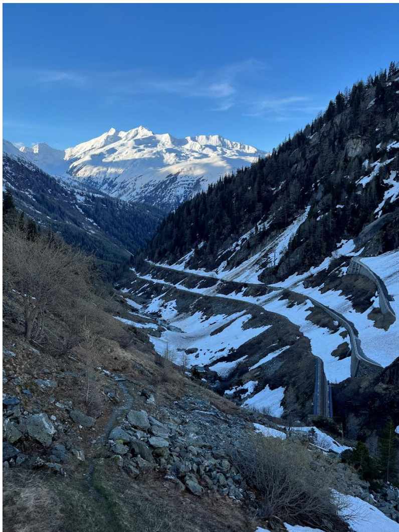
Blick von der Spitzkehre der Kantonsstrasse beim bergseitigen Portal des Kehrtunnels in die Rottenschlucht. Die schneebedeckten Gipfelregionen des Blashorns, Mittagorns und Pizzo Gallina in der Morgensonne. Bild: Patrick Smit
