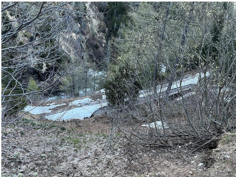
Das Lehnenviadukt Eischflüe. Bild: Patrick Smit
