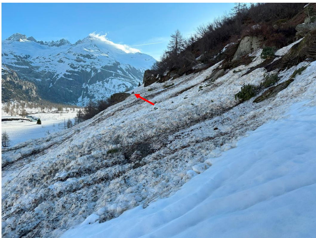
Die Lawine im Bereich des Bahntrasses. Patrick Smit steht hinter dem Lawinenkegel. Bild: Andreas Kleeb
