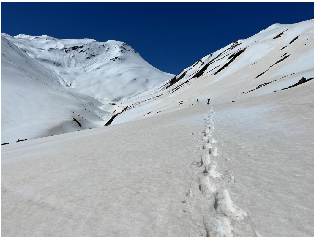
Blick Richtung Furka- pass. Das Bahntrasse liegt hier unter ca. 2 m Schnee.
