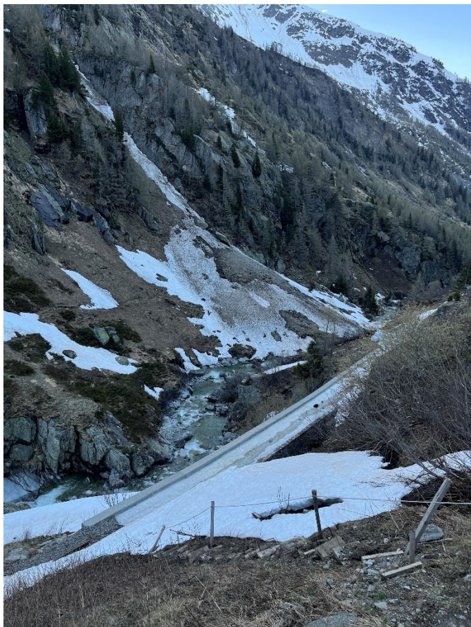
Das Lehnenviadukt Mässweid und der Zugang zur Arbeitsstelle.
