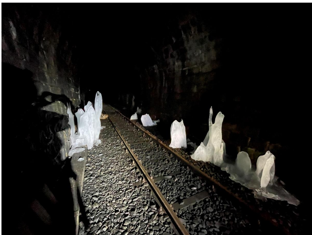
Eis-Stalagmiten im Bereich des Westportal des Scheiteltunnels.
