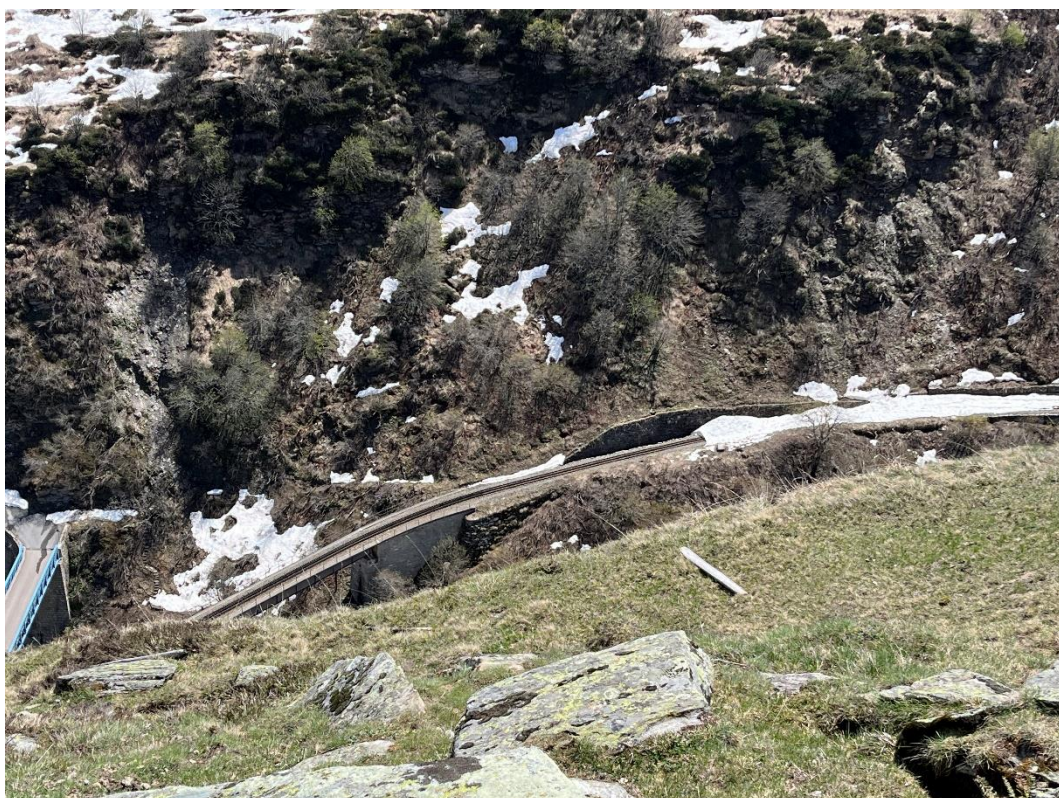
Bis kurz oberhalb der Wilerbrücke ist Bahnstrecke bereits geräumt.
