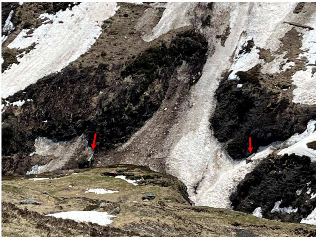
Der Lawinenkegel zwischen Tunnel 2 und Tunnel 3.
