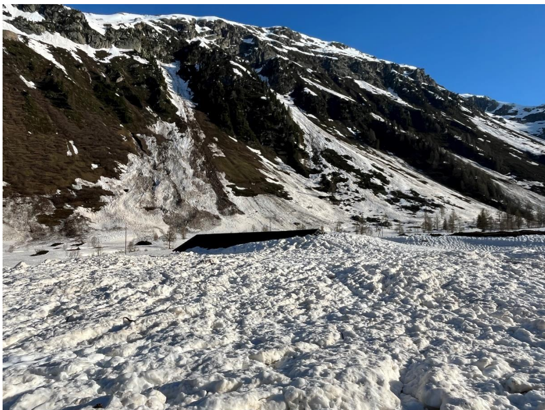
Der Stall wurde von der Lawine zum Glück kaum beschädigt. Bild: Patrick Smit
