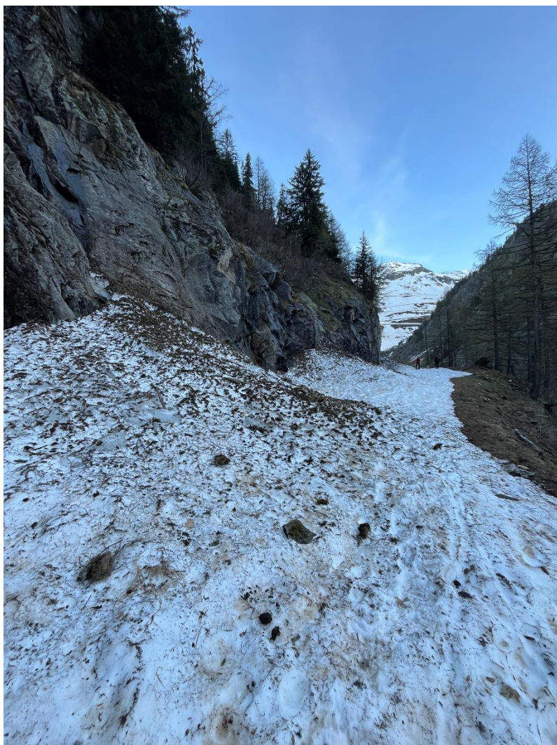
Die Kantonsstrasse oberhalb des Strassentunnels. Bild: Patrick Smit
