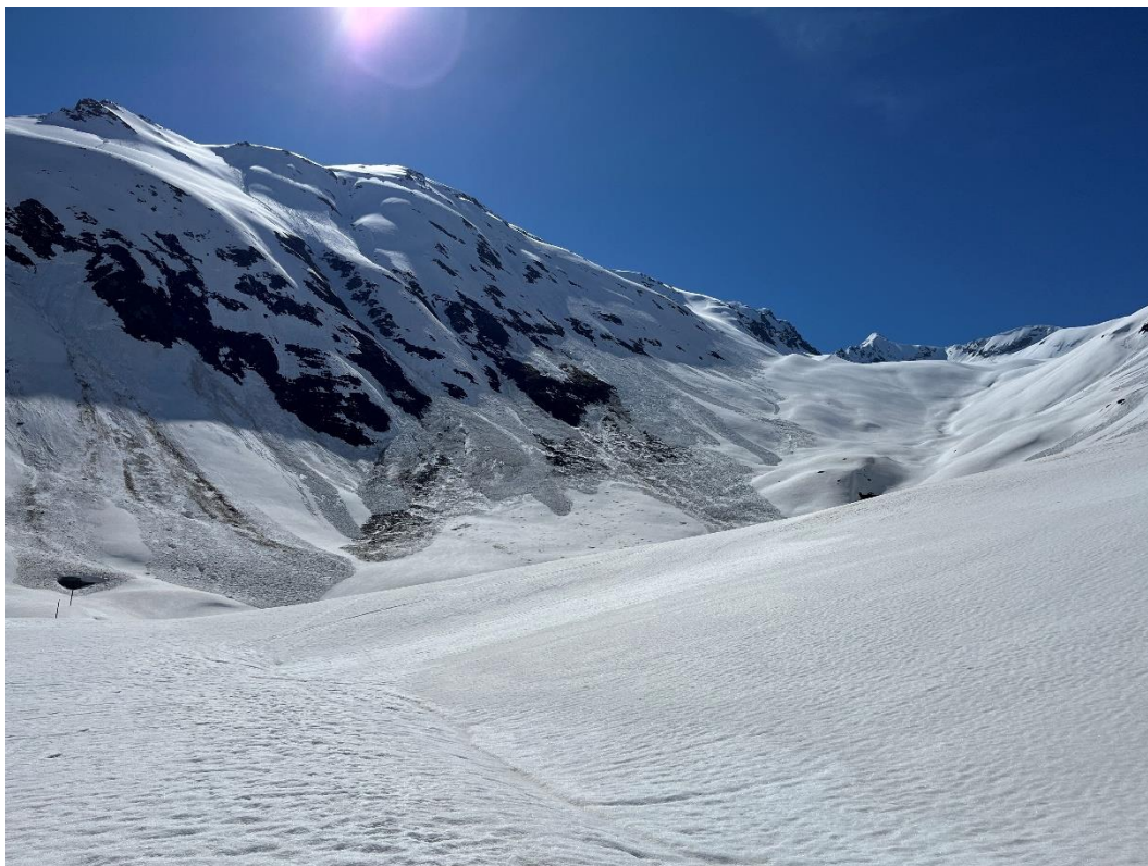
Blick vom Bahnhof Muttbach-Belvédère Richtung Muttenhörner. Am linken Bildrand ist im Schnee der oberste Bereich des Tunnelportals des Scheiteltunnels sichtbar.
