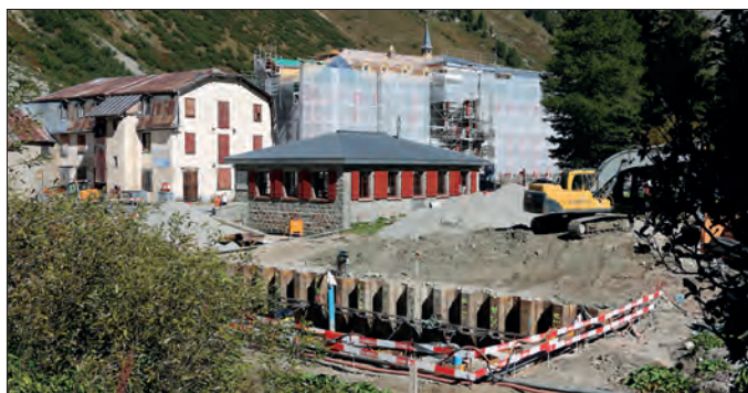
Bildmitte: Altes und bereits restauriertes Postgebäude mit InfoPoint und Toiletten. Im Vordergrund: Aushub für die dreistufige, unterirdisch angelegte Kläranlage (18.09.2025). Alle Fotos dieser Seite: Beat Moser (6)
