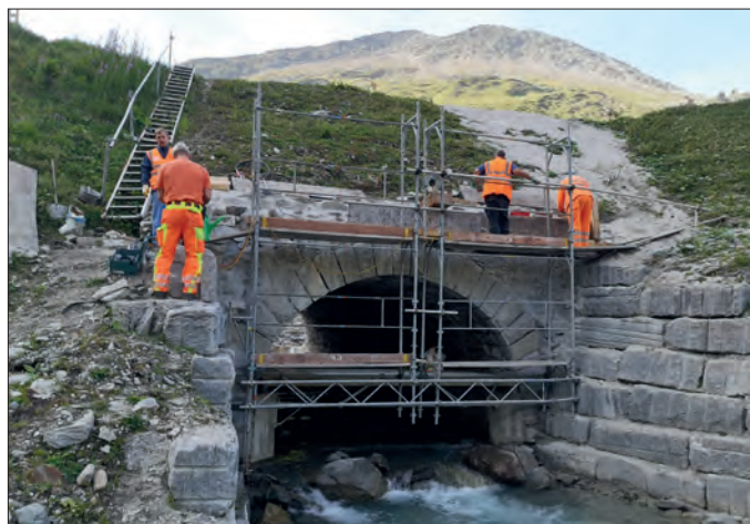
Fronarbeitseinsatz bei der Brückensanierung (August 2024)
