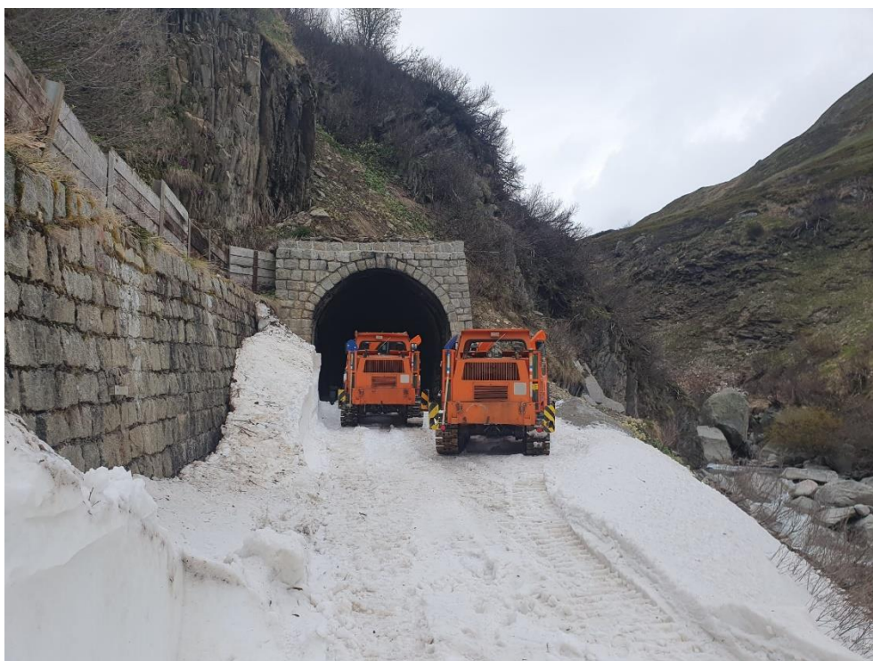
Die beiden INTRAC Raupenfräsen vor dem talseitigen Portal des Tunnels 3. Der Menzi Bagger ist im Tunnel abgestellt. Bild: Michael Bühler
