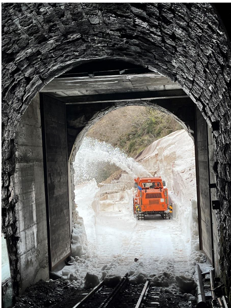
Stephan Stauber kämpft sich durch den stark vereisten und mit Dreck, Geröll und Vegeta- tion durchsetzten Lawinenschnee zwischen Tunnel 2 und Tunnel 3.
