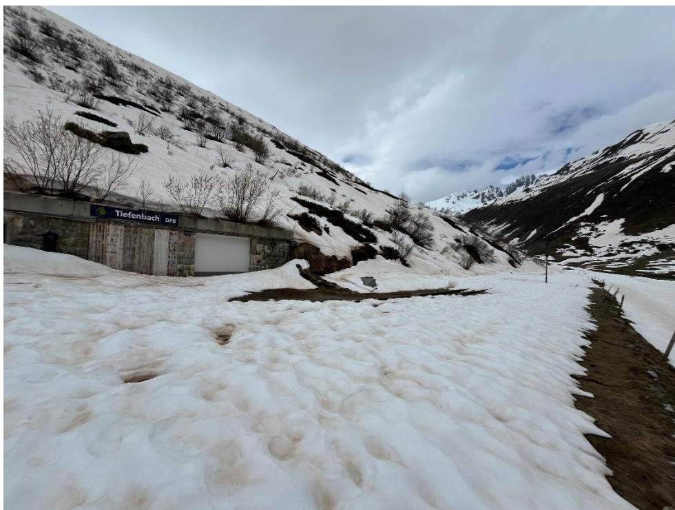
Das Gebäude des Bahnhofs Tiefenbach.
