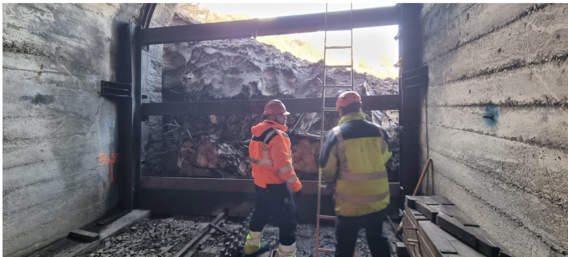
Pascal Rauber und Christoph Spinnler bereiten die Demontage der Doppel-T-Träger des bergseitigen Tors des Tunnels 3 vor. Bild: Hans-Ludwig Schneider
