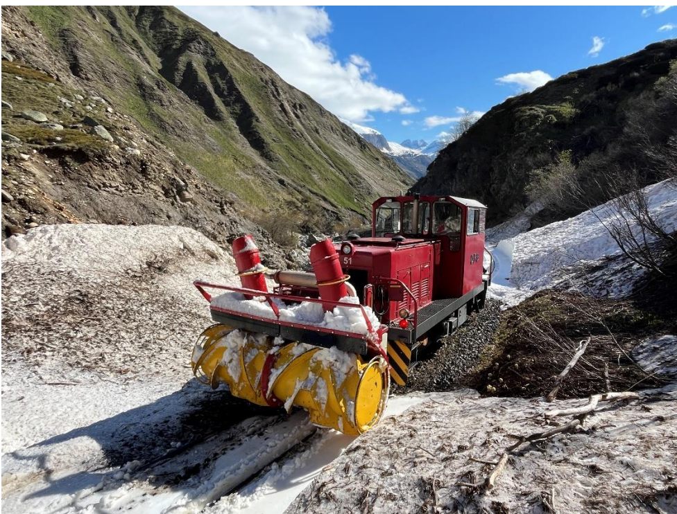
Die HGm 51 mit Anbaufräse kurz vor dem Tunnel 3.
