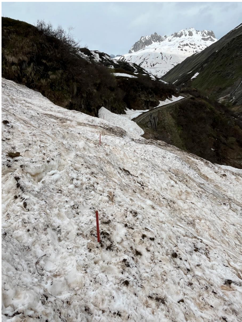
Auf dem ca. 5 m hohen Lawinenkegel vor dem bergseitigen Portal des Tunnels 1 haben die Vermesser Hans-Ludwig Schneider und Luc Wullschleger die Gleisachse bereits eingemessen und mit Holzpflocken markiert. Bild: Patrick Smit
