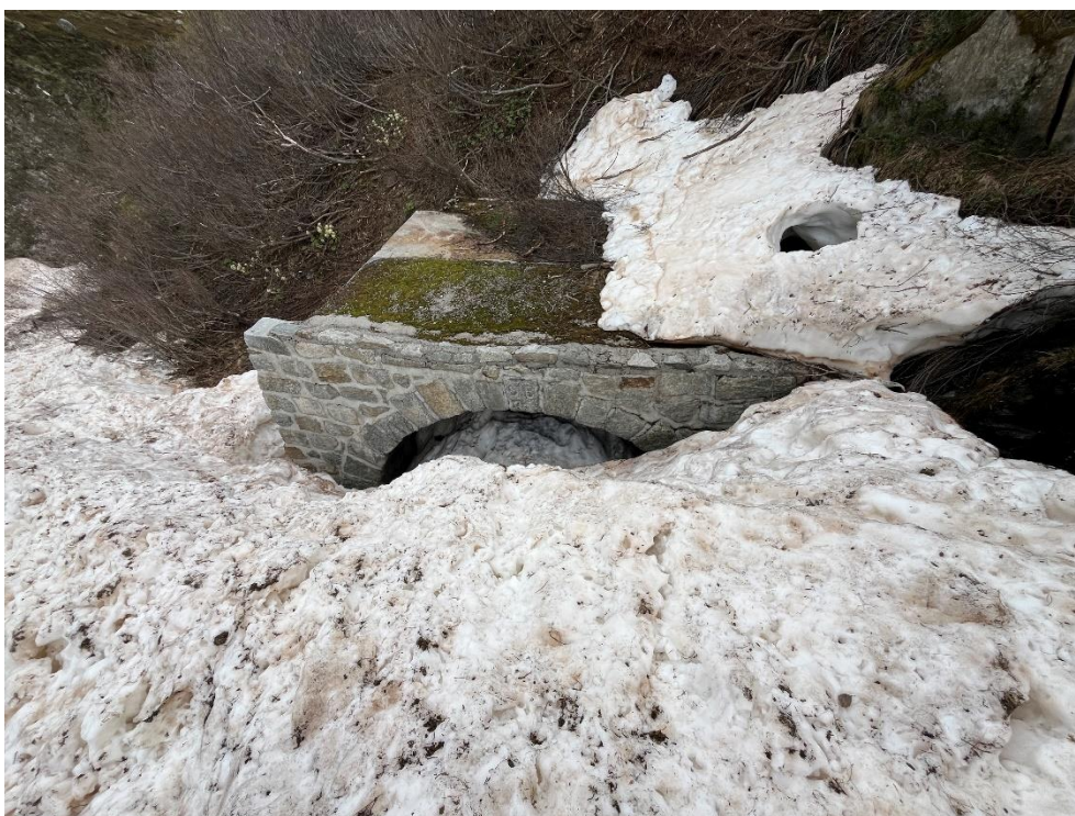
Das bergseitige Portal des Tunnels 1. Bild: Patrick Smit
