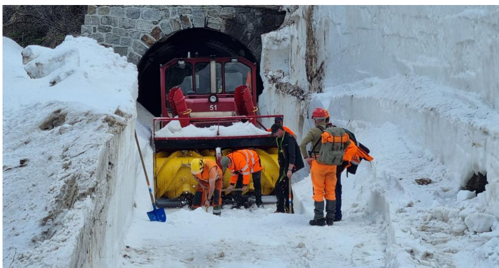
Auch hier sind die Schienen und Zahnstangen stark vereist. Bild: Hans-Ludwig Schneider
