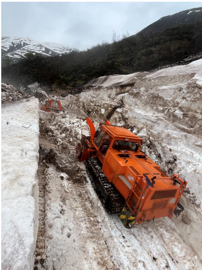
Zentimeter um Zentimeter «wühlen» sich die beiden INTRAC's zwischen Tunnel 3 und Tunnel 2 durch den «dreckigen» Lawinschnee.
