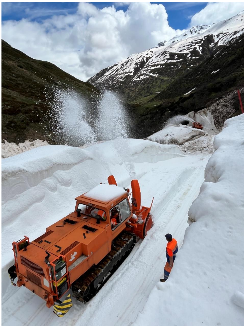
Während Thomas Holder und Michael Bühler den Lawinenkegel am talseitigen Portal des Tunnels 1 zu Leibe rücken ...
