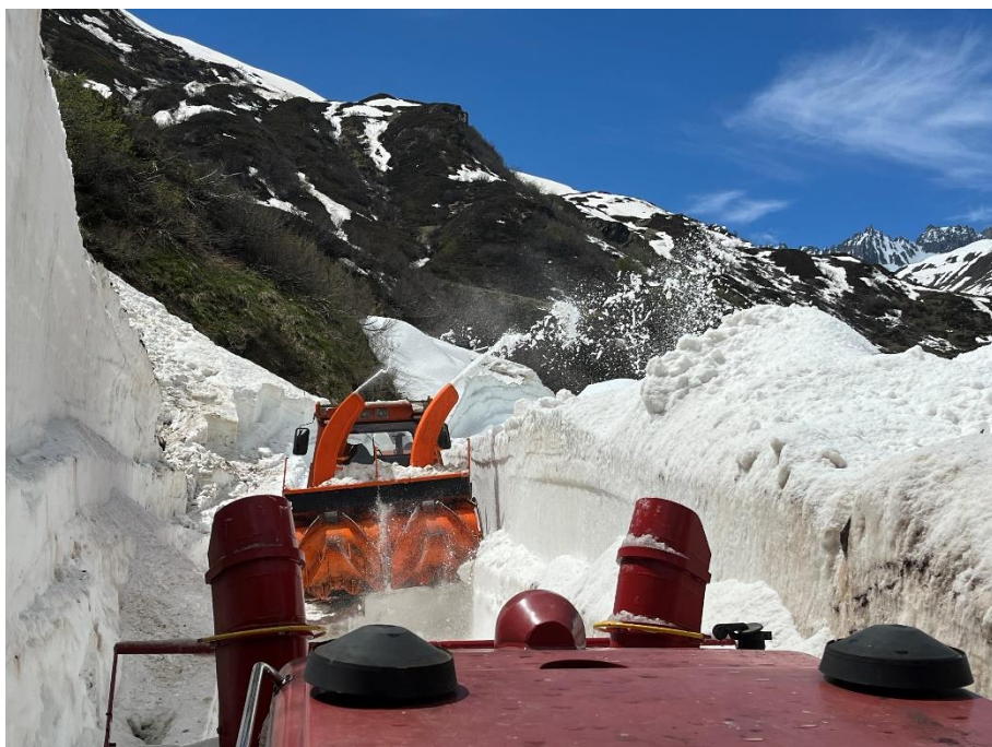
Eine INTRAC Raupenfräse und die HGM 51 mit Anbaufräse vor dem bergseitigen Portal des Tunnels 2. Bild: Patrick Smit
