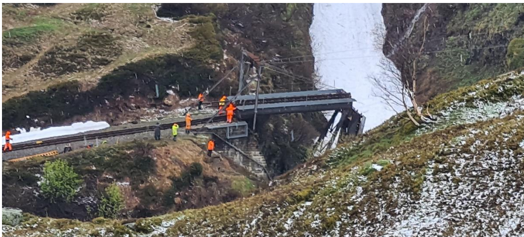
Blick von der Lawinenwache auf die Aktivitäten bei der Steffenbachbrücke.
