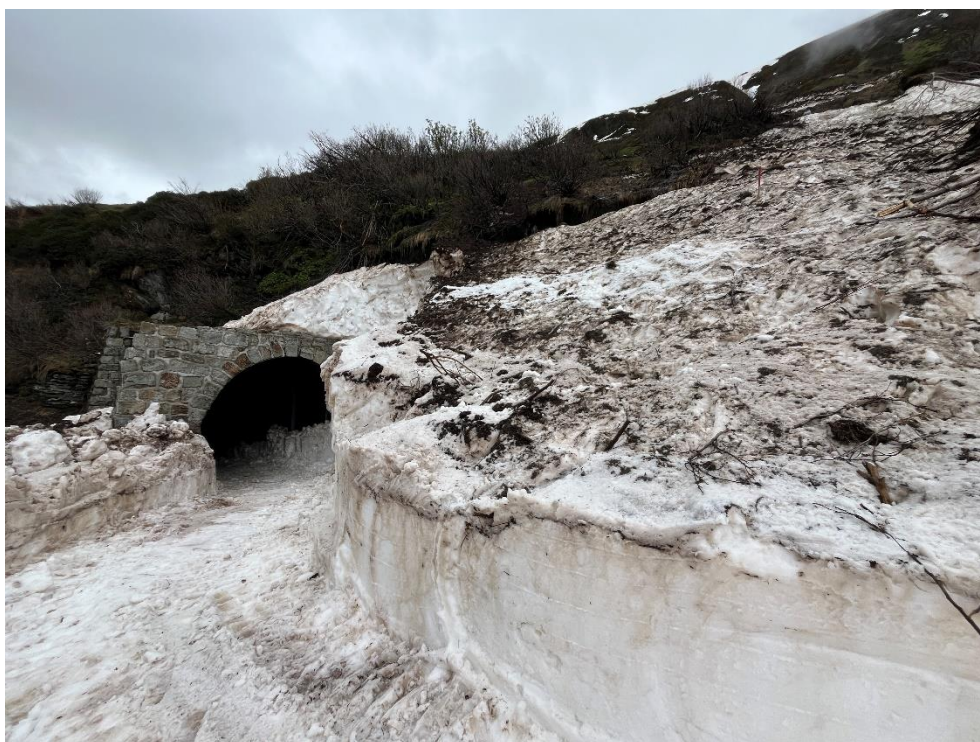
Während sich die HGM 51 mit Anbaufräse zwischen Tunnel 3 und Tunnel 2 durch den Lawinenschnee kämpft, hat sich die INTRAC Raupenfräse mit Unterstützung des Baggers aus dem bergseitigen Portal des Tunnels 2 gefräst. Bild: Patrick Smit
