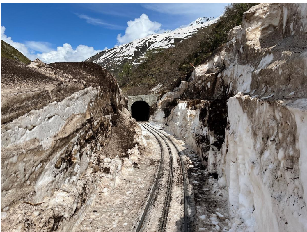
... dreckiger Schnee zwischen Tunnel 2 und Tunnel 3. Bild: Patrick Smit
