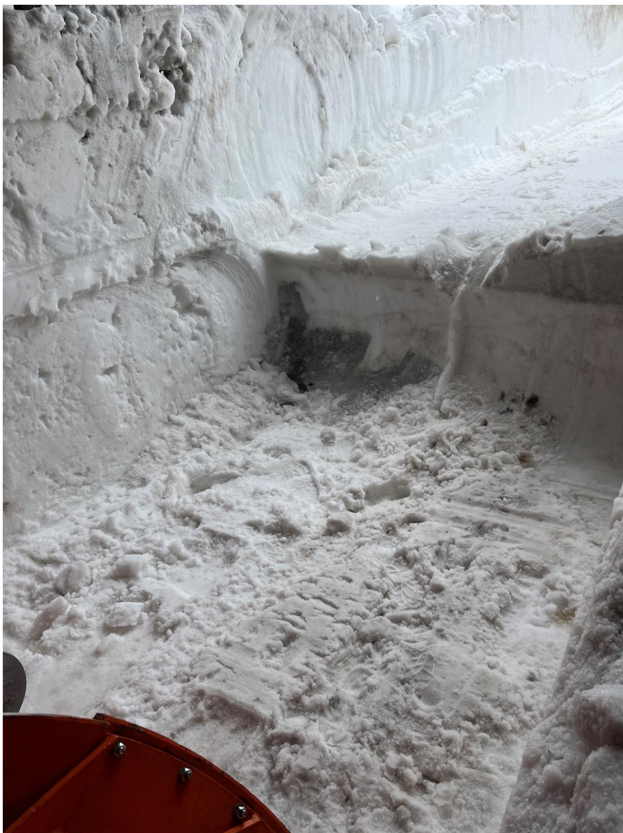
Blankes Eis vor dem bergseitigen Portal des Tunnels 1.
