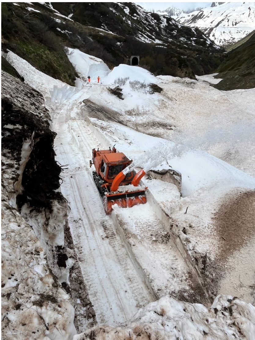
... fräst sich Stephan Stauber durch den Lawinenkegel am bergseitigen Portal des Tunnels 2.
