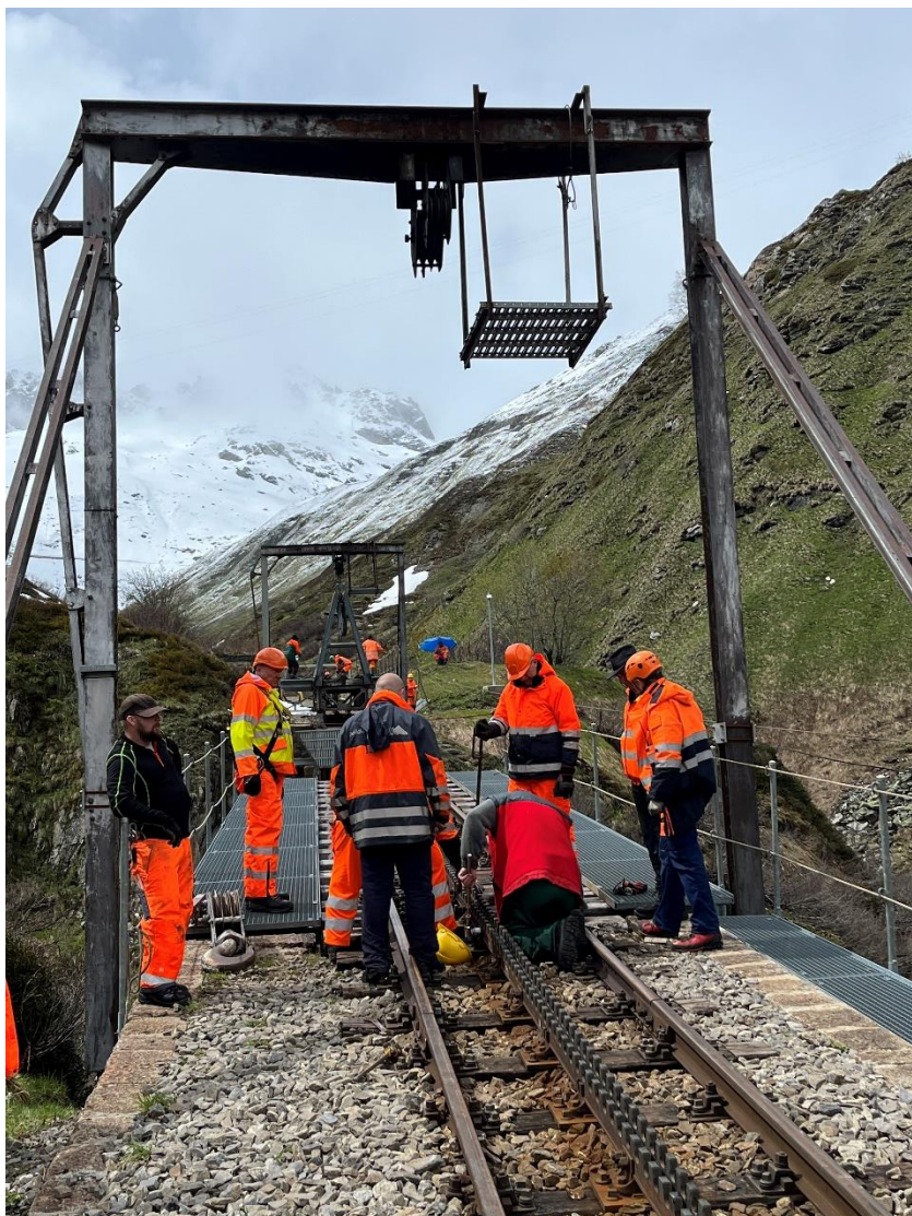
Während ein Team die Zahnstangen am talseitigen Brückenelement verschraubt... Bild: Patrick Smit
