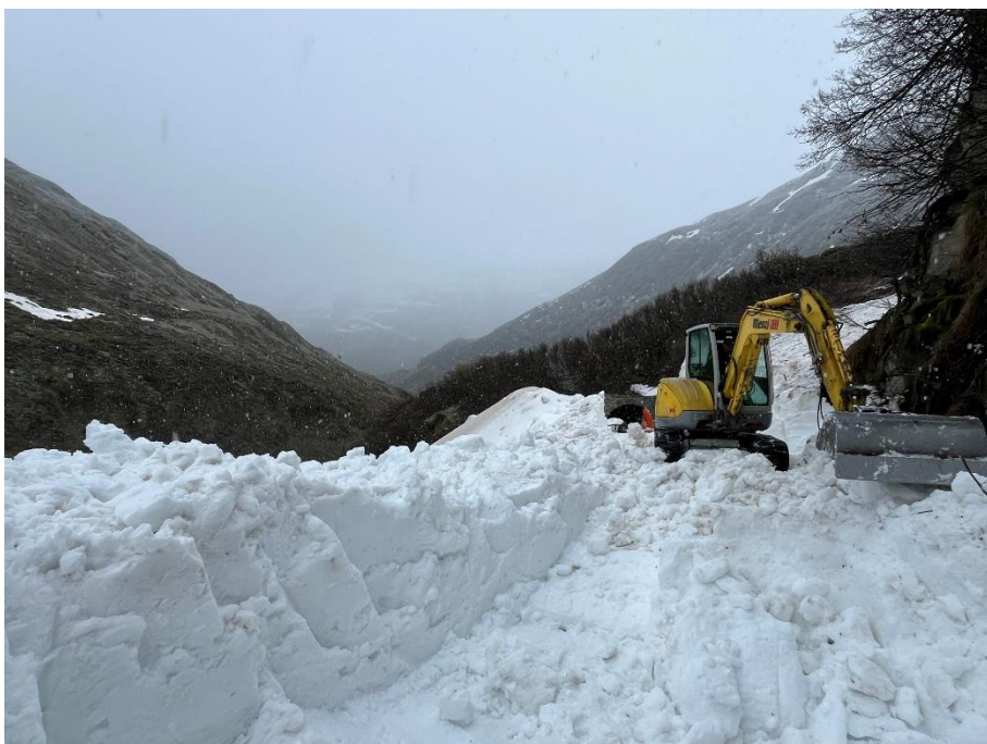
Alexander Briner baggert den Lawinschnee oberhalb des Tunnels 1 weg.
