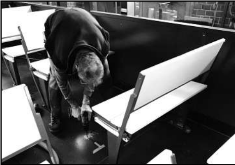
Einbau der Sitze mit Klapplehne
