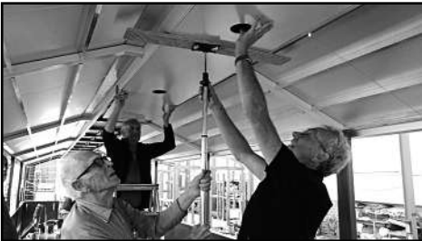
Wieder-einsetzen der Dachpaneele
