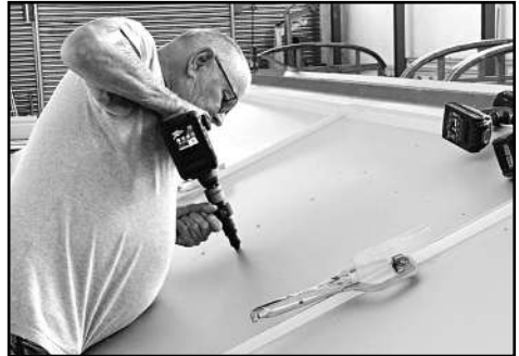
Viele Nieten halten die Dachbleche
