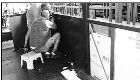
Montage der Innenwandplatten
