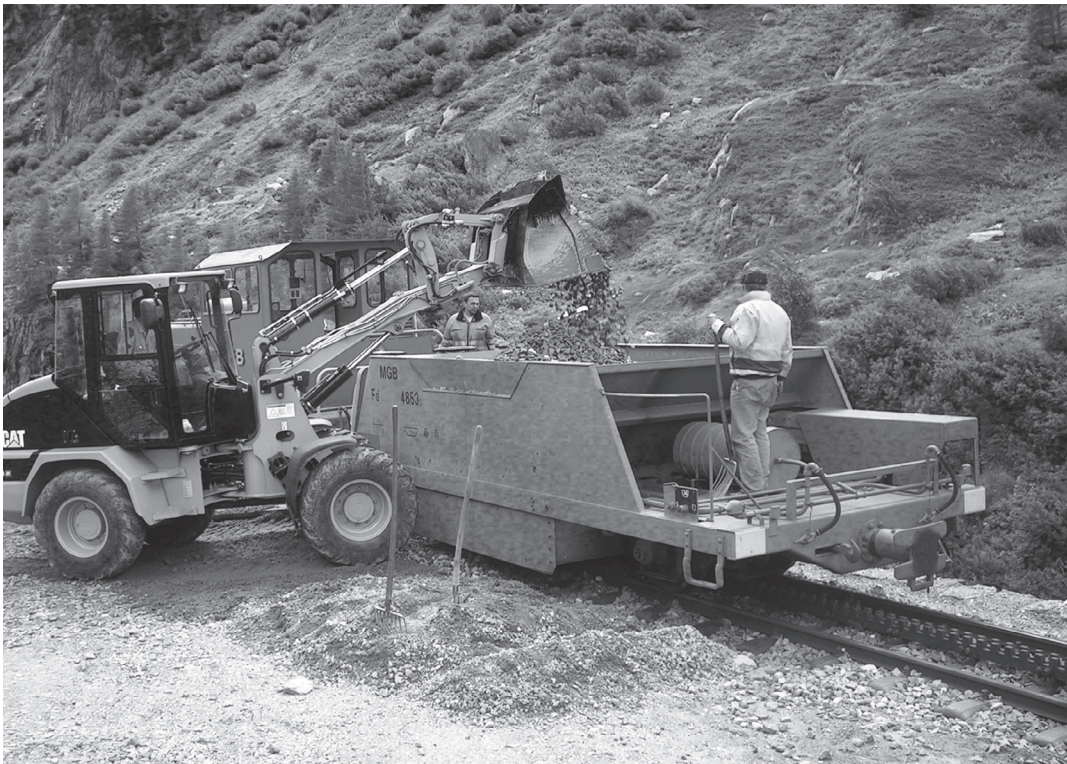
Schotterverlad unterhalb Gletsch
