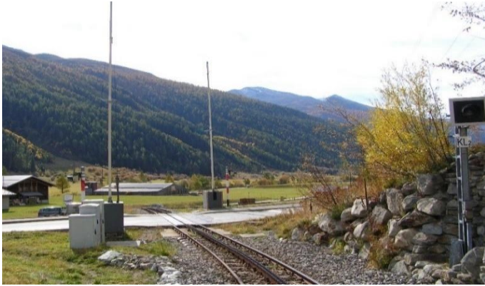
Bahnübergang Bogen Oberwald
