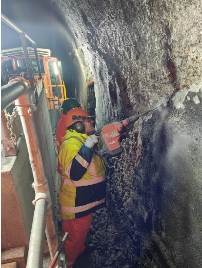
Bild 2 Abspitzen des alten Betons im FST
