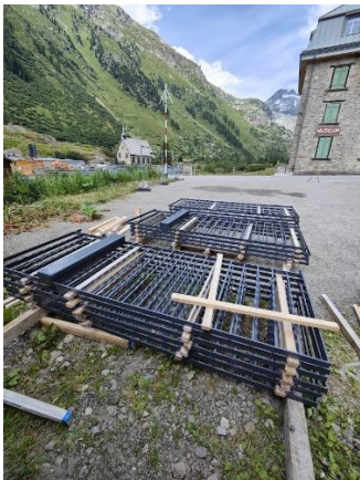
Bild 3 Alles fertig zum Einbau
