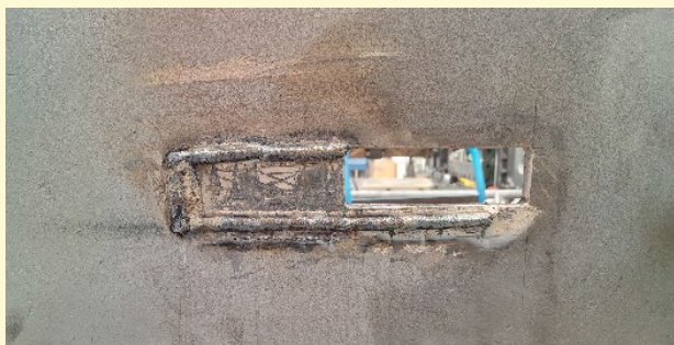
Das eingeschweisste Blech vor dem Verschleifen.
