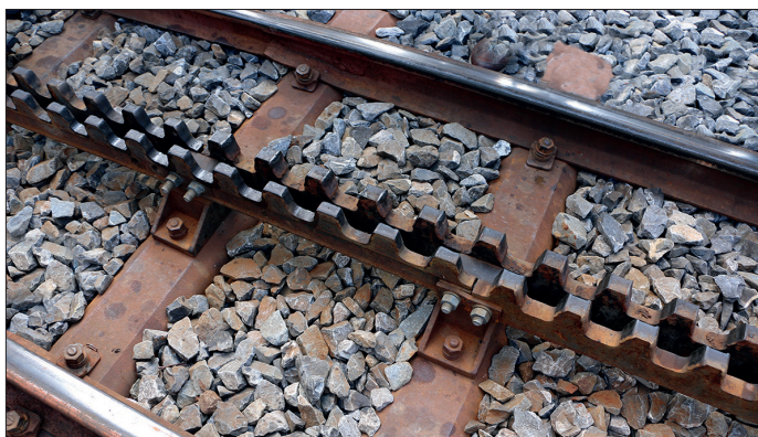
Oberhalb von Gletsch ersetzen wir u.a. die über 100-jährigen Zahnstangen (links im Bild). Foto: Beat Moser
