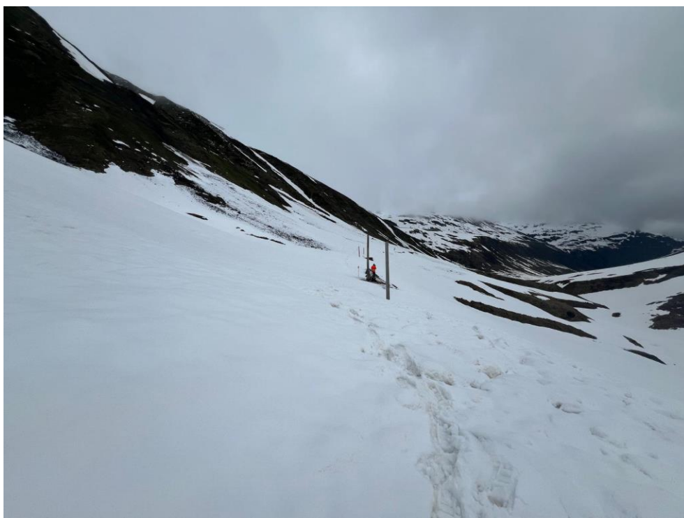
Niklaus Mayer, Matthias Wenger und Luc Wullschleger messen die Gleisachse zwischen Tiefenbach und Furka ein und markieren diese in regelmässigen Abständen mit Holzpflocken.
