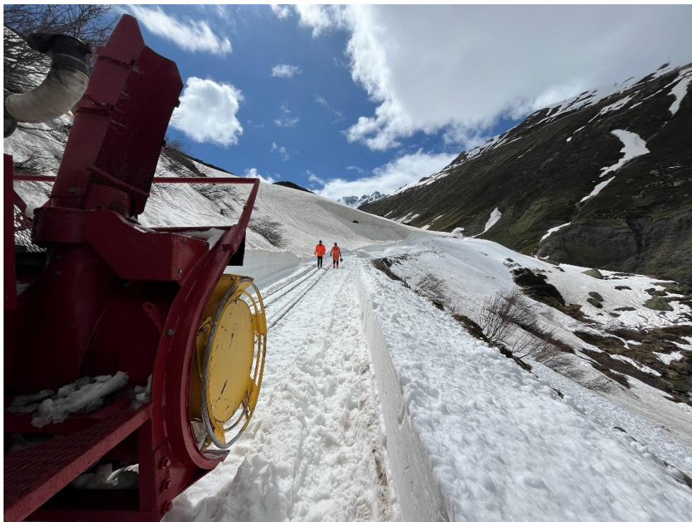
Die Anbaufräse der HGm 51 vor der Wächte unterhalb des Steinstafelviadukts.
