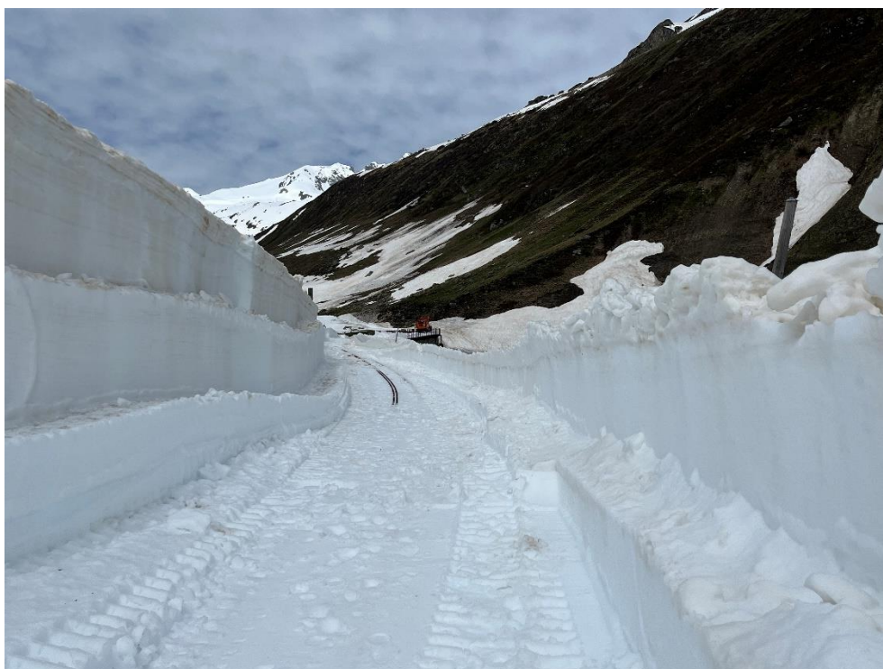
Schiene und Zahnstange sind in der Wächte stark vereist. Aus diesem Grund kratzt Martin Wieland mit dem Bagger den vereisten Schnee bis auf die Schiene auf. Anschliessend fräst die HGm 51 mit Anbaufräse den vereisten Schnee weg. Bild: Patrick Smit
