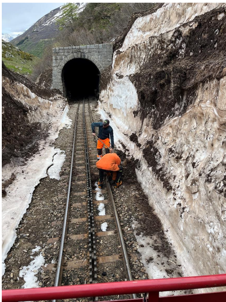
Mit dem Abschmelzen des Schnees beidseits der Gleise fällt immer wieder Erdreich und Geröll auf das Bahntrasse. Zudem bilden die auf den Lawinenkegel liegenden Felsblöcke während der Schneeschmelze eine latente Gefahr für das Bahntrasse. Bild: Patrick Smit
