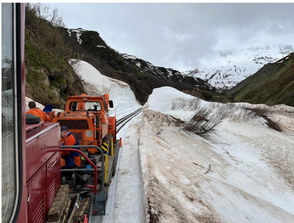
Überfuhr der INTRAC zum nächsten Einsatzort oberhalb des Bahnhofs Tiefenbach. Diese INTRAC wurde vor Tagen für Kleinreparaturen nach Realp gebracht.
