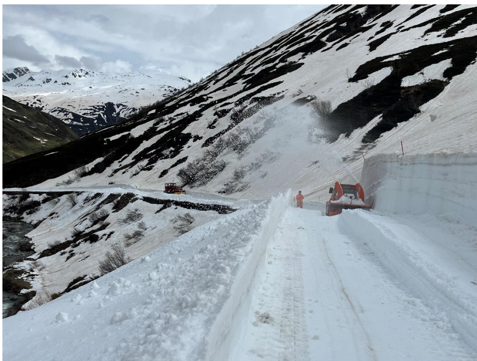
Schnitt für Schnitt fräsen die INTRAC's das Bahntrasse und den Weg zur Alp Steinstafel frei.
