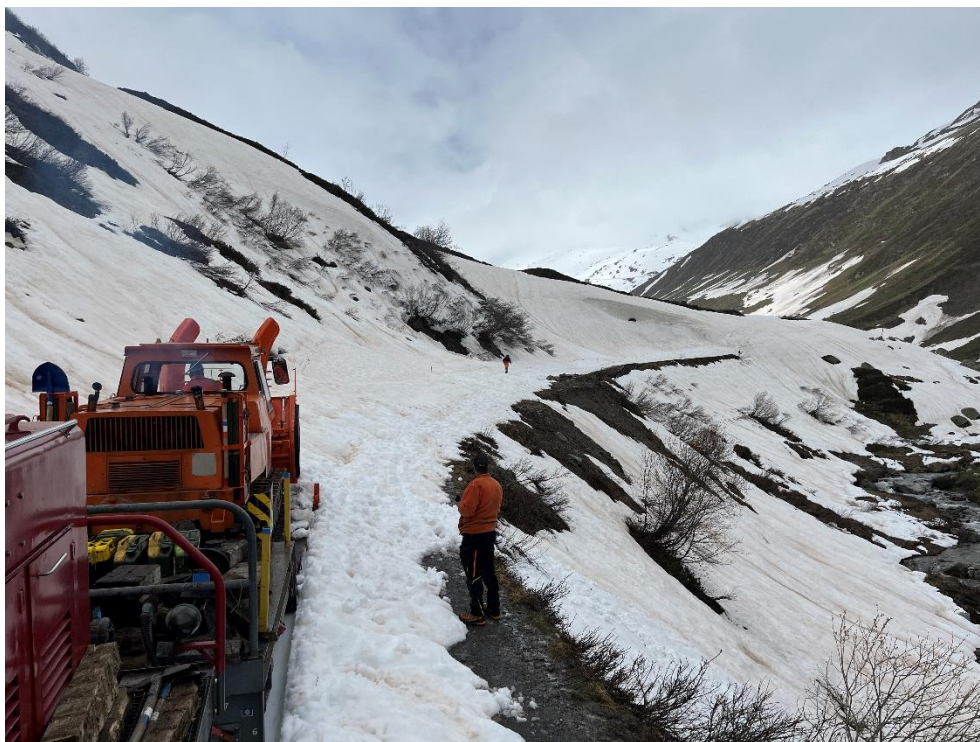
Die INTRAC fährt vom Tiefgänger direkt auf den Schnee. Im Hintergrund ist die Wächte unterhalb des Stein tafelviadukts sichtbar. Bild: Patrick Smit
