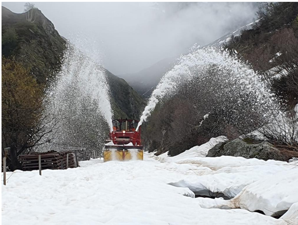
Die HGm 51 mit Anbaufräse unterhalb der Wasserfassung Tiefenbach.
