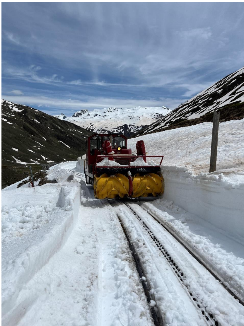
Die HGm 51 mit Anbaufräse vor dem Steinstafelviadukt. Bild: Patrick Smit
