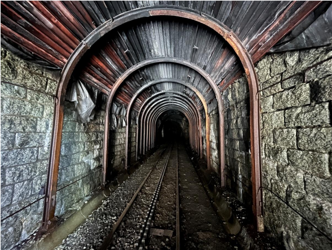
Im talseitigen Bereich des Altsenntumstafeltun- nels II.
