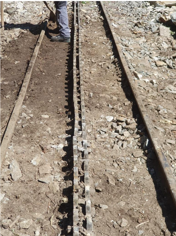
Feinräumung der Schadenstelle in der Rotten- schlucht.
