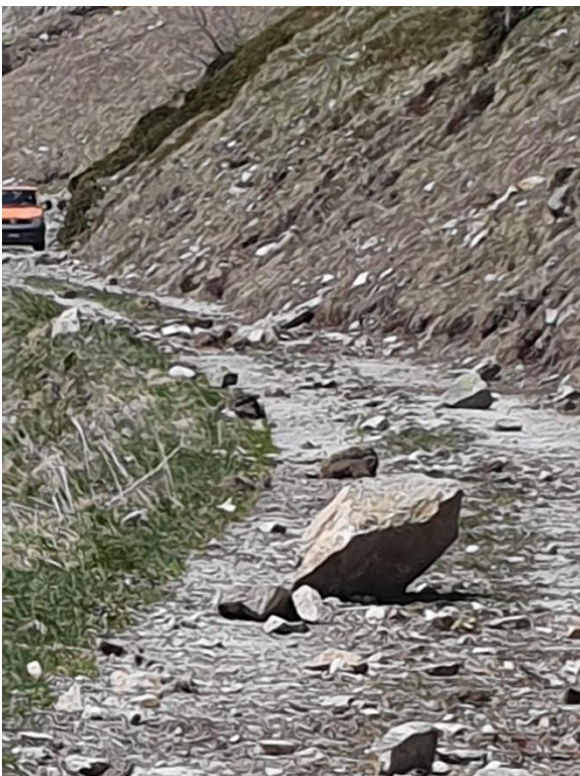
Die Zufahrtsstrasse zum Bahnhof Muttbach-Belvédère ist mit unzähligen Felsblöcken übersät. Diese stammen vornehmlich von der Felsreinigung, welche der Kanton Wallis zum Schutz der Passstrasse zwischen Passhöhe und Belvédère durchgeführt hat.
