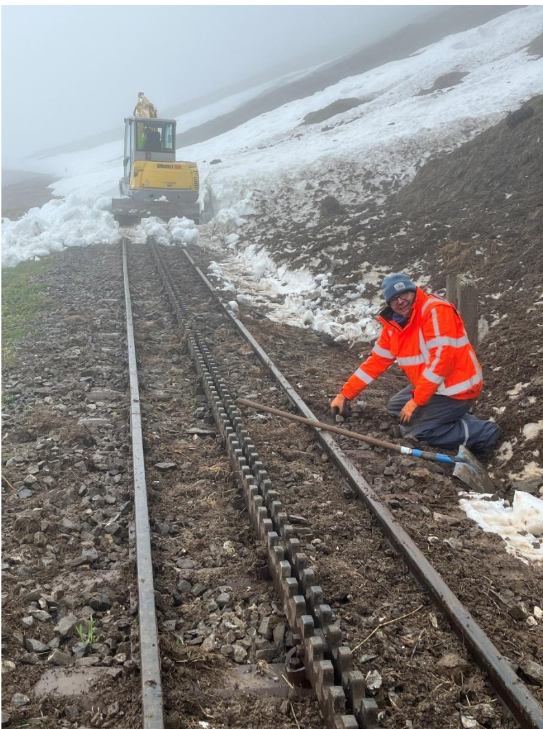
Während Pascal Rauber und Alexander Briner die Lawinenkegel bis auf 1,2 m räumen, befreien Michel van Wallene, Silvan Bözinger und Patrick Smit das Bahntrasse von Steinen, Humus und Vegetation.
