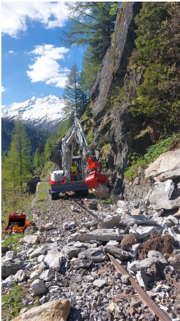
Unmittelbar vor Beginn der Schneeräumung/Auswinterung haben Martin Fischer und Beat Suter die Felsblöcke an der Schadenstelle in der Rottenschlucht mit dem neuen Bagger der Abteilung Infrastruktur geräumt.
