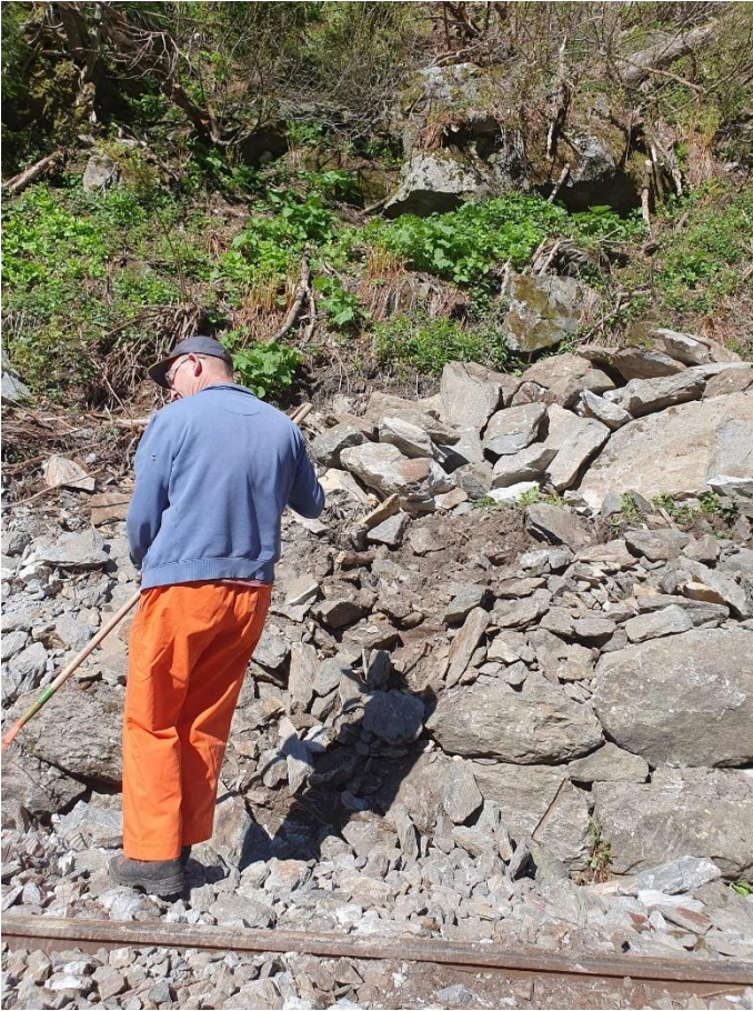
Beat Brehm bei der Feinräumung bei der vom Felssturz demolierten Trockenmauer.
