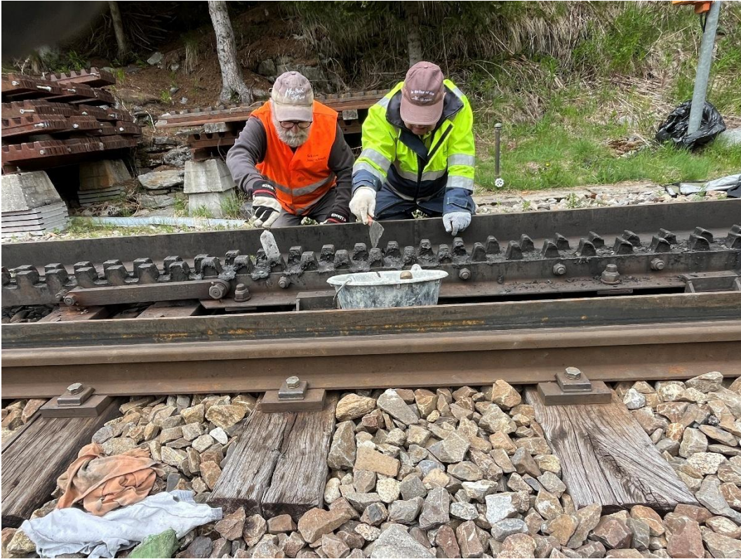
Alphonse Teuffer und Bruno Zimmermann beim Reinigen der Zahnstangeneinfahrt Realp. Bild: Patrick Smit
