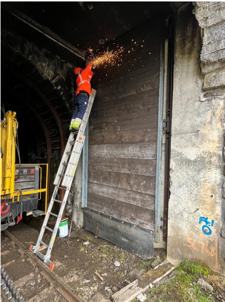
Pascal Rauber flex eine verrostete Verschraubung des bergseitigen Tors des Altsenntumstafeltunnels II weg. Bild: Patrick Smit
