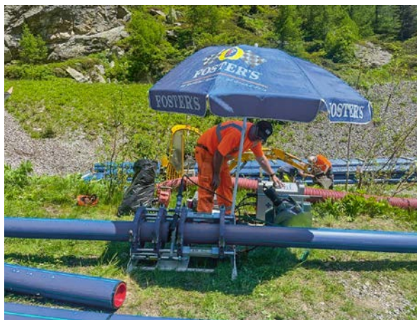
Wenig Platz für die Wasserleitung zwischen Strasse und Gleis
