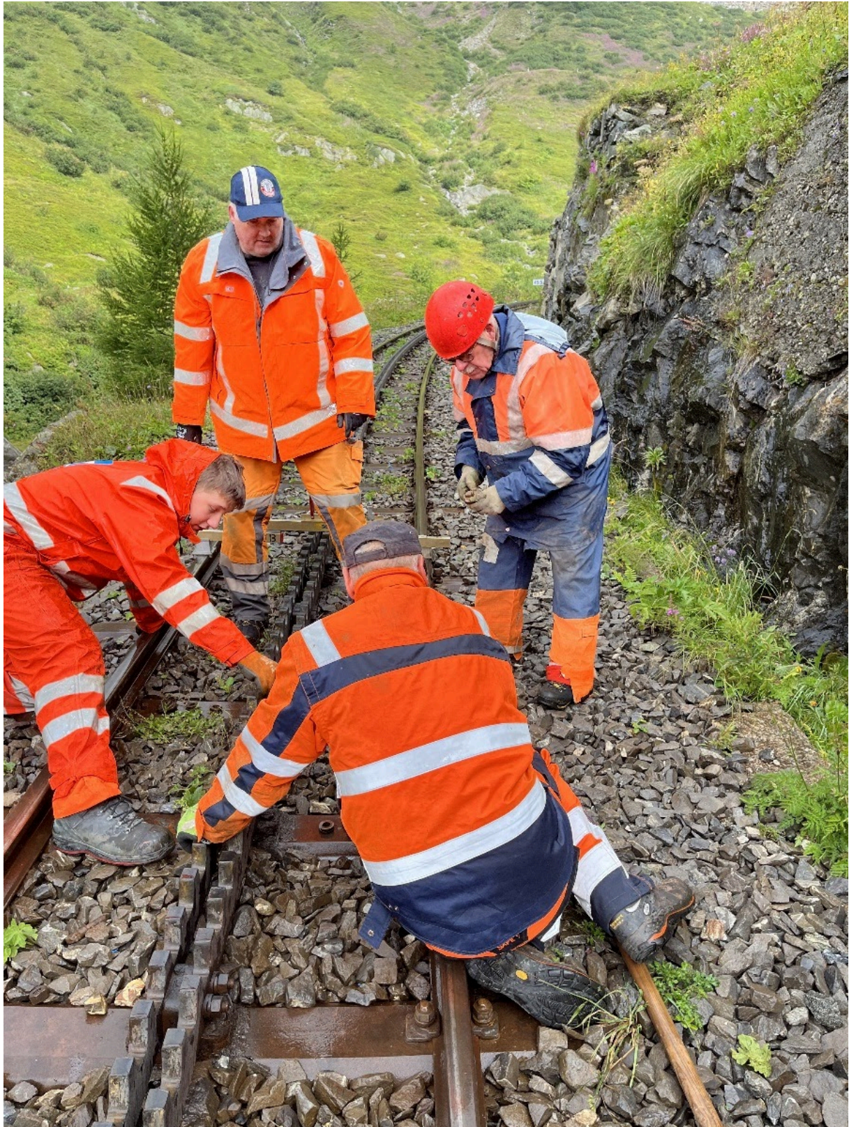
Spurweiten-Regulierung: mit Kraft und Geduld auf Maß gebracht
