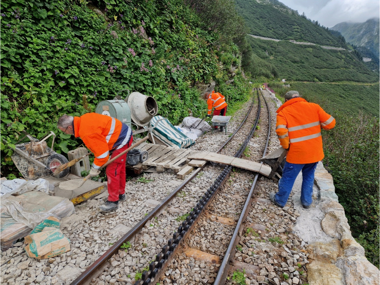
Die Mauerkronen-Crew: Im Beton-Einsatz
