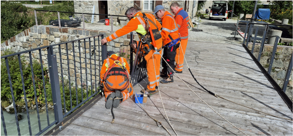
Gut gesichert: Arbeiten an der Rottenbrücke
