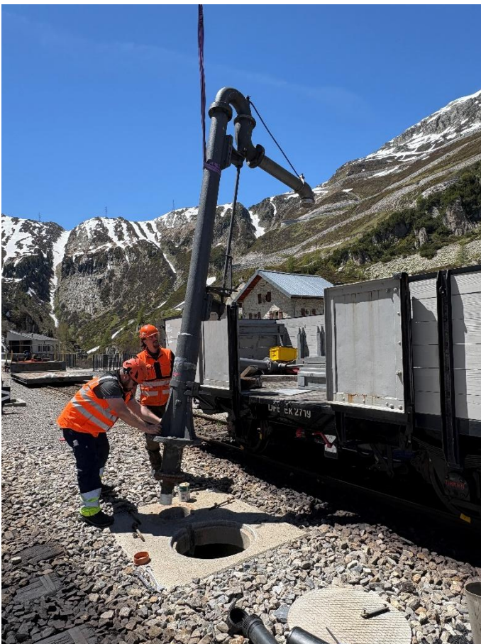
Montage des Wasserkrans 2 des Bahnhofs Gletsch.
