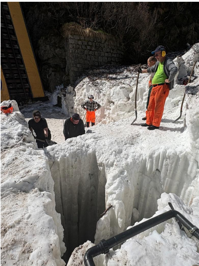
Die Berieselung des Lawinenkegels mit Wasser ist sehr effektiv.
