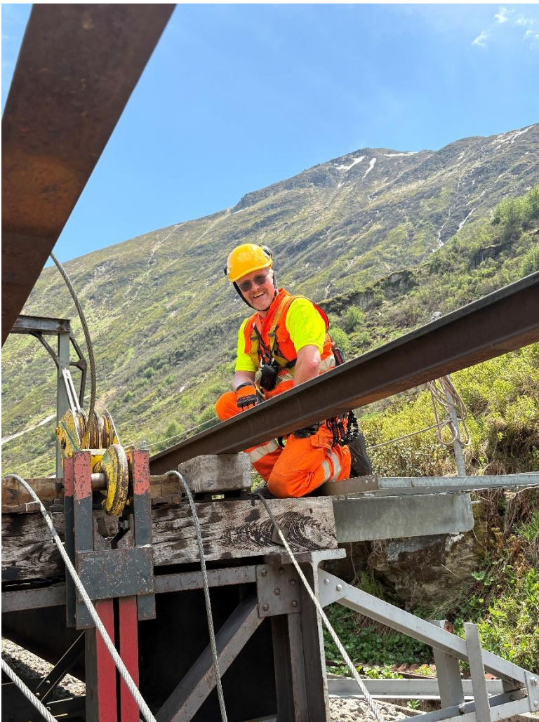
Der in Ausbildung befindliche neue Montageleiter der Steffenbachbrücke, Raphael Sutter, bei den Vorbereitungsarbeiten für die Montage des bergseitigen Elements der Steffenbachbrücke. Bild: Patrick Smit.
