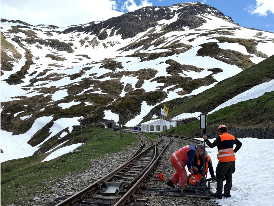
Guido Tresp, Beat Mühlemann und Thoms Lindenberg montieren die letzte Weichenstellvorrichtung im Bahnhof Furka.
