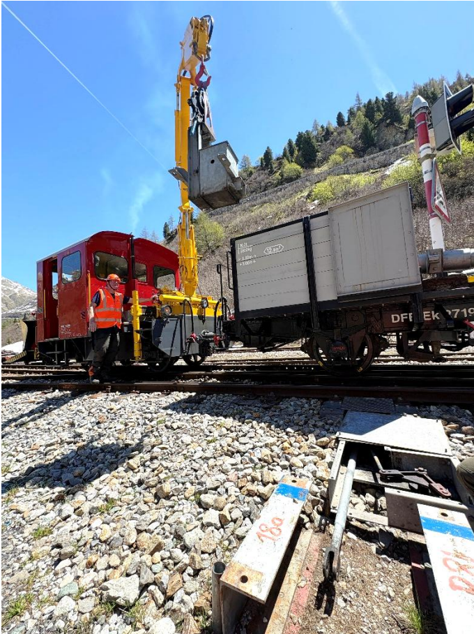
Daniel Feyer hievt eine Weichenstellvorrichtung der Doppelkreuzungsweiche von Gletsch an den Sommerstandort.
