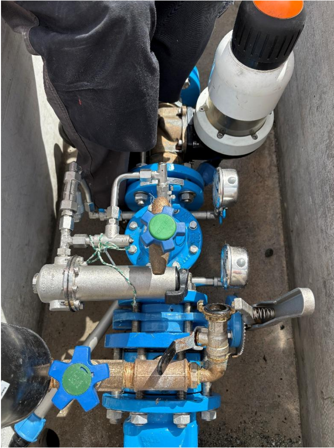
Auswinterung und Inbetriebnahme der Wasserversorgung der Bahninfrastruktur von Gletsch. Bild: Patrick Smit.
