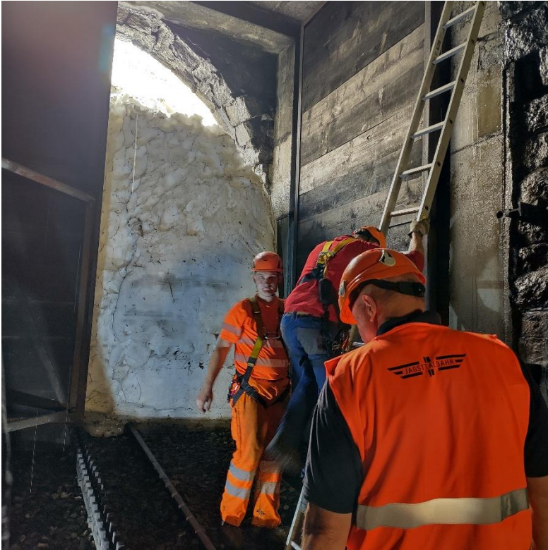
Der Lawinenkegel am bergseitigen Portal des Altsenntumtunnels I nach Öffnung der Tunnel-tore.
