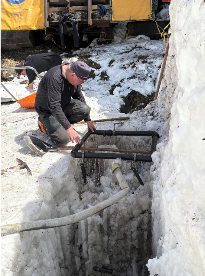
Daniel Feyer überwacht die Berieselung des Lawinenkegels. Im Hintergrund ist das bergseitige Ende des Mittelstücks der Steffenbachbrücke sichtbar.
