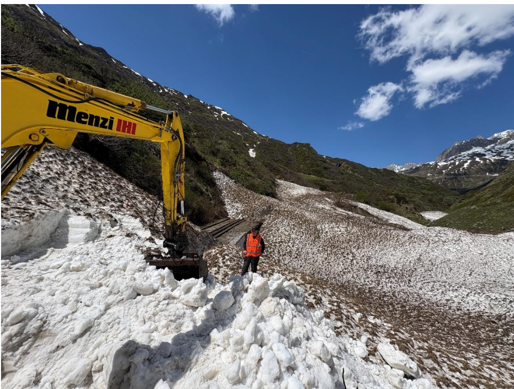
Der Maschinenbegleiter Daniel Feyer weist den Baggermaschinenisten Martin Wieland beim bergseitigen Portal des Altseentuntunnels II ein.
