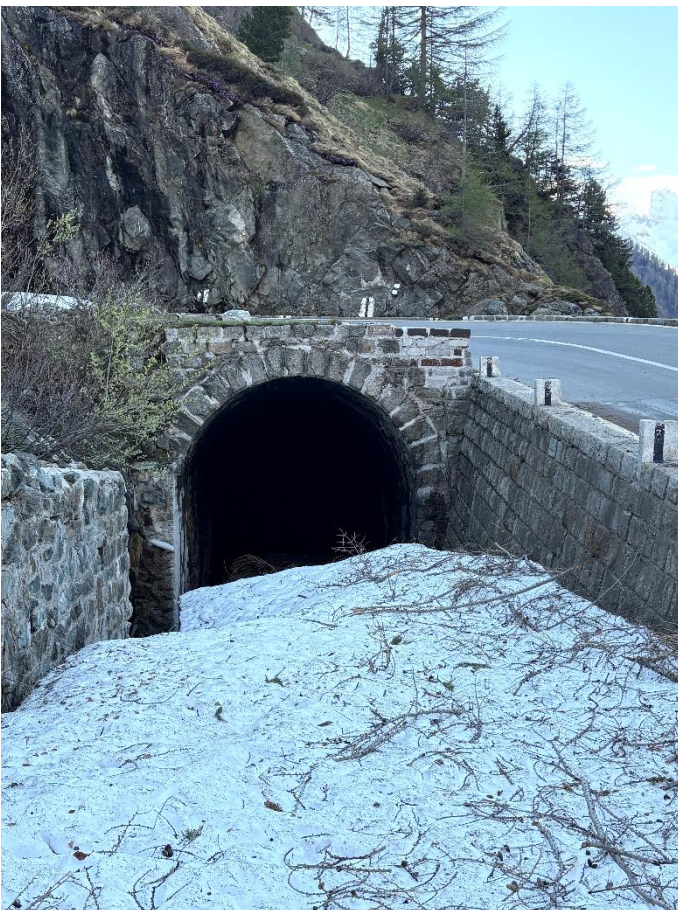
Der Restschnee vor dem bergseitigen Portal des Kehrtunnels.
