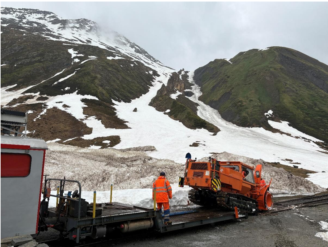
Stephan Stauber und Michael Bühler verladen in Muttbach-Belvédère die INTRAC Raupenfräse auf den Tiefgänger. Anschließend überführt Patrick Smit die INTRAC Raupenfräse mit dem Dieseltraktor Tmh 985 durch den Scheiteltunnel nach Furka. Bild: Patrick Smit.
