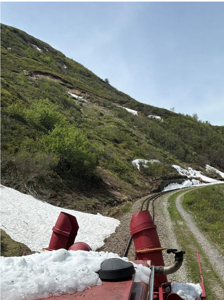
Manuelle Räumung der Schneemauern im Wassergraben oberhalb des Bahnhofs Tiefenbach. Bild: Patrick Smit.
