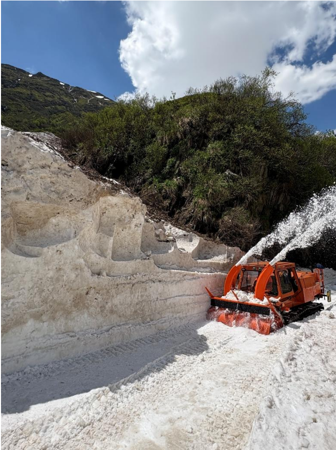
Michael Bühler fräst sich Schnitt für Schnitt durch den stark vereisten Lawinenschnee am bergseitigen Portal des Altseentuntunnels I.
