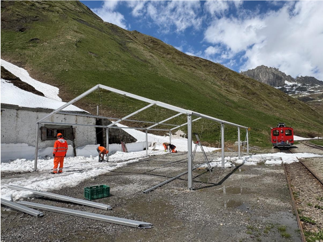
Montage des Gerüsts des Weinzelttes.
