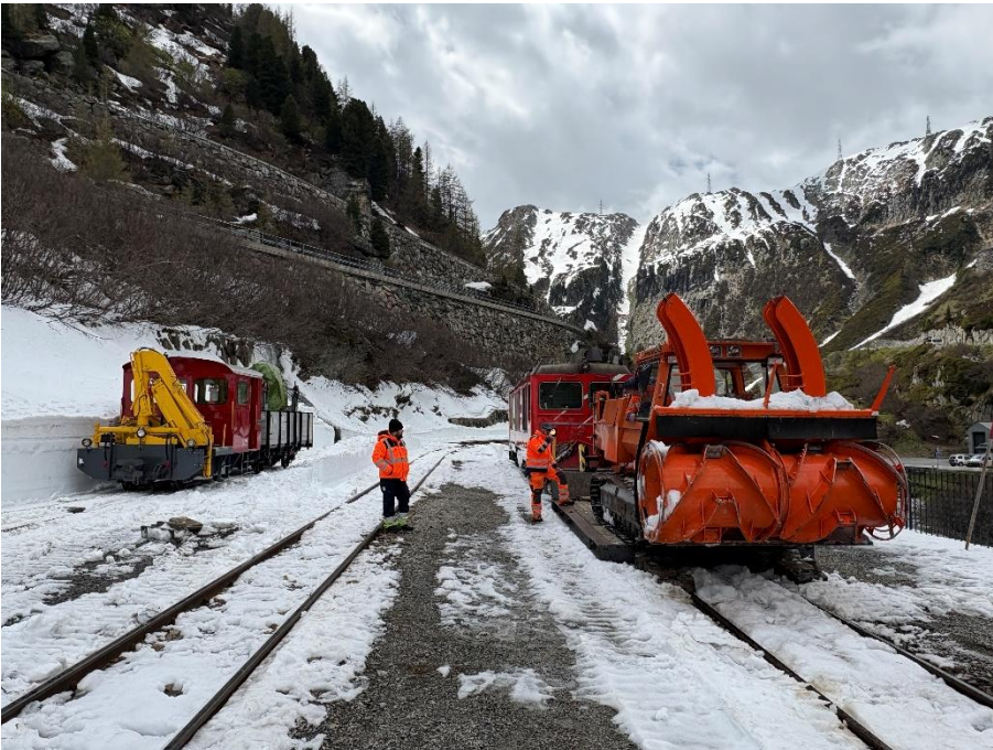
Verlad der INTRAC Schneefräse auf den Tiefgänger im Bahnhof Gletsch. Die Tm 2922 und der Hochbordwagen stehen auf Gleis 3 für die Montage der Wasserkränen und der Sicherungsanlagen von Gletsch bereit. Bild: Patrick Smit.
