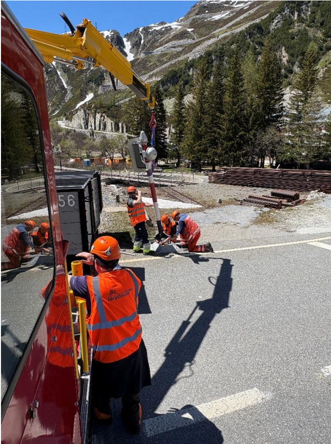
Daniel Feyer, Pascal Rauber, Thomas Lindenberg und Guido Tresp montieren das talseitige Lichtsignal des Bahnübergangs Blauhaus in Gletsch.
