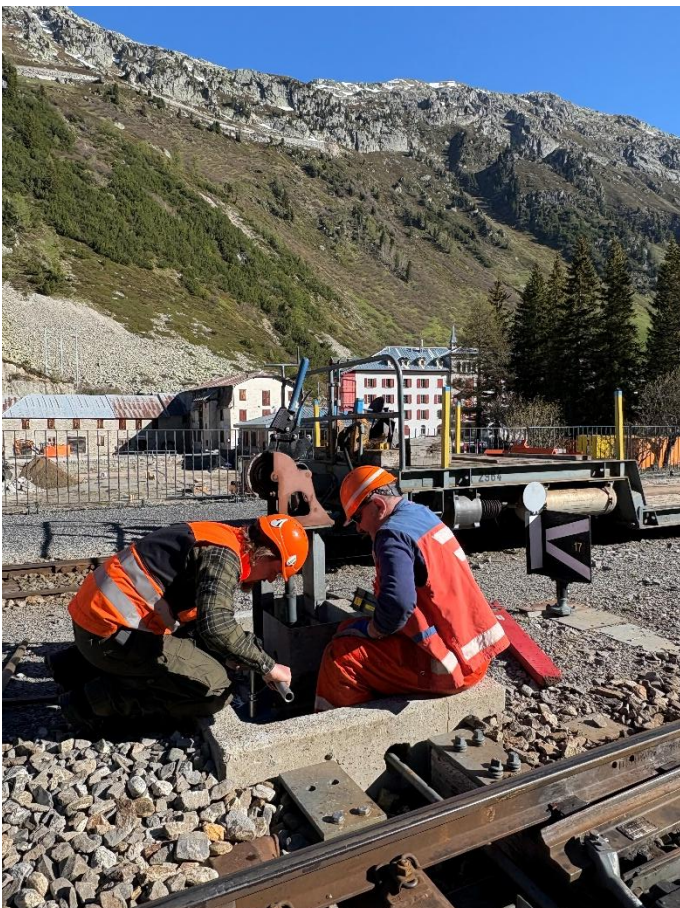
Thomas Lindenberg und Guido Tresp bei der Montage einer Weichenstellvorrichtung im Bahnhof Gletsch.
