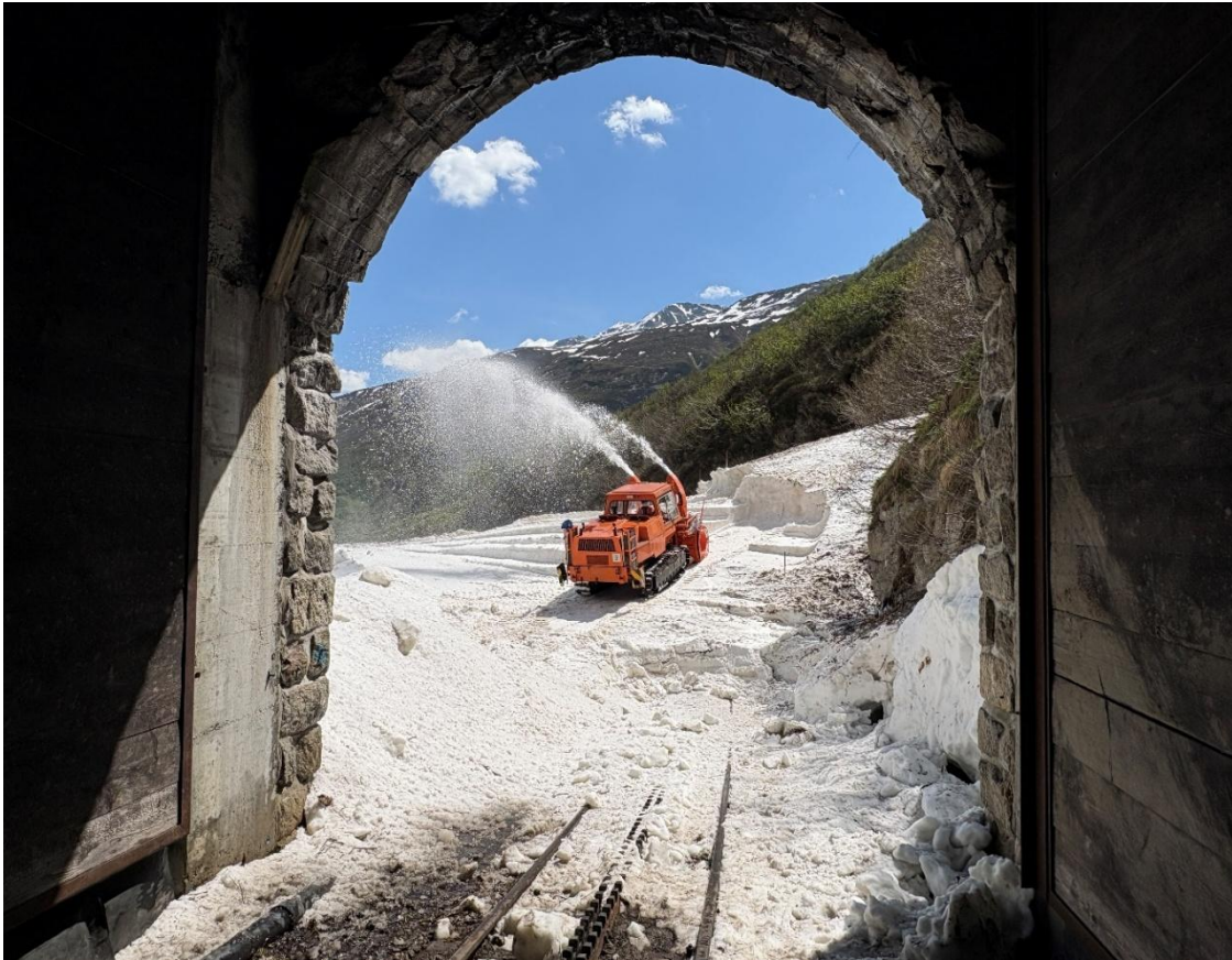
Blick vom talseitigen Portal des Altseintumtunnel II. Thomas Holder fräst sich Schnitt für Schnitt durch den Lawinenkegel.
