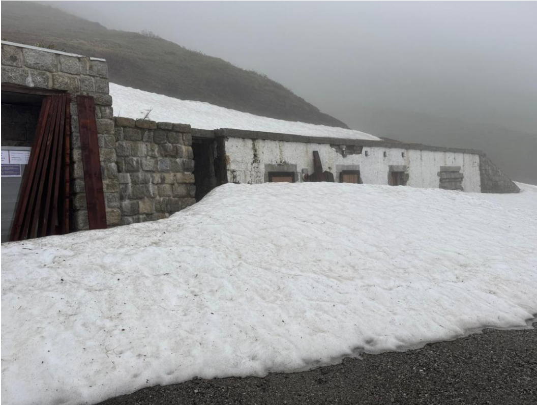
Auf dem Vorplatz des Bahnhofs Furka liegen noch bis 2 m Altschnee. Bild: Bruno Hossmann.
