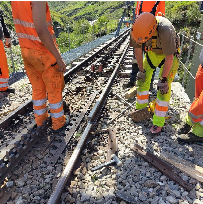
Die Schienen, Laschen und Zahnstangen am bergseitigen Widerlager müssen ebenfalls verschraubt werden. Bild: Michel van Wallené.
