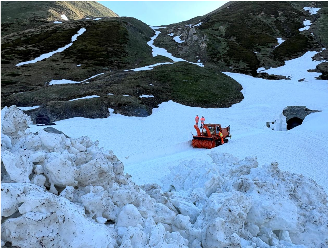
Blick vom Lawinenkegel zum Westportal des Scheiteltunnels. Im Vordergrund der obere Bereich des Lawinenkegels.
