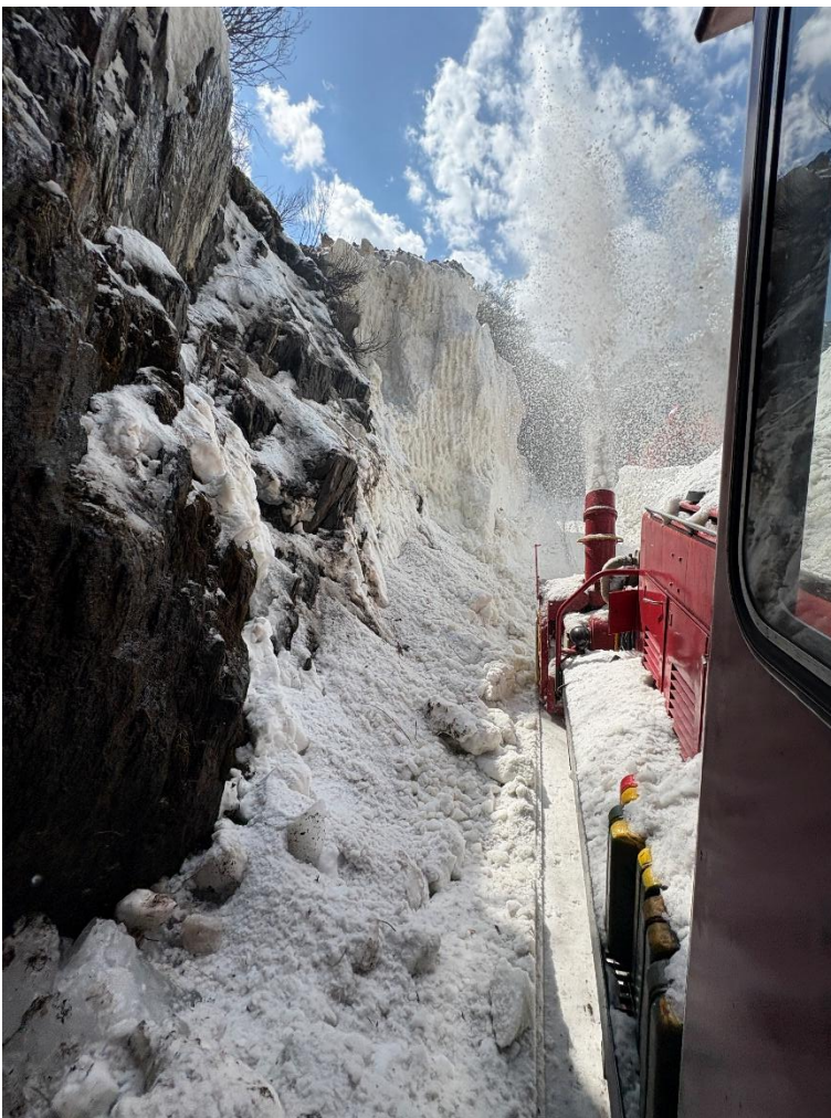
Blick vom Arbeitsplatz des Fräsmaschinisten der HGm 51 mit Anbaufräse auf den Lawinenkegel am bergseitigen Portal des Altsenntumtunnels I.
