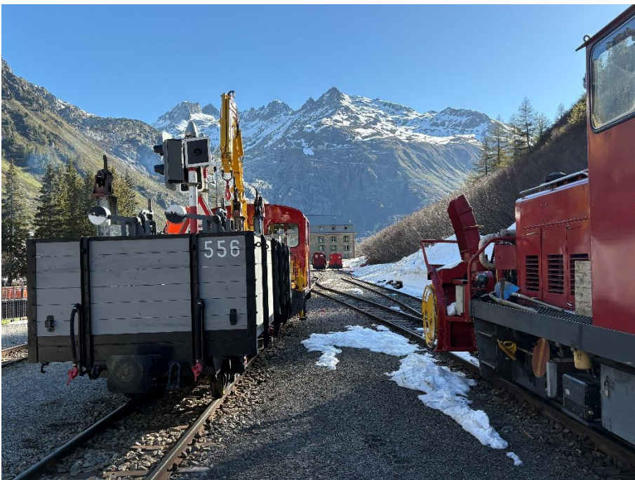
Während die HGM 51 mit Anbaufräse zum neuen Einsatzort oberhalb von Gletsch fährt, montiert ein anderes Team die Sicherungsanlagen des Bahnhofs Gletsch.
