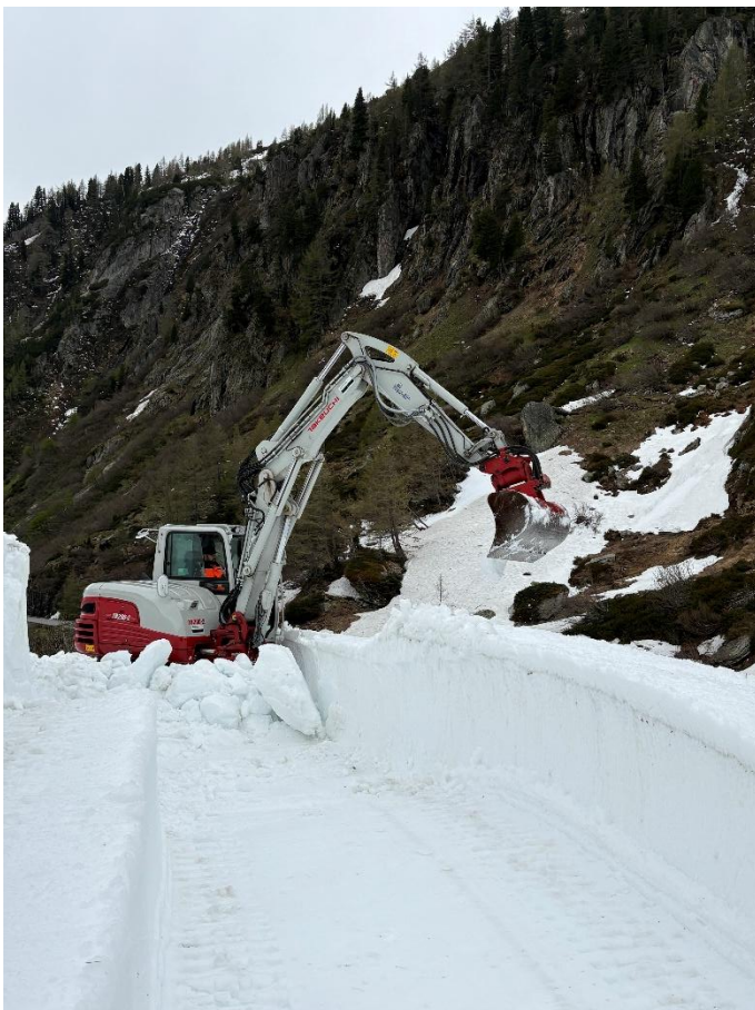
Wegen der starken Vereisung muss der Lawinenschnee mit dem Takeuchi Bagger aufgelockert werden. Bild: Patrick Smit.
