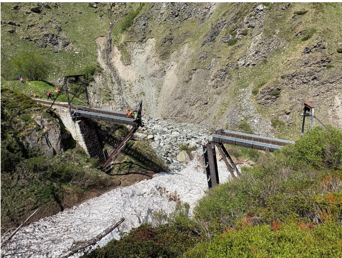
Die Steffenbachbrücke im Aufbau.
