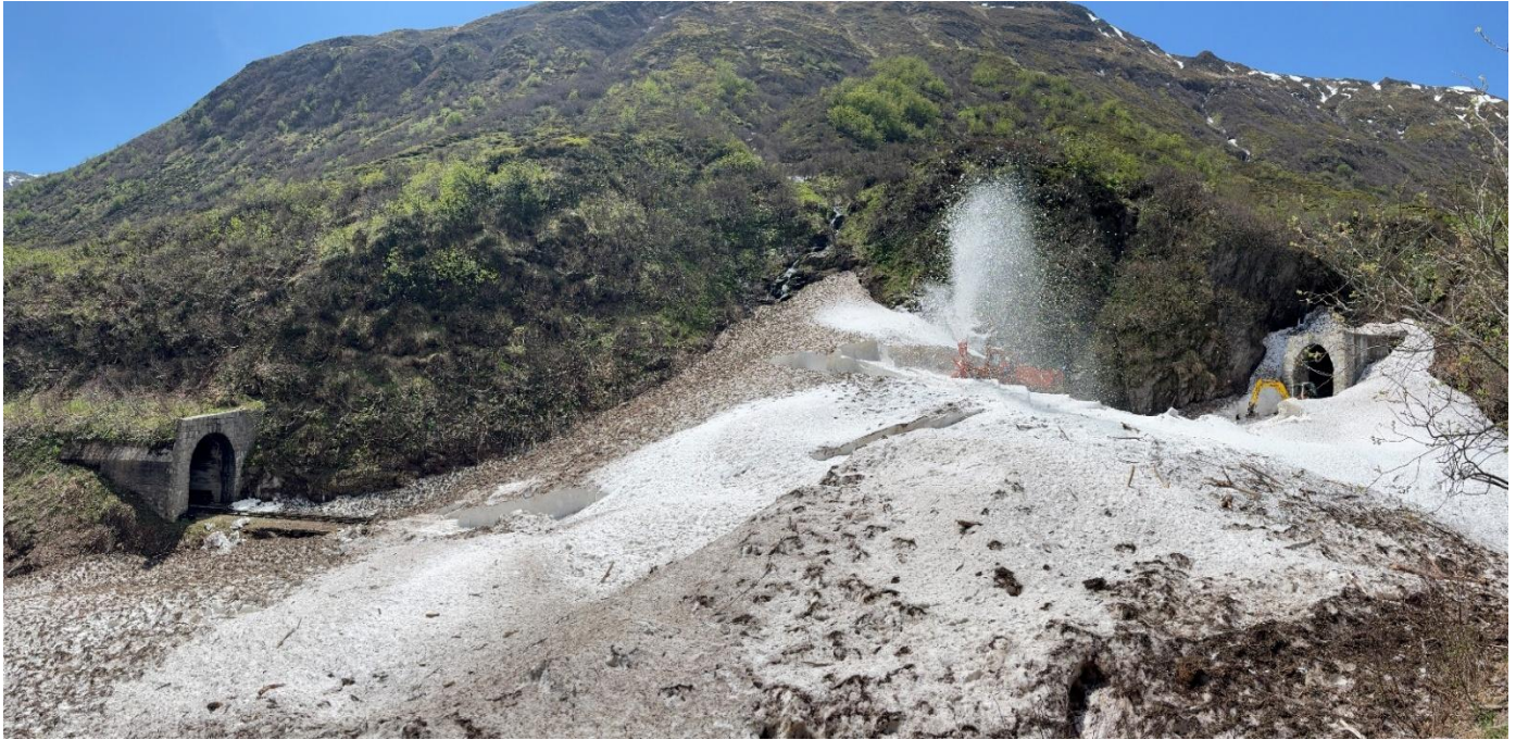
Der mächtige Lawinenkegel zwischen den Altseentumtunnels II (rechts) und I (links). Bild: Patrick Smit.
