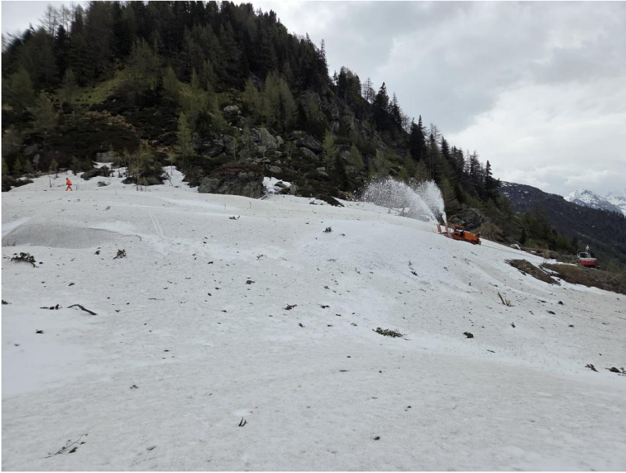
Die INTRAC Schneefräse kämpft sich durch den stark vereisten Lawinenkegel oberhalb des Kehrtunnels. Bild: Michael Bühler.
