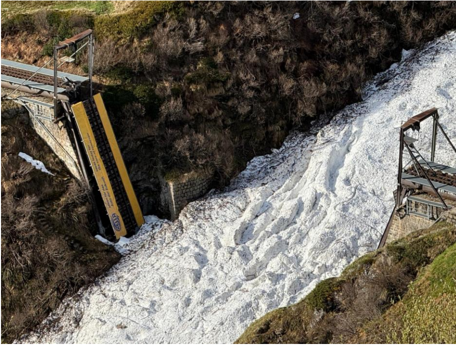
Der 5 m mächtige sehr stark vereiste Lawinenkegel im Bereich der Steffenbachbrücke.
