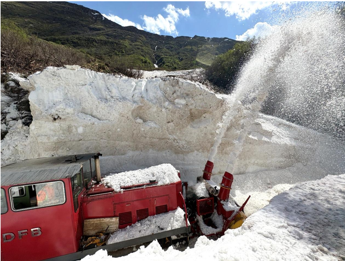
Die HGm 51 mit Anbaufräse im stark vereisten Lawinenkegel am bergseitigen Portal des Altsenntumtunnels I.
