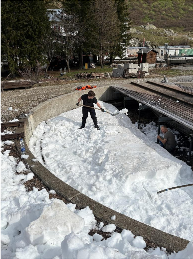
Während Rody van Gessel den Schnee aus der Grube der Drehscheibe in Gletsch ausschaufelt, entfernt Toni Waldis die Spriesse der Drehscheibe.
