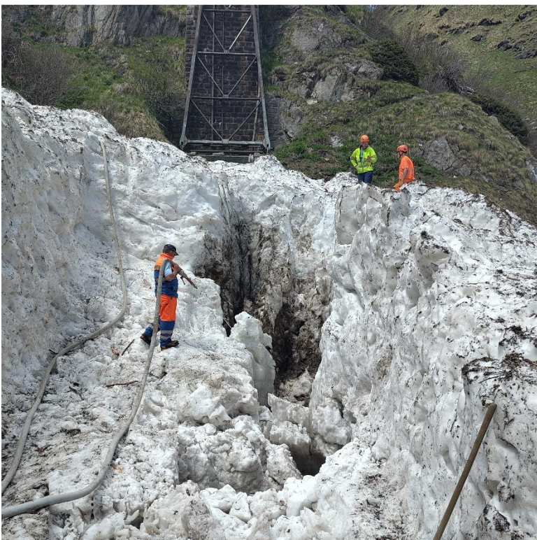
Mit einem Hohlstrahlrohr nässt Michael Bühler den stark vereisten Lawinenschnee im Schneekanal des Steffenbachtobels. Anschliessend kann der wassergetränkte Lawinenschnee mit wenig Kraftaufwand durch das Loch in den darunter fliessenden Steffenbach gestossen werden. Christoph Spinnler überwacht die nicht ungefährliche Arbeit von Michael Bühler. Bild: Michel Wallené.
