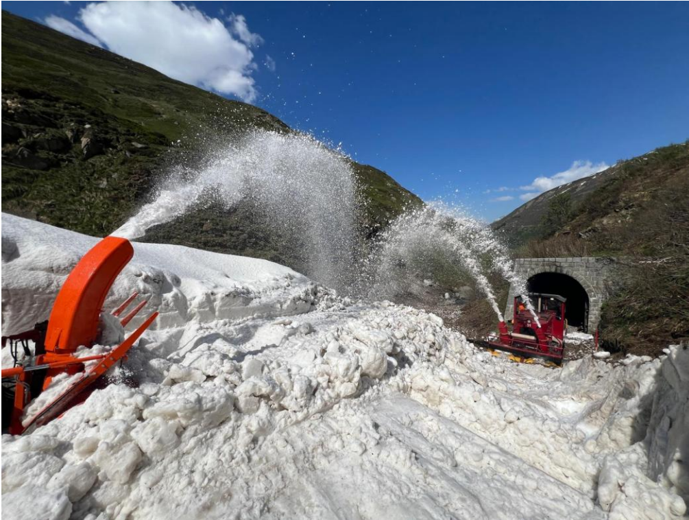
Die INTRAC Schneefräse und die HGM 51 mit Anbaufräse zwischen den Altseentuntunnels III und II.
