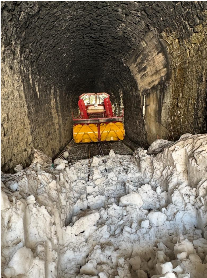
Die HGm 51 mit Anbaufräse wartet im Altsenntumtunnel I auf ihren nächsten Einsatz.
