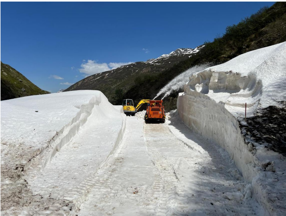
Während der Bagger den stark vereisten Lawinenschnee aufbricht, fräst die IN-TRAC Schneefräse den Lawinenschnee weg.
