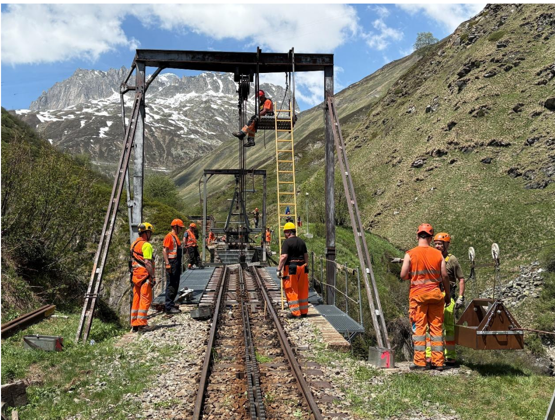
Montage des talseitigen Elements der Steffenbachbrücke. Bild: Patrick Smit.
