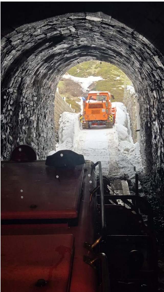
Die INTRAC Schneefräse am bergseitigen Portal des Kehrtunnels. Bild: Andreas Schuler.
