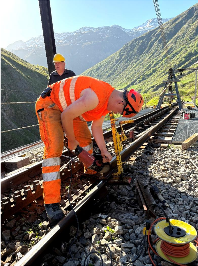
Der Gleisbaulehrling Immanuel Furrer beim Einpassen der Schienen am bergseitigen Widerlager.
