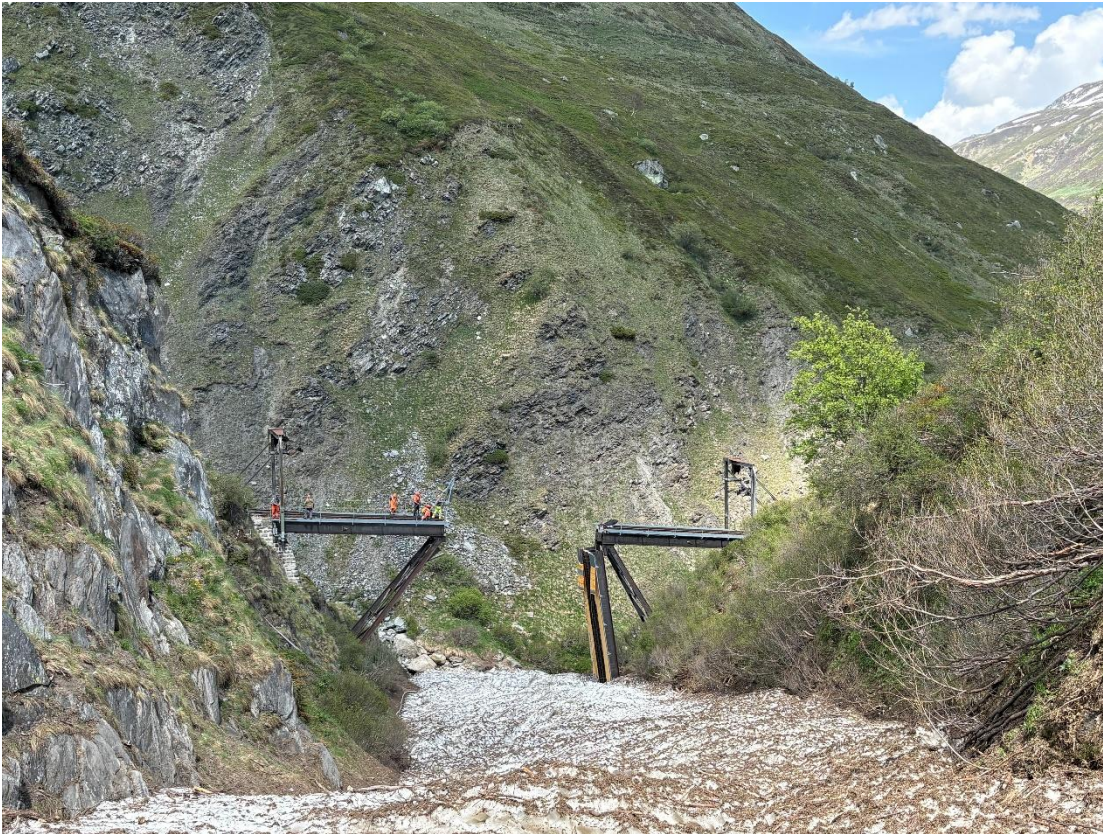
Blick aus dem Steffenbachtobel zur im Aufbau befindliche Brücke.
