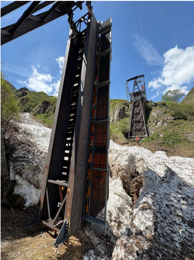
Das mittlere und bergseitige Element der Steffenbachbrücke während des Aufbaus.
