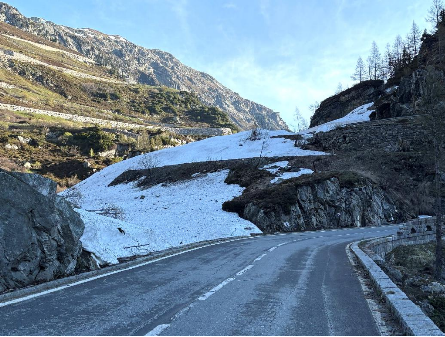
Blick von der Kantonsstrasse oberhalb des Rottenviadukts Richtung Schotterplatz oberhalb des Kehrtunnels.
