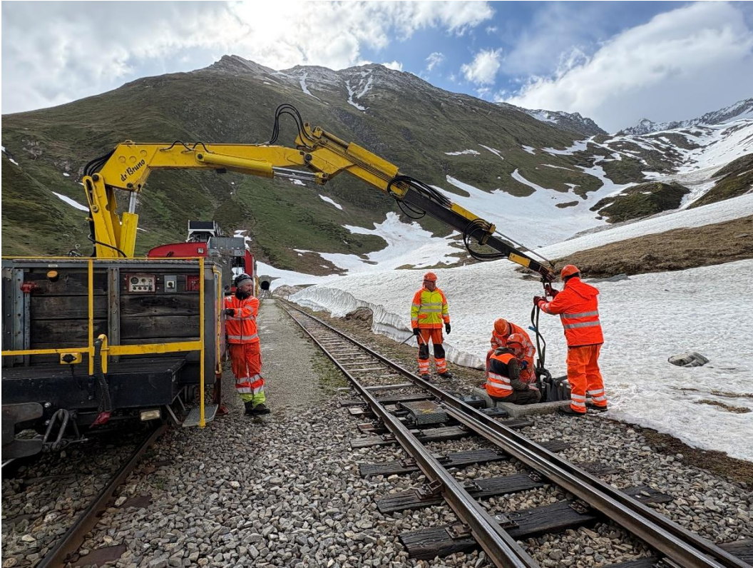
Martin Wieland, Beat Mühlemann, Guido Tresp, Thomas Lindenberg und Bruno Hossmann bei der Montage der Stellvorrichtung der Weiche 22 im Bahnhof Muttbach-Belvédère. Bild: Patrick Smit.
