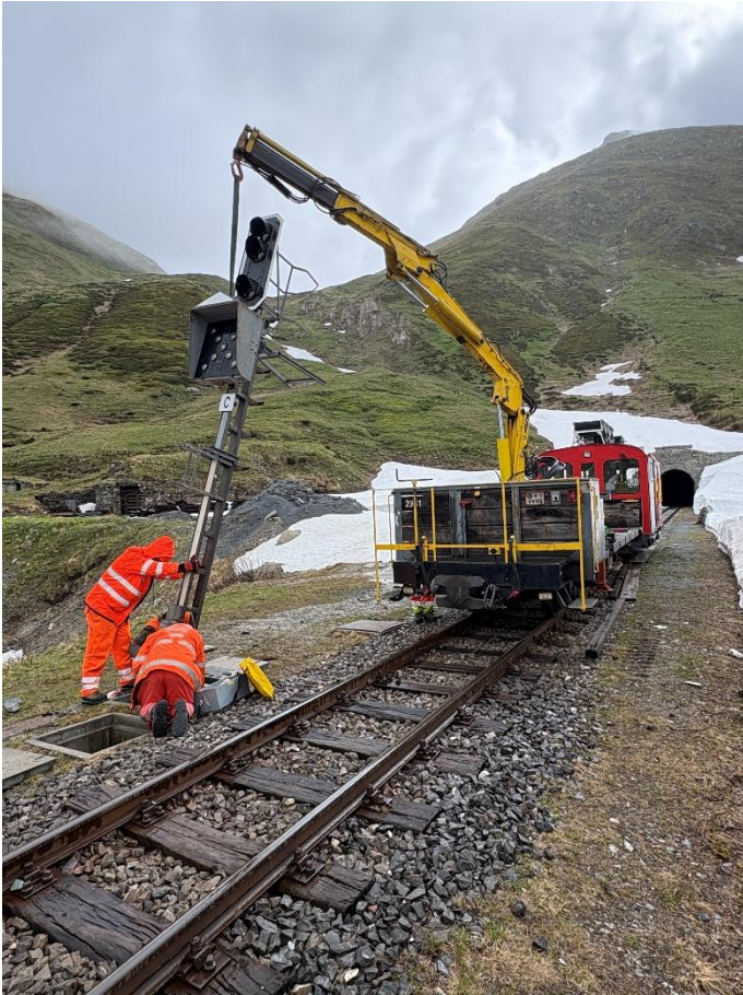
Montage des Ausfahrtsignal C im Bahnhof Muttbach-Belvédère.
