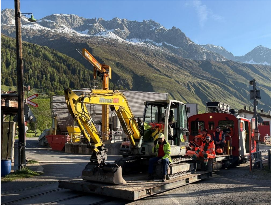
Abfahrt des Urner-Schneeräumungsteams am Pfingstmontagmorgen vom Stützpunkt Realp zum Altseentumtunnel III.
