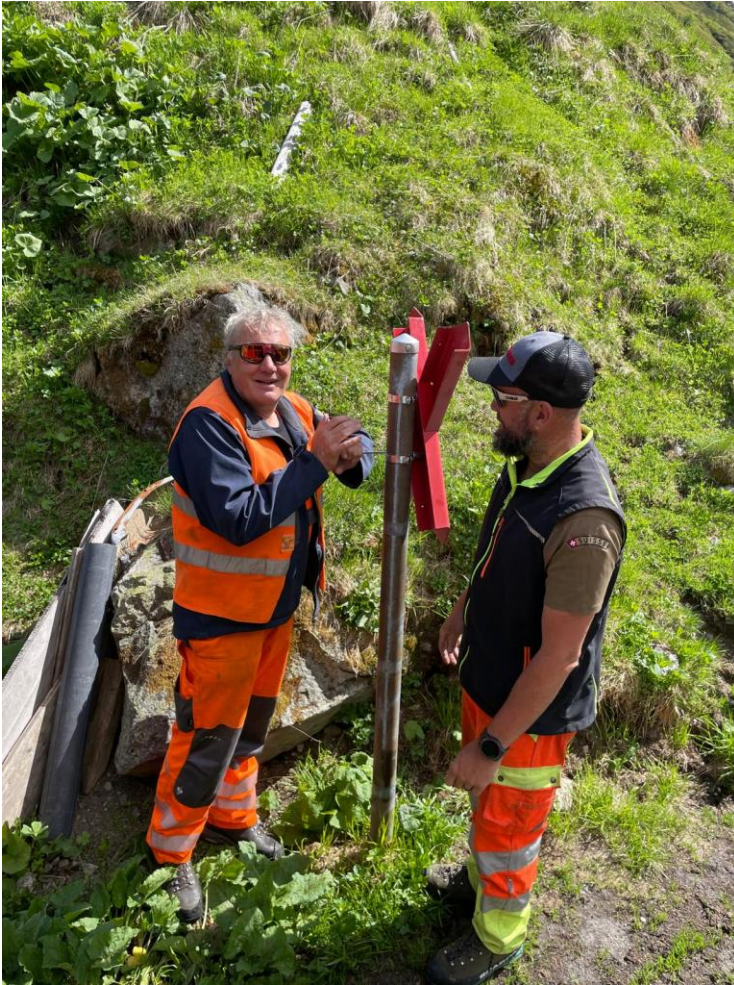
Zwischenstopp bei Steinstafel während der Rückfahrt nach Realp. Beat Mühlemann und Martin Wieland montieren das Andreaskreuz, das am Vorabend im Stützpunkt Realp repariert wurde. Bild: Carlo Jones.
