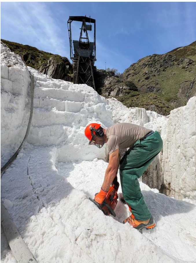
Mit der Kettensäger schneidet Toni Waldis den Lawinenkegel in kleine Eisblöcke, die anschliessend mit der Schneehexe abgeführt werden.
