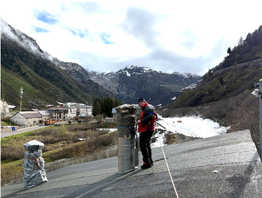
Daniel Feyer entfernt die Schutzhäuben der Rauchabzüge der Remise Gletsch. Im Hintergrund sind die Baufahrzeuge für den Bau der Werkleitungen vor dem Hotel Glacier du Rhône sichtbar. Bild: Patrick Smit.
