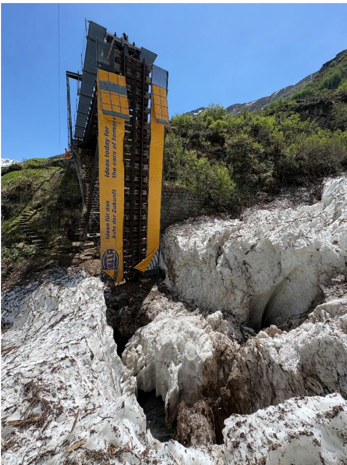
Das Mittelelement der Steffenbachbrücke «baumelt» vor dem mühsam ausgegrabenen Schneekanal.
