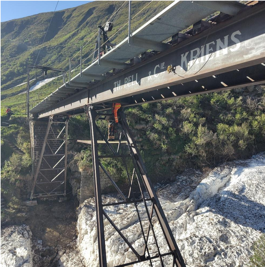
Verschrauben des Mittelelements mit dem bergseitigen Brückenelement. Bild: Michel van Wallené.
