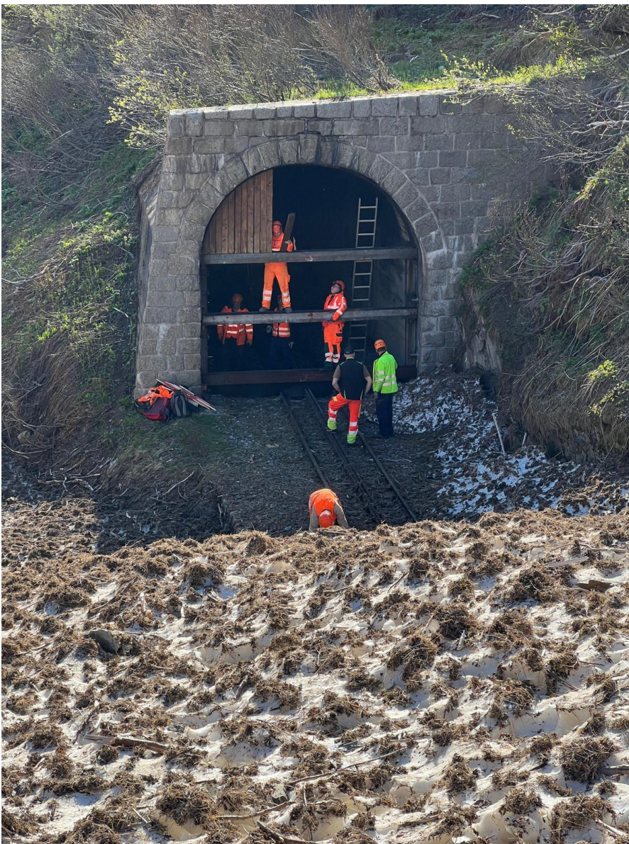
Demontage des massiven Holzverschlags am bergseitigen Portal des Altseentumtunnels I.
