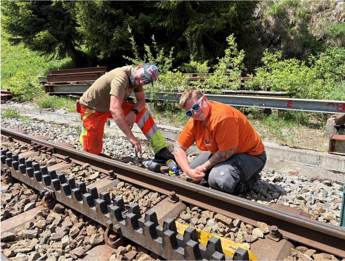
Martin Wieland und Sabrina Lütziger schneiden neue Gewinde für die Metallabdeckung des Magneten für die Betriebsartenüberwachung der Diesellokomotiven bei der Zahnstangeneinfahrt Realp.
