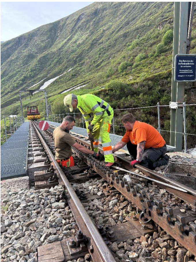
Am frühen Samstagmorgen «würgen» Christoph Spinner, Martin Wieland und Sabrina Lütziger die letzten Zahnstangen an ihren Platz und verschrauben die letzten Schienen und Zahnstangen am bergseitigen Widerlager der Steffenbachbrücke.
