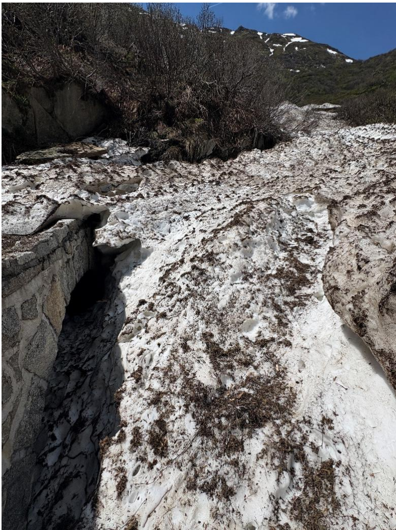
Der obere bergseitige Portalbereich des Altsenntumtunnels I.
