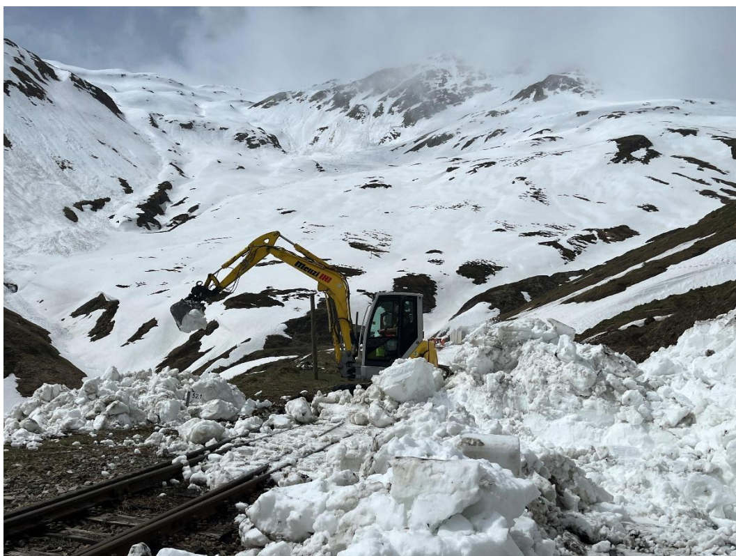
Räumung des Stumpen 21 des Bahnhofs Furka. Bild: Patrick Smit
