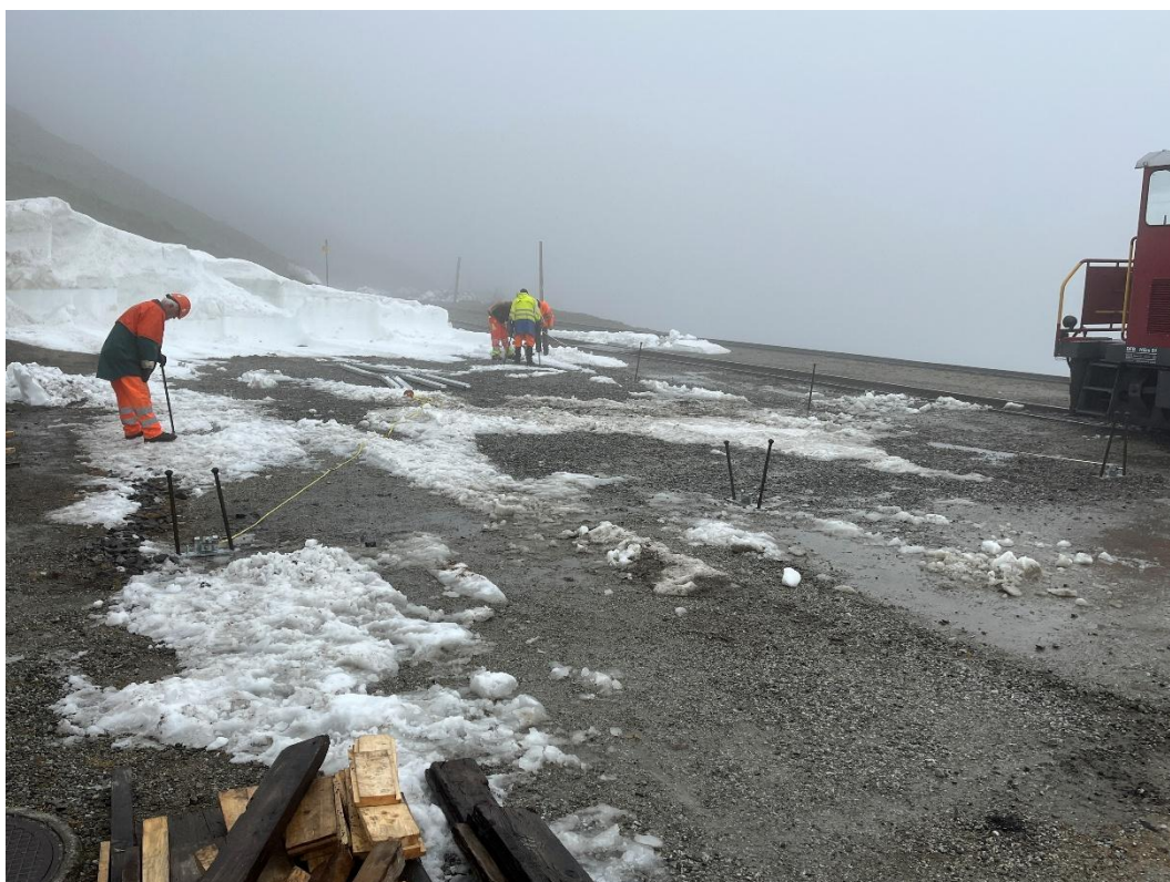
Ausstecken der Ankerplatten des Festzeltes. Bild: Patrick Smit
