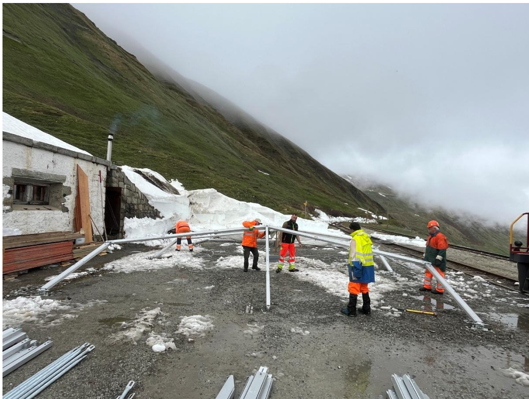
Zusammenstecken des Gerüsts des Festzeltes. Bild: Patrick Smit
