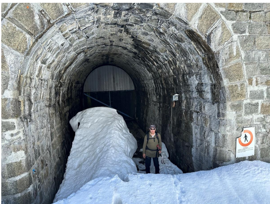
Das Ostportal des Scheiteltunnels.
