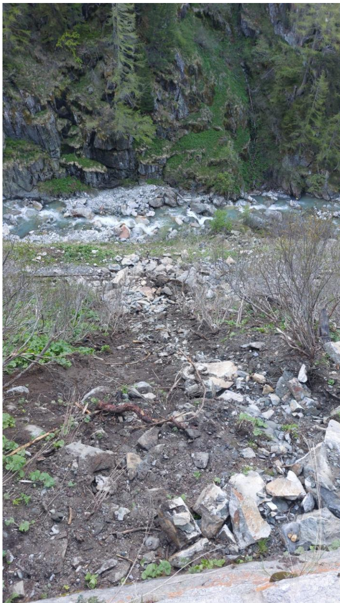
Blick von der Kantonsstrasse zur Schadenstelle in der Rottenschlucht.
