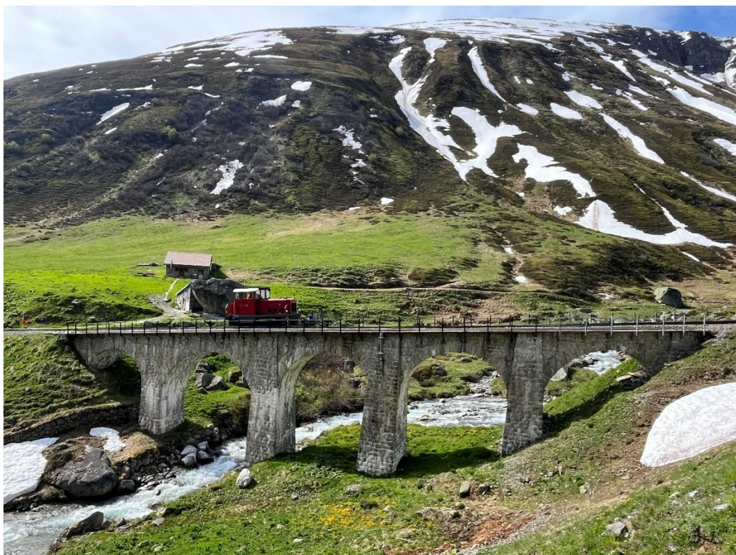
Die HGm 51 auf dem Steinstafelviadukt. Bild: Patrick Smit
