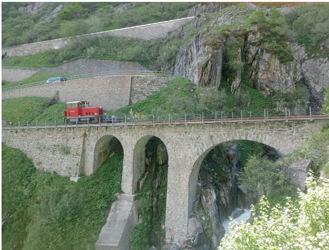
Die HGM 51 mit vorgestelltem Schmierwagen auf dem Rottenviadukt. Bild: Martin Wieland
