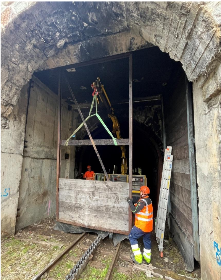
Aushängen des Rahmens des talseitigen Flügels des Tunneltors. Bild: Patrick Smit
