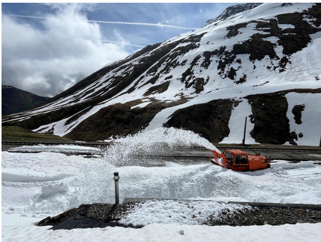
Räumung des Vorplatzes des Bahnhofs Furka. Bild: Patrick Smit
