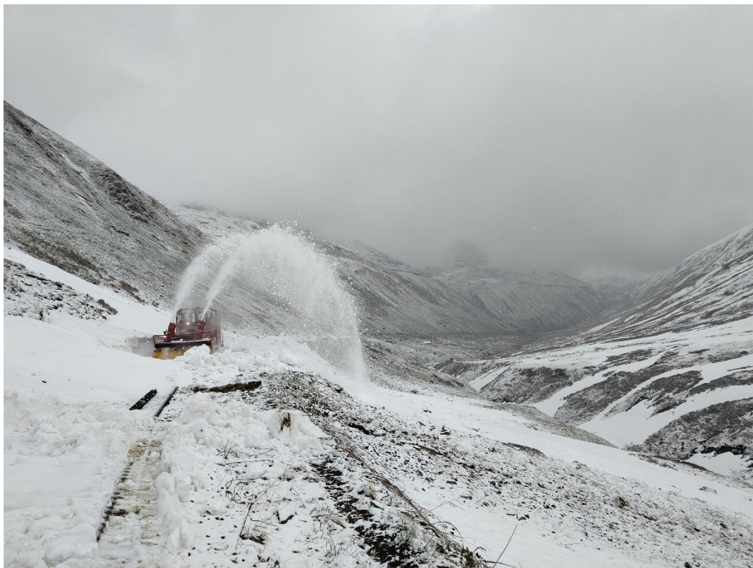
Schneeräumung mit HGM 51 mit Anbaufräse zwischen Sidelenbrücke und Bahnhof Furka. Bild: Michel van Wallene
