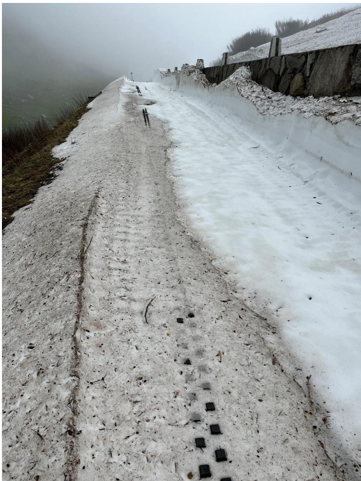
Unterhalb des BUE Furkastrasse 1 Tag nach Räumung des Lawinenkegels mit der INTRAC Raupenfräse.
