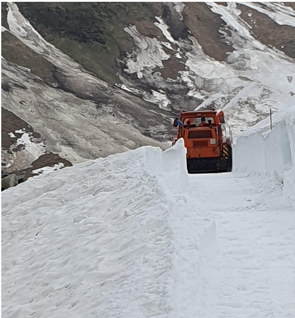
Langsam, aber stetig «frisst» sich die INTRAC Raupenfräse durch den pickelharten Schnee zwischen BUe Furkastrasse und dem Westportal des Scheiteltunnels.
