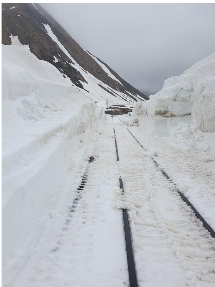
Blick vom Westportal des Scheiteltunnels Richtung Bahnhof Muttbach-Belvédère.
