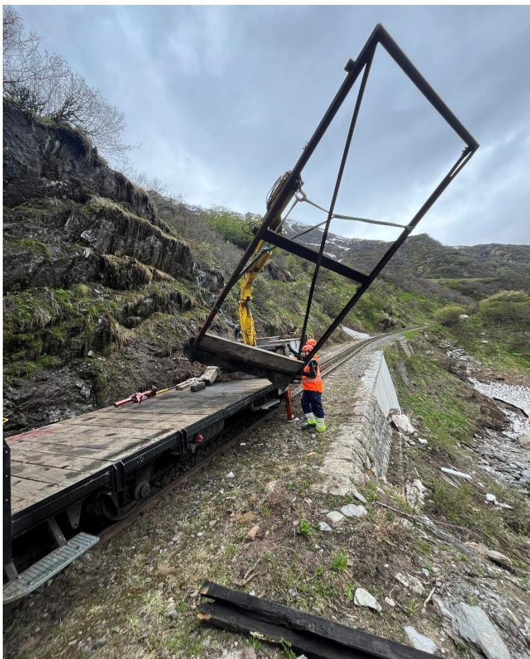
Ablegen des Tunneltors auf die Ladefläche des Kranwagens «Bruno».
