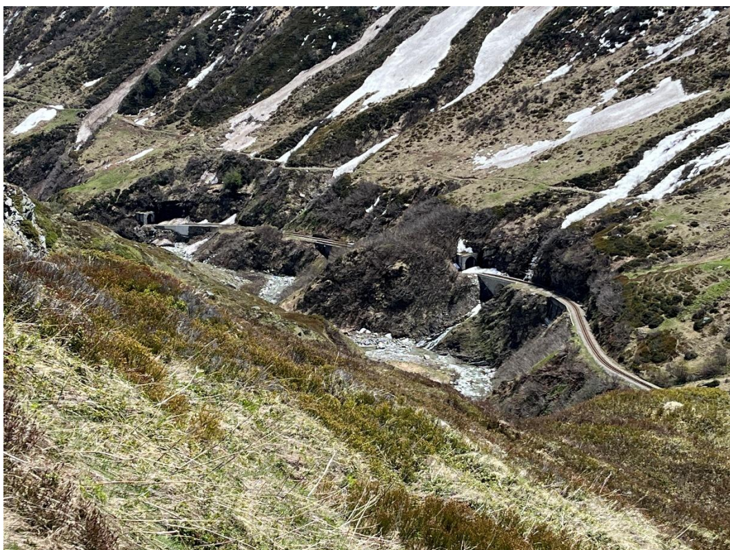
Bahntrasse unterhalb der Steffenbachbrücke. Bild: Patrick Smit
