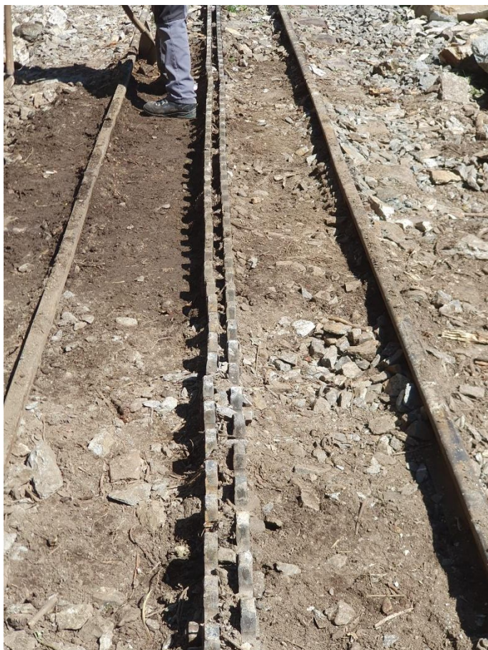
Feinräumung der Schadenstelle in der Rotten- schlucht. Bild: Bruno Zimmermann
