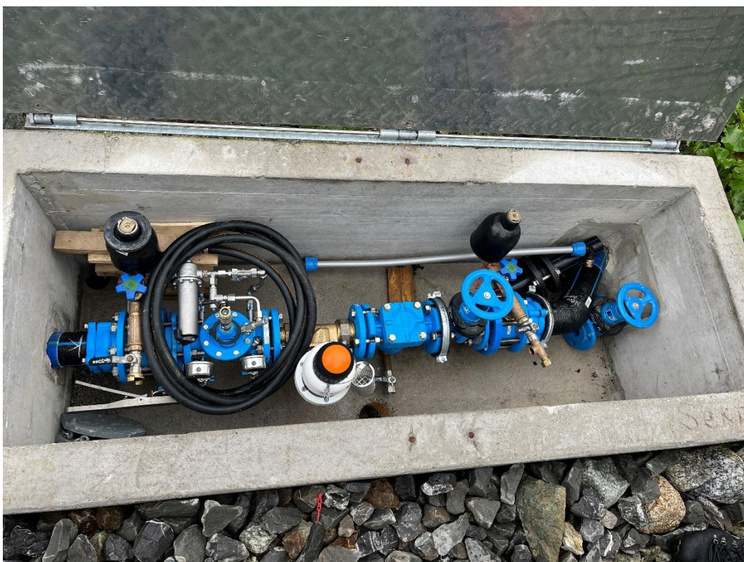
Die neue Hauptzuleitung für die Wasserversorgung des Bahnhofs Gletsch. Patrick Smit und Diederik van Nimwegen müssen die Checklisten für die Auswinterung und Einwinterung entsprechend anpassen. Bild: Patrick Smit
