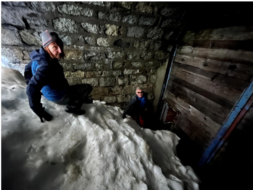
Vorsichtig rutscht Evelyn auf dem blanken Eis zum Durchlass im Tunnelort des Westportals des Scheiteltunnels.
