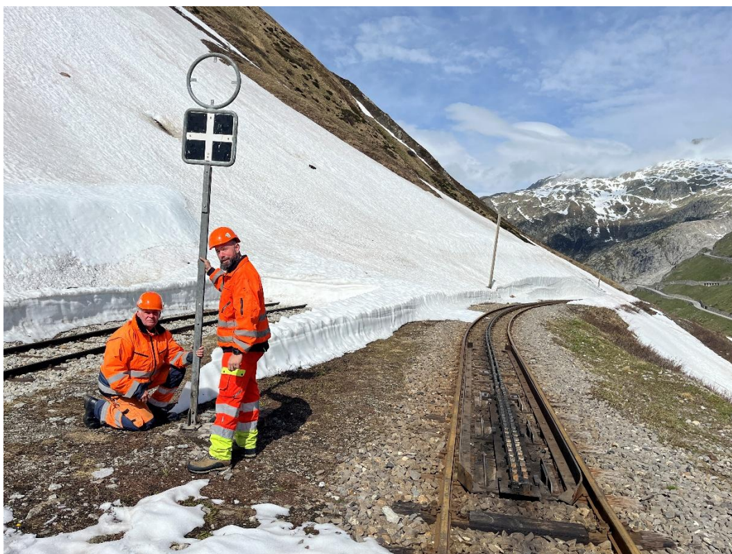
Thilo Fock und Martin Wieland bei der Montage der Merktafel S des Bahnhofs Muttbach-Belvédère. Die Merktafel S ist in Reparatur und wird vom Sicherungsanlagen-team nach Pfingsten montiert. Bild: Patrick Smit
