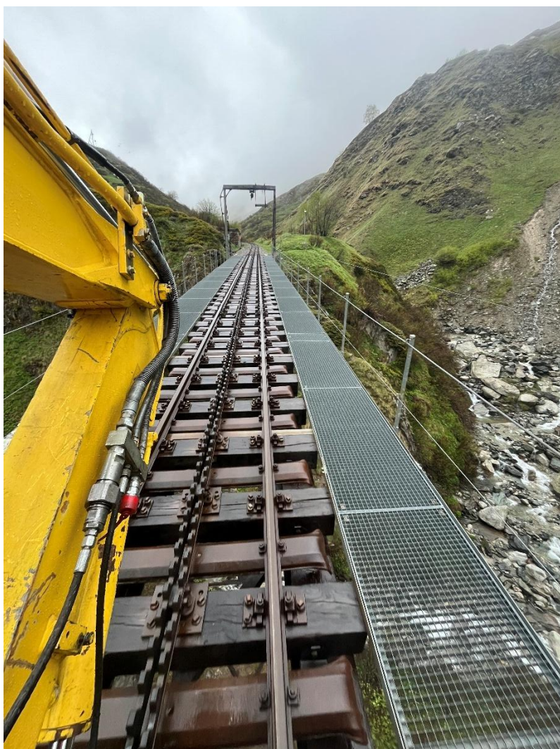
Der erste Bauzug passiert die Steffenbachbrücke nach Abschluss des Aufbaus am Vortag. Bild: Patrick Smit
