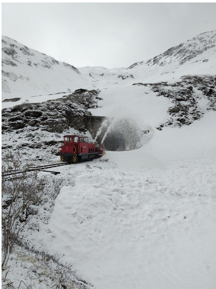
Die HGm 51 mit Anbaufräse vor dem Ostportal des Scheiteltunnels. Bild: Michel van Wallene
