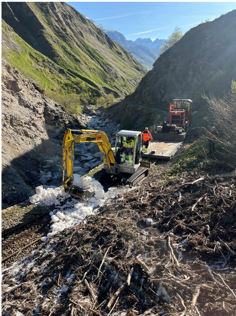
Das erste Hindernis unterhalb des Altsenn- tumstafeltunnels III: Ein kleiner «dreckiger» Lawinenkegel.
