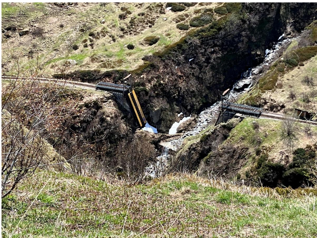
Die Steffenbachbrücke. Bild: Patrick Smit
