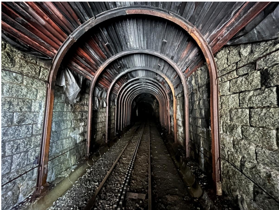
Im talseitigen Bereich des Altseentumstafeltunnels II.
