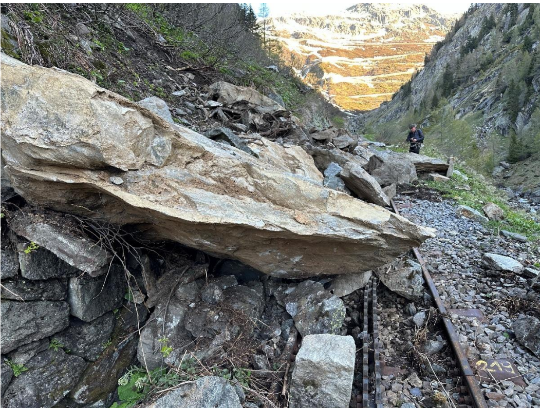
Felssturz zwischen km 44,1 und km 44,5.
