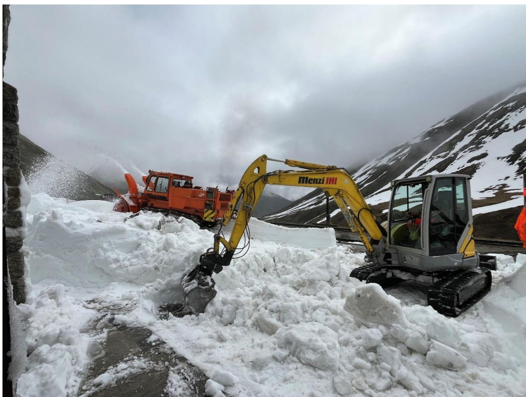
Mit dem Menzi Bagger erledigt Martin Wieland die Feinarbeit.
