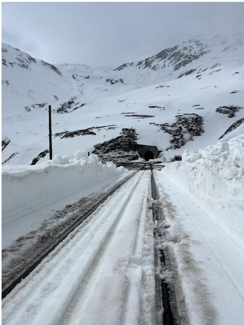
Blick vom Gleis 1 Höhe Vorplatz Richtung Ostportal Scheiteltunnel.
