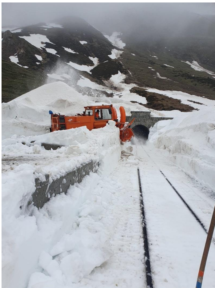
Nach 3 ½ Tagen sind die Bahnanlagen zwischen BUE Furkastrasse und Westportal Scheiteltunnel geräumt.
