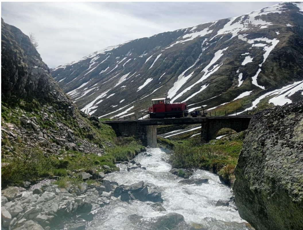
Die HGm 51 und Schmierwagen auf der Sidelenbrücke. Bild: Martin Wieland
