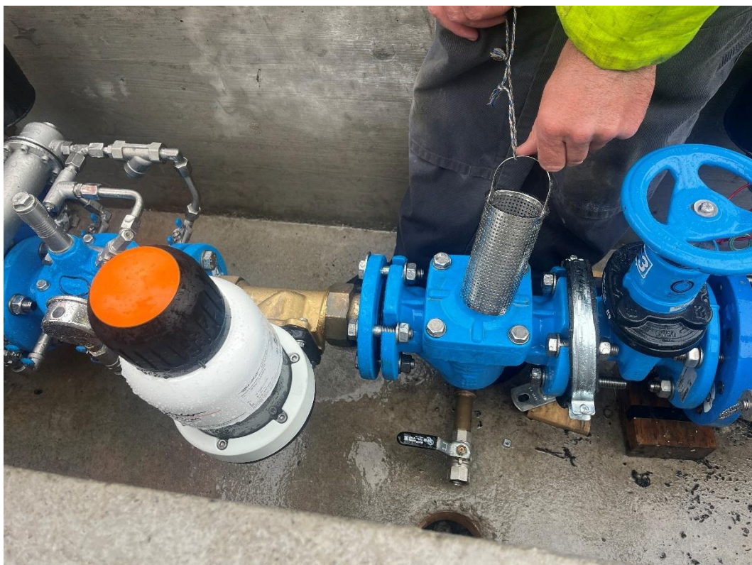
Weil die Wasserversorgung Gletsch viel Sand im Wasser führt, wurde neben der Erneuerung der DFB-Hauptzuleitung zusätzlich Sandfilter eingebaut.
