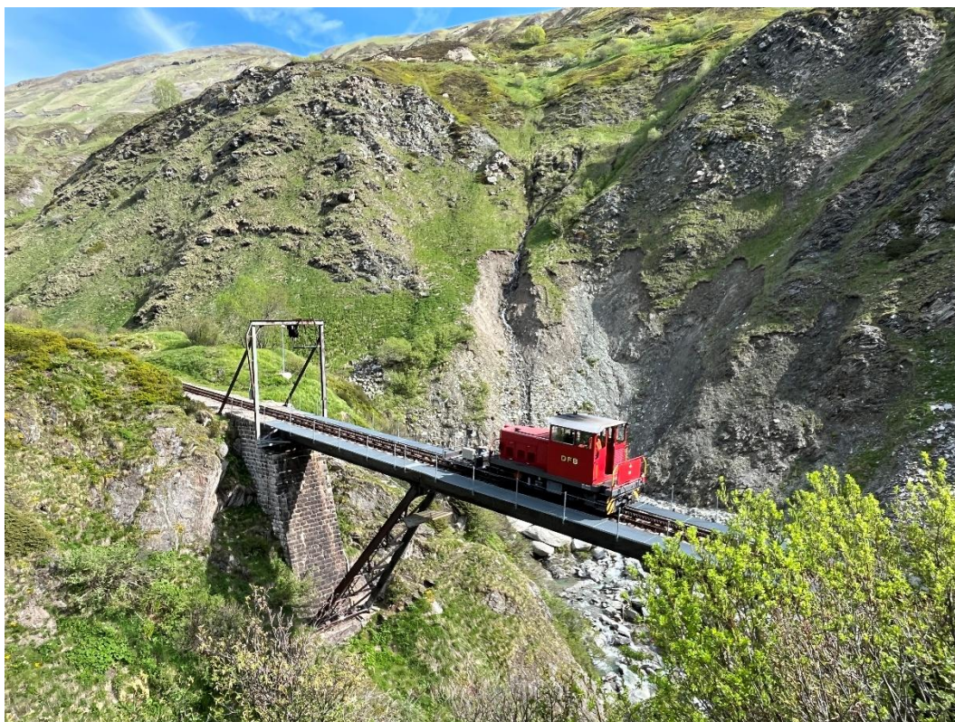
Schmierfahrt von Realp bis zur Wasserfassung 2 unterhalb des Kehrtunnels.
