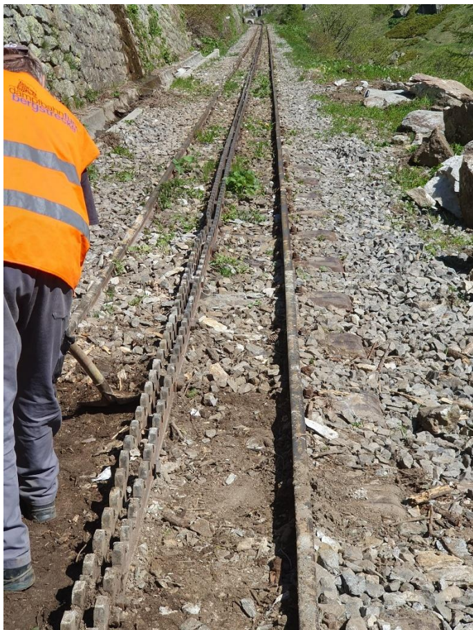
Alphonse Teuffer bei der Feinräumung der Schaden- stelle in der Rottenschlucht. Bild: Bruno Zimmermann
