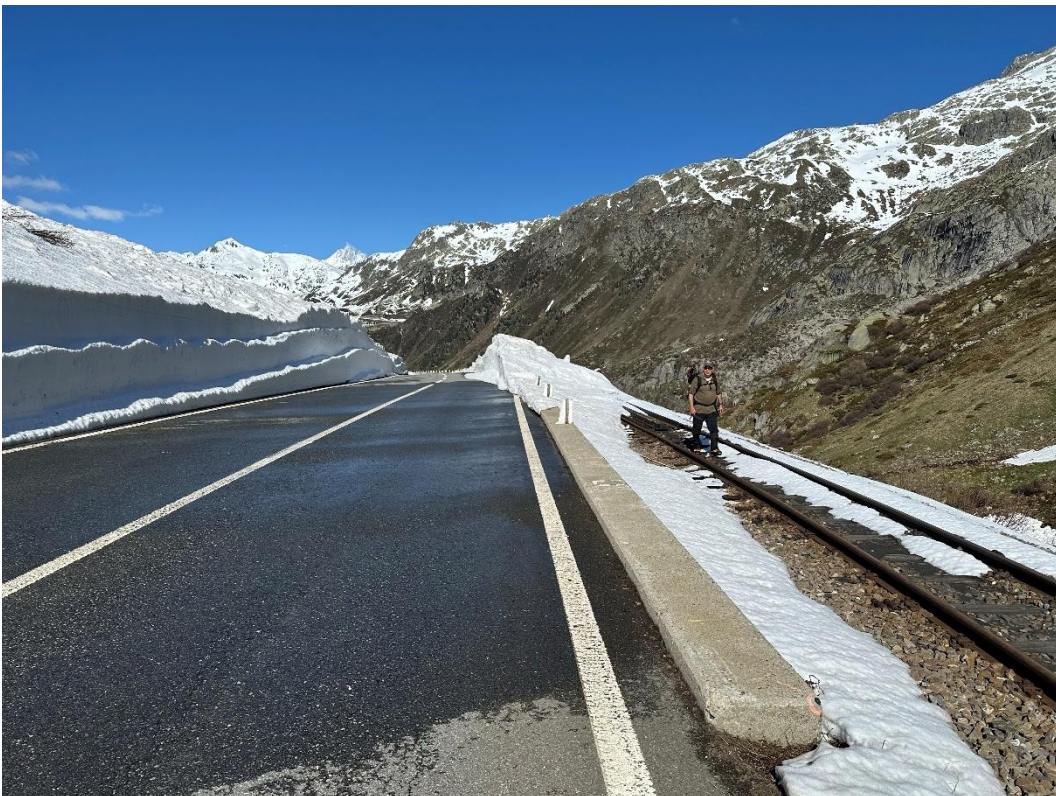
Talseitige Zahnstangen-einfahrt beim Bahnübergang Furkastrasse.
