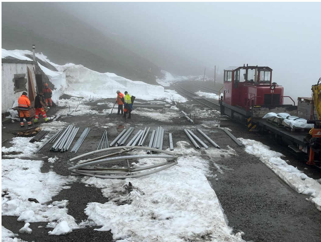
Nachdem das Schneeräumungsmagazin komplett ausgeräumt ist, liegen alle Stütz- und Traggerüste des Fest- und Grillzeltes sowie die Schalttafeln und Kanthölzer der Holzböden der Zelte auf dem Vorplatz des Bahnhofs Furka. Bild: Patrick Smit
