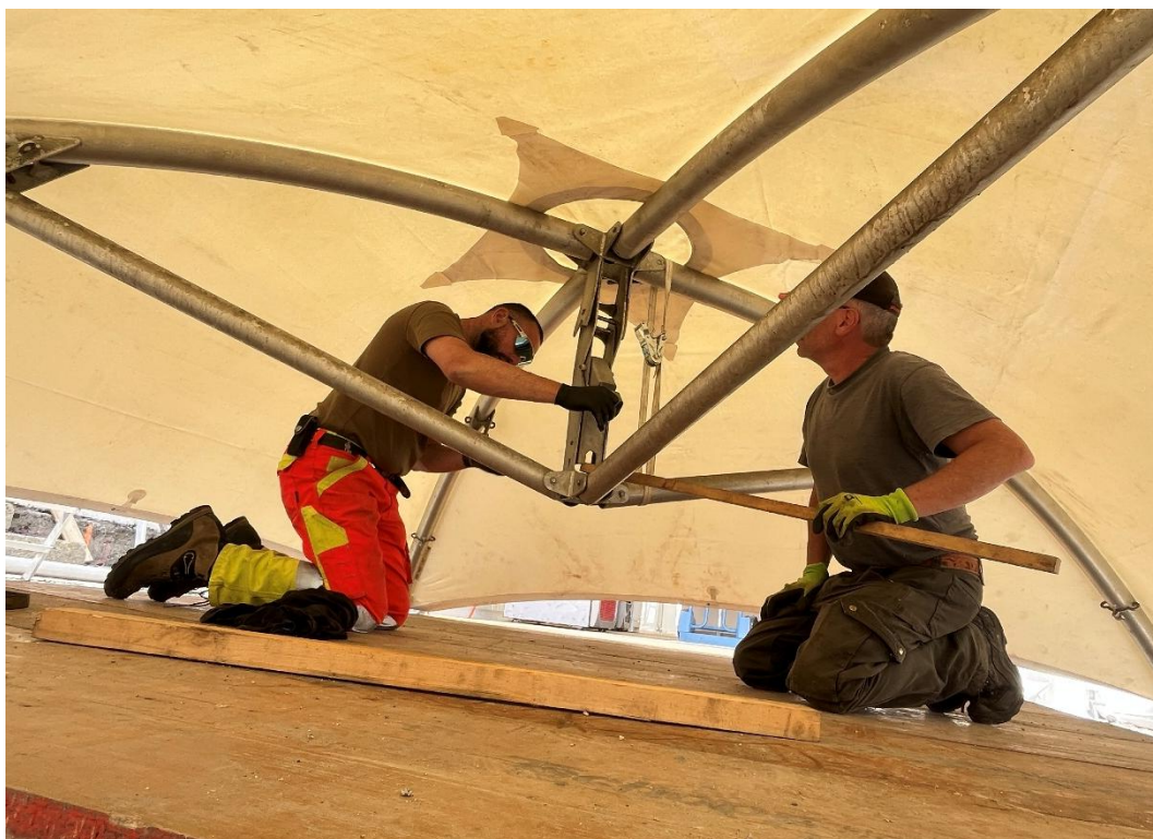
Martin Wieland und Martin Ermel spannen das Dach des Grillzertes auf. Bild: Patrick Smit
