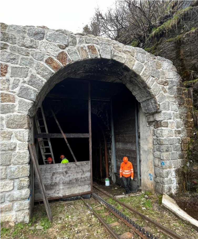
Demontage der Holzbalken des Tunneltors. Bild: Patrick Smit
