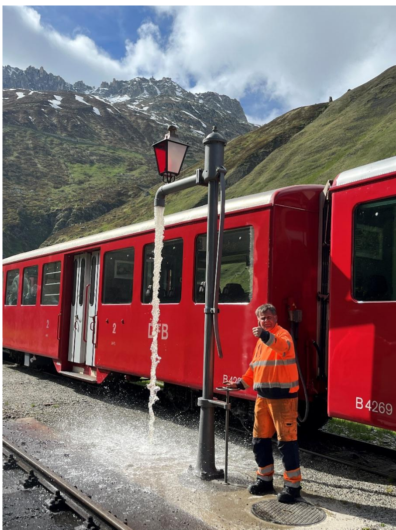
Nach gründlicher Spülung des Reservoirs und das Grundablasses nimmt Thilo Fock den Wasserkran Tiefenbach in Betrieb. Bild: Patrick Smit
