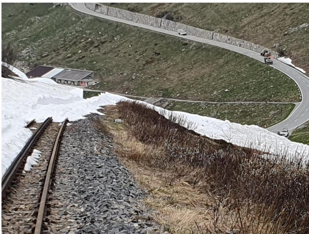
Das Tiefbauamt des Kantons Wallis beim Reinigen der Passstrasse und Einbau der Leitplanken oberhalb des BUe Furkastrasse.
