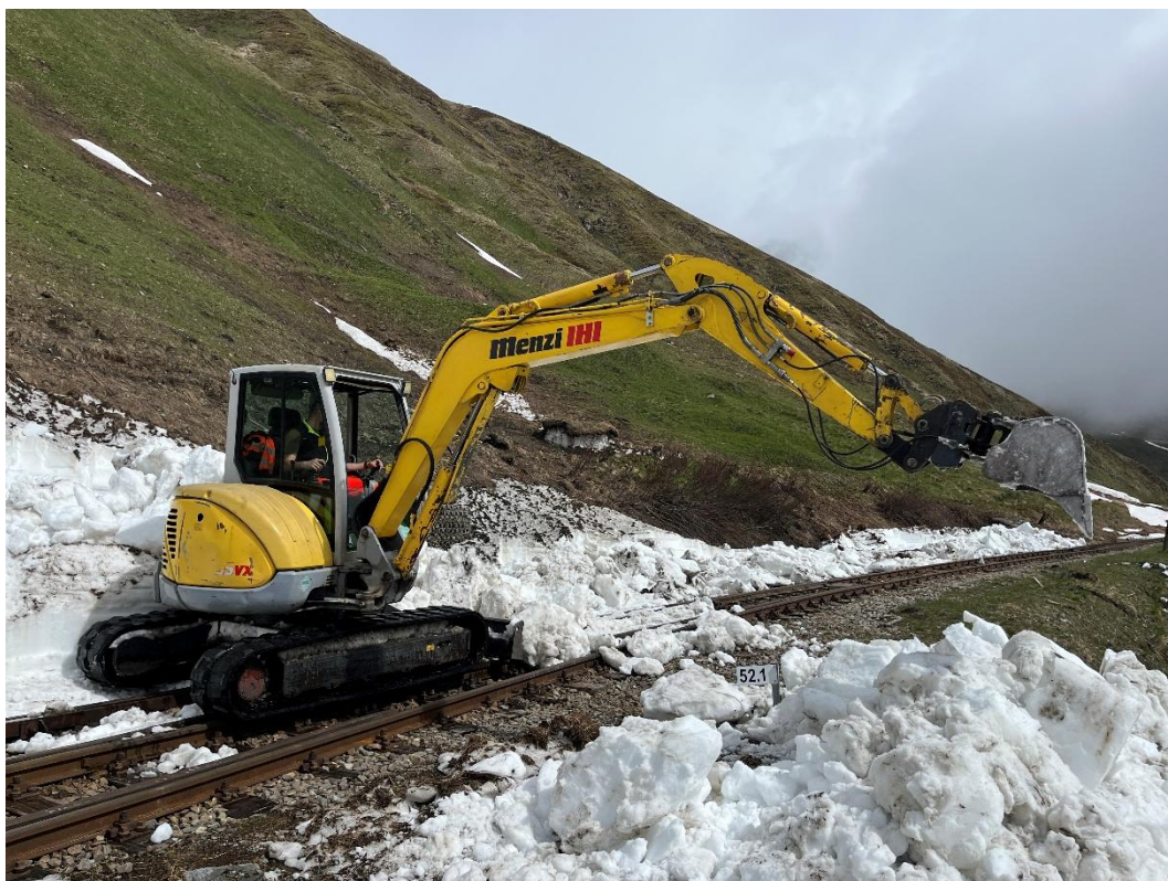
Mit dem Menzi Bagger räumt Martin Wieland den Restschnee vom Stumpen 21 des Bahnhofs Furka. Bild: Patrick Smit
