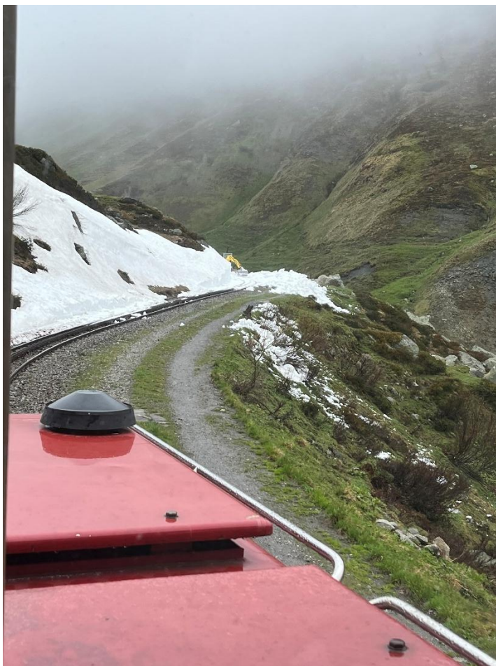
Die Wächte unterhalb des Steinstafelviadukts. Bild: Patrick Smit
