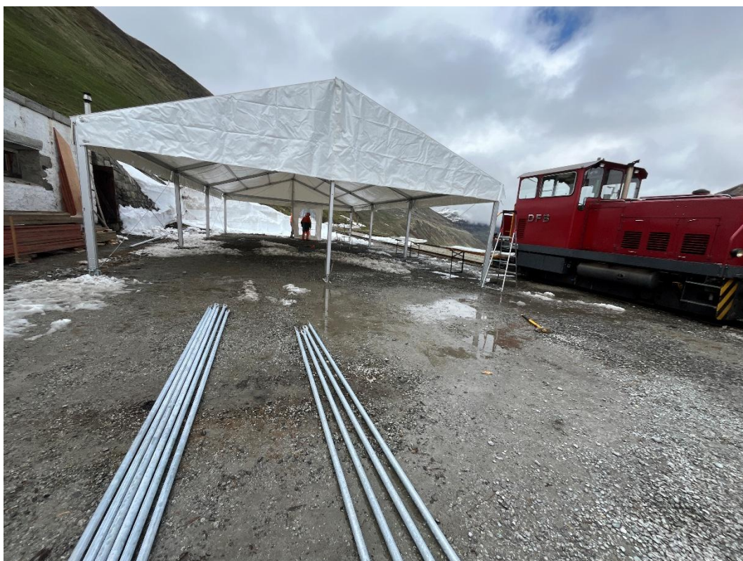
Das Dach des Festzeltes ist montiert. Bild: Patrick Smit
