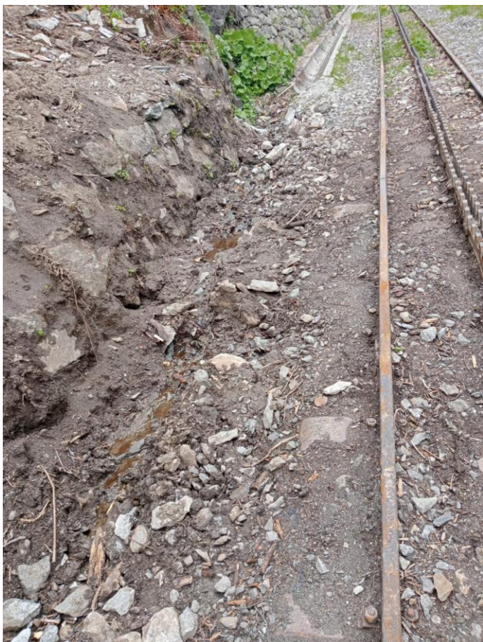
Der vom Felssturz in der Rottenschlucht verfüllte Wassergraben zwischen km 44,1 und km 44,5. Bild: Martin Wieland
