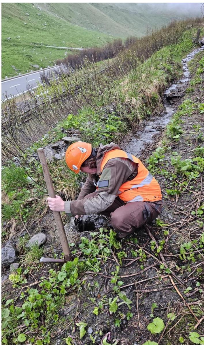
Thomas Lindenberg beim Freilegen eines Wasserablaufs oberhalb des Bahnübergangs Furkastrasse.
