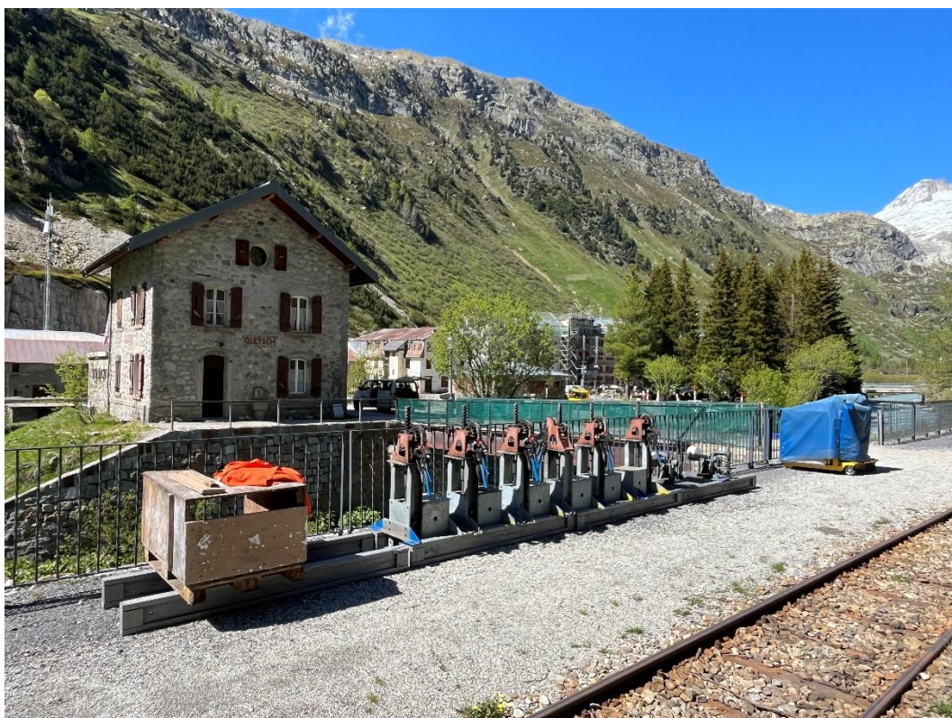
Die Weichenböcke werden nach Pfingsten vom Sicherungsanlagenteam montiert.
