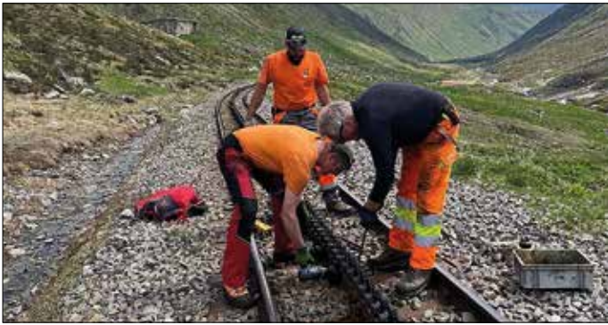
Gleisbaueinsatz im Fronarbeiter-Team Fotos: Archiv DFB (4)
