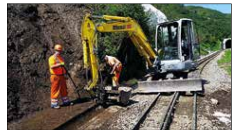
Unterhalt Entwässerung u. Bachdurchlässe
