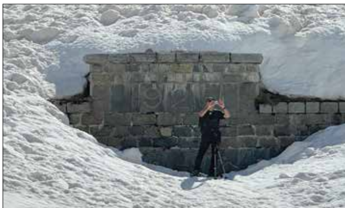
Westportal des Furka-Scheiteltunnels (22. Mai 2024)
