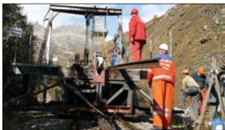
Abbau der Steffenbach-Klappbrücke
