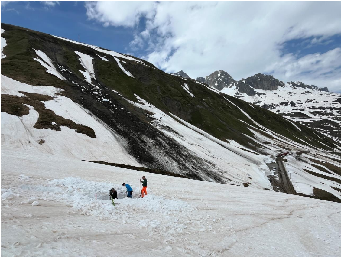
Suche des Wasserreservoirs des Bahnhofs Furka. Das schwarze Band über dem Bahnhof Furka stammt von der Gleitschneelawine, die während den Auswinterungsarbeiten vor einer Woche völlig überraschend niedergegangen ist. Bild: Patrick Smit
