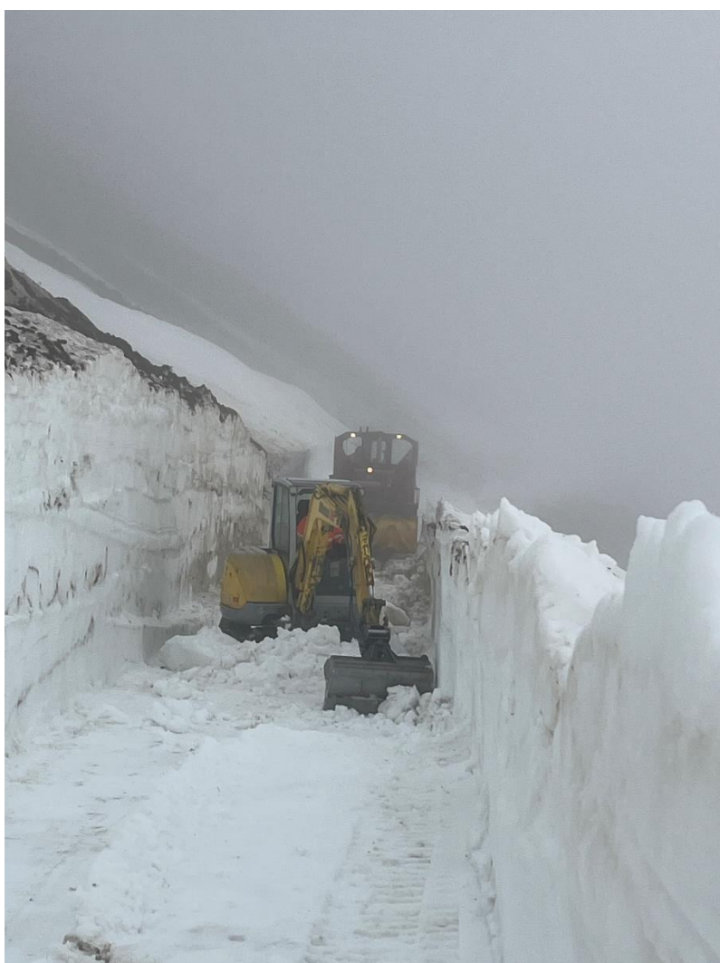
Der Bagger muss den an der Basis stark vereisten Schnee aufbrechen. Bild: Patrick Smit
