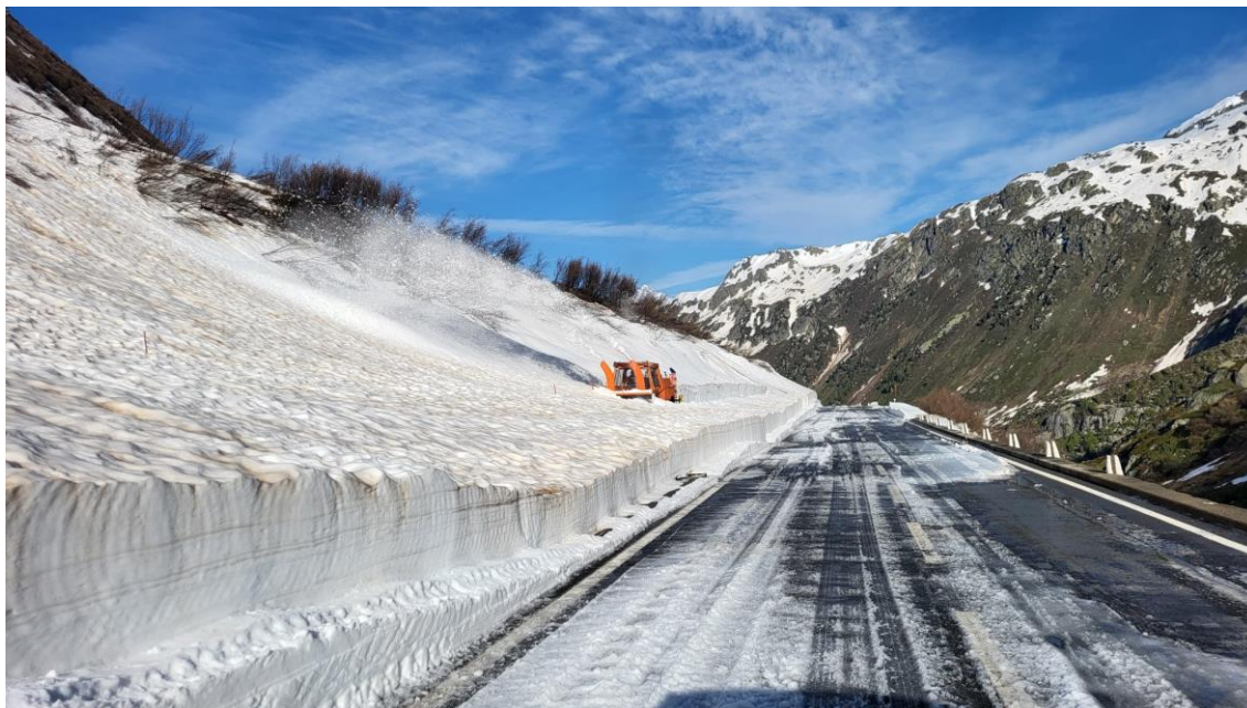
6.6.2024 Räumung beim Bahnübergang Fur- kastrasse. Bild: Daniel Brand
