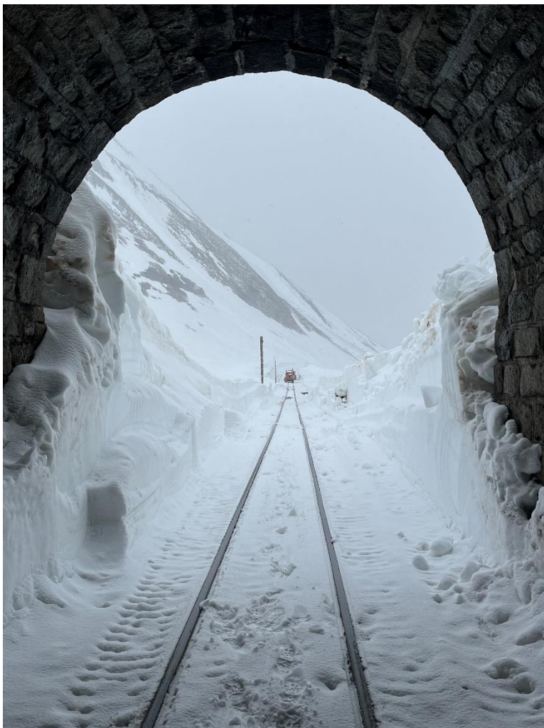
Blick vom Westportal des Scheiteltunnels zum Bahnhof Muttbach-Belvédère.
