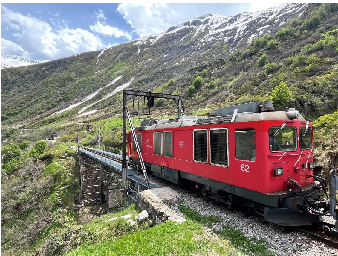
Bei der Steffenbachbrücke machen wir Halt, um die Fussgängerbrücke des Wanderweges über den Steffentalbach zu montieren. Da der Bach viel Schmelzwasser führt ist die Montage zurzeit nicht möglich. Bild: Patrick Smit
