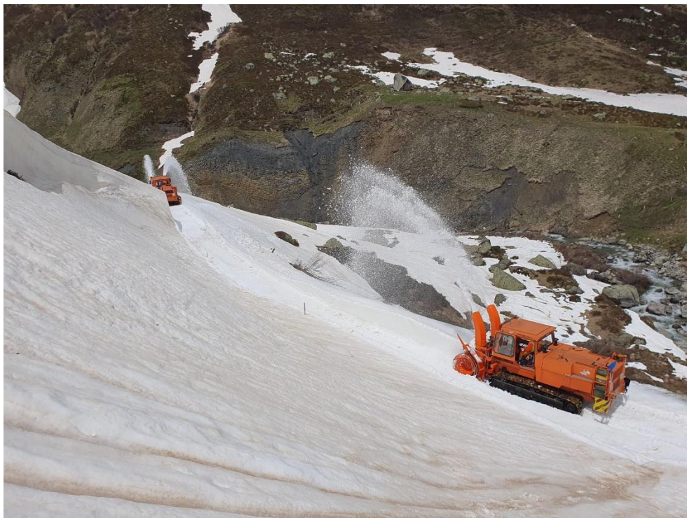
Die beiden INTRAC Raupenfräse in der Wächte unterhalb des Steinstafelviadukts. Bild: Michael Bühler
