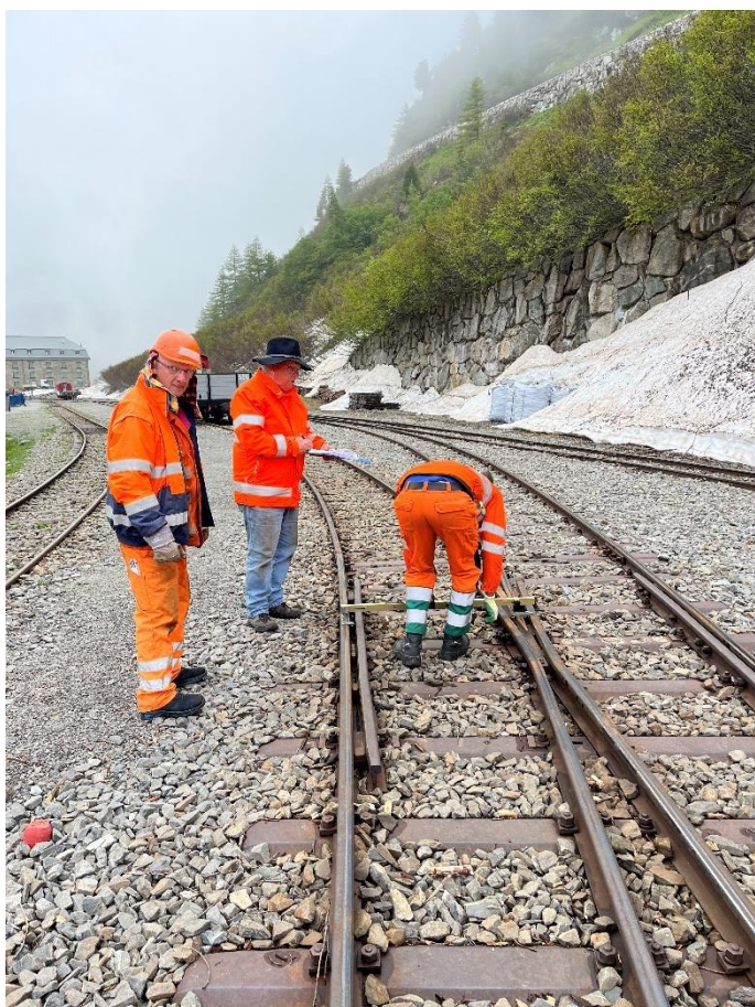
11.6.2024 Hanspeter Süss beim Einmessen der Maasse der Weichen des Bahnhofs Gletsch. Bild: Patrick Smit
