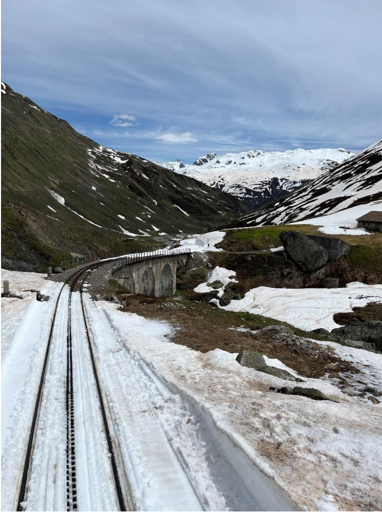
Steinstafelviadukt. Bild: Patrick Smit
