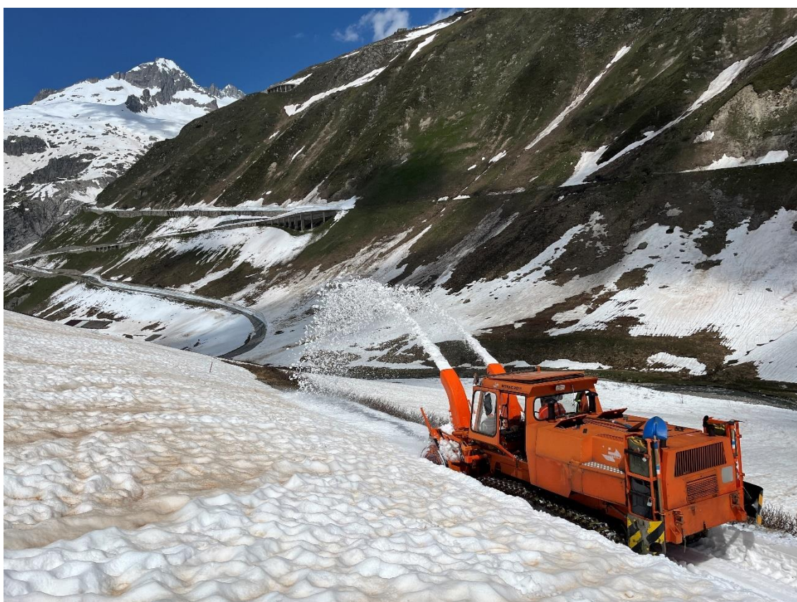
Zur Schonung des Gleises wirft Stephan Stauber den Schnee auf das Gleis, wenn dieses bereits sichtbar ist. Bild: Patrick Smit
