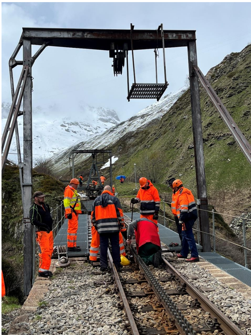
Während ein Team die Zahnstangen am talseitigen Brückenelement verschraubt... Bild: Patrick Smit
