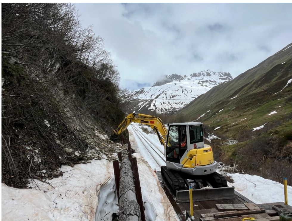
Pascal Rauber räumt den Geröllfänger unterhalb der Wasserfassung Tiefenbach aus. Anschliessend wird der Bagger in Tiefenbach abgestellt. Bild: Patrick Smit
