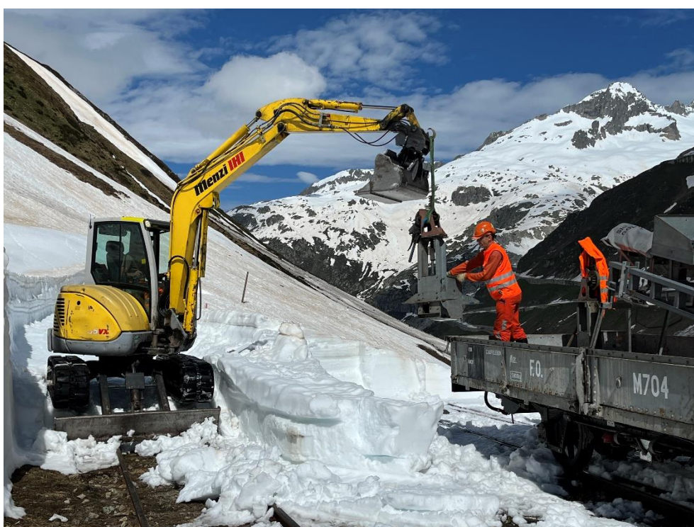
Martin Wieland (Baggerführer) und Andreas Kessler montieren den Weichenbock der Weiche 21 des Bahnhofs Muttbach-Belvédère. Bild: Patrick Smit
