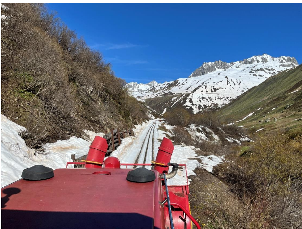
Fahrt am Sonntagmorgen zur vordersten Arbeitsstelle beim Steinstafelviadukt. Vor zwei Wochen lag hier noch bis 2 m Schnee.
