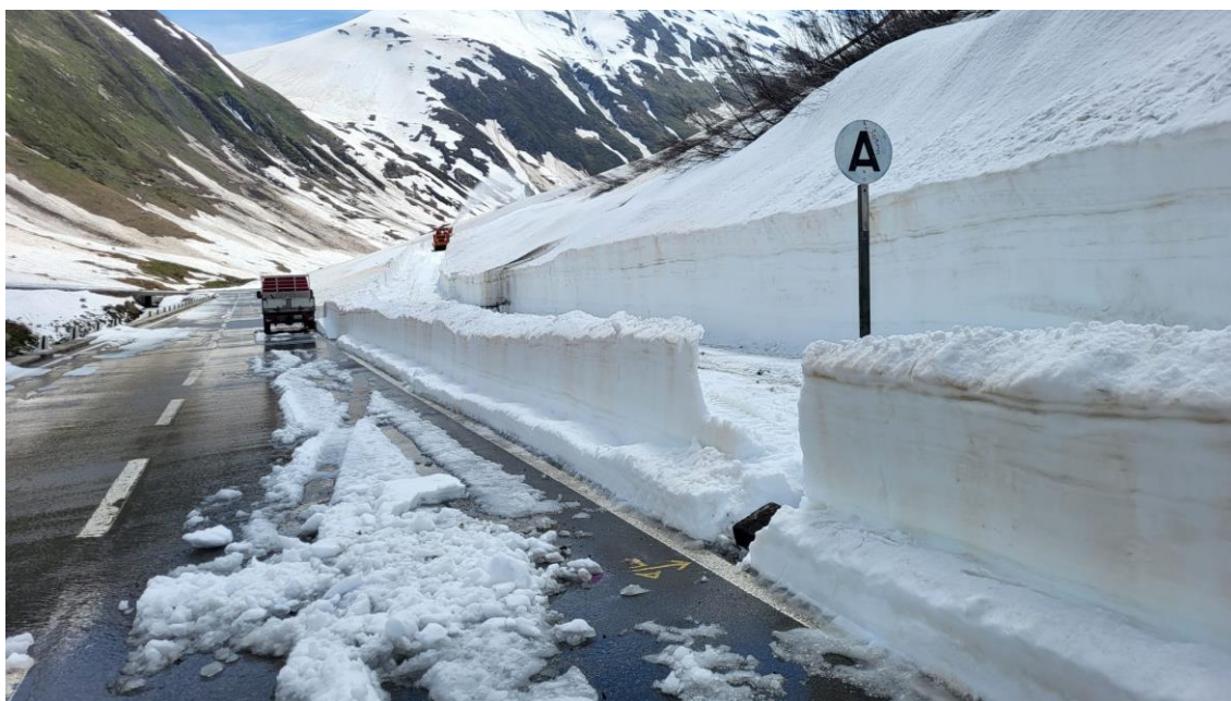
6.6.2024 Martin Wieland und Daniel Brand haben die bergseitige Zahnstangenein- fahrt des Bahnüber- gangs Furkastrasse geräumt. Bild: Daniel Brand
