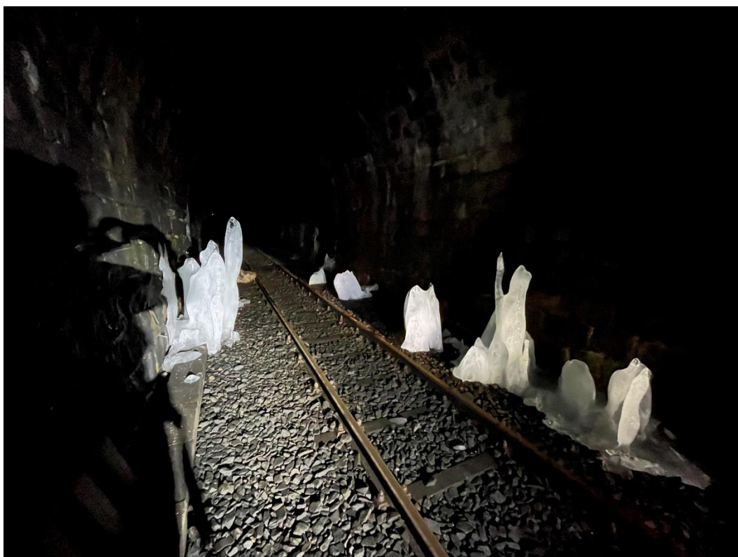
Eis-Stalagmiten im Bereich des Westportal des Scheiteltunnels.
