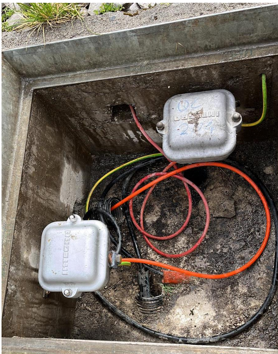
Das Sicherungsanlagenteam prüft und reinigt die Isolierstellen sowie die Verkabelung des Streckenblocks des Scheiteltunnels. Bild: Christoph Suter
