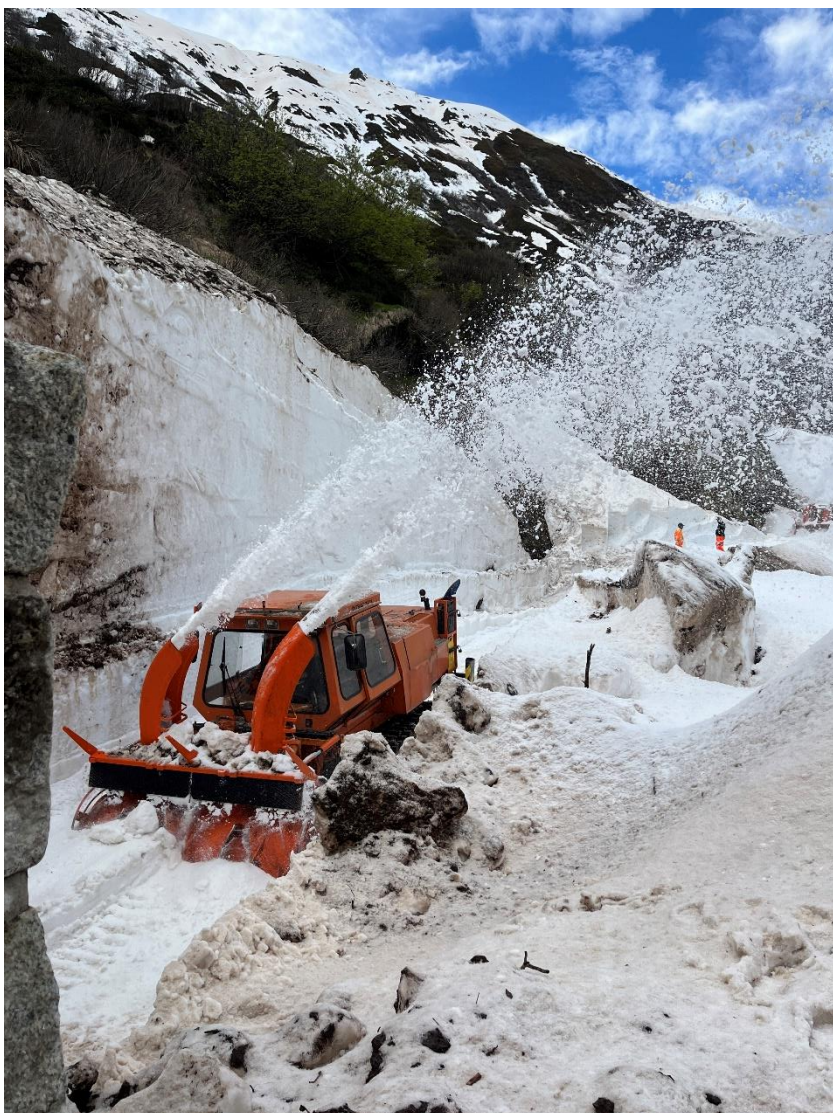
Stephan Stauber vor dem bergseitigen Portal des Tunnels 2. Bild: Patrick Smit
