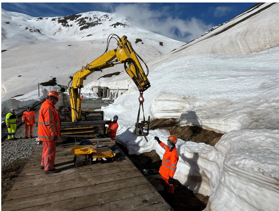
Montage des repara- tierten Weichenhe- bels, der während der Schneeräu- mung demoliert wurde. Zukünftig werden alle Wei- chenhebel im Herbst demontiert.
