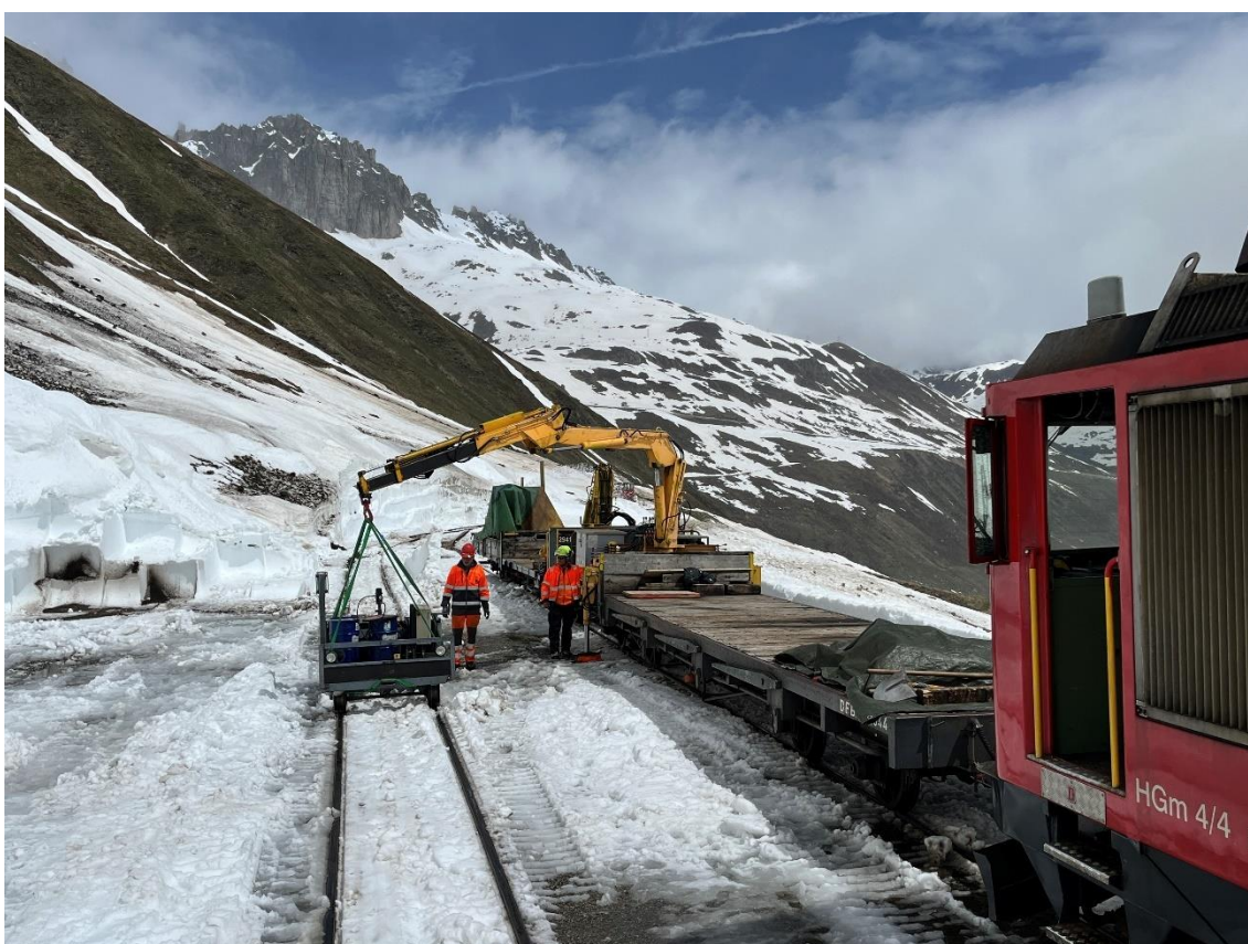
Ernst Demonti und Eric Fornallaz verladen den Schmierwagen auf den Kranwagen «Kari».
