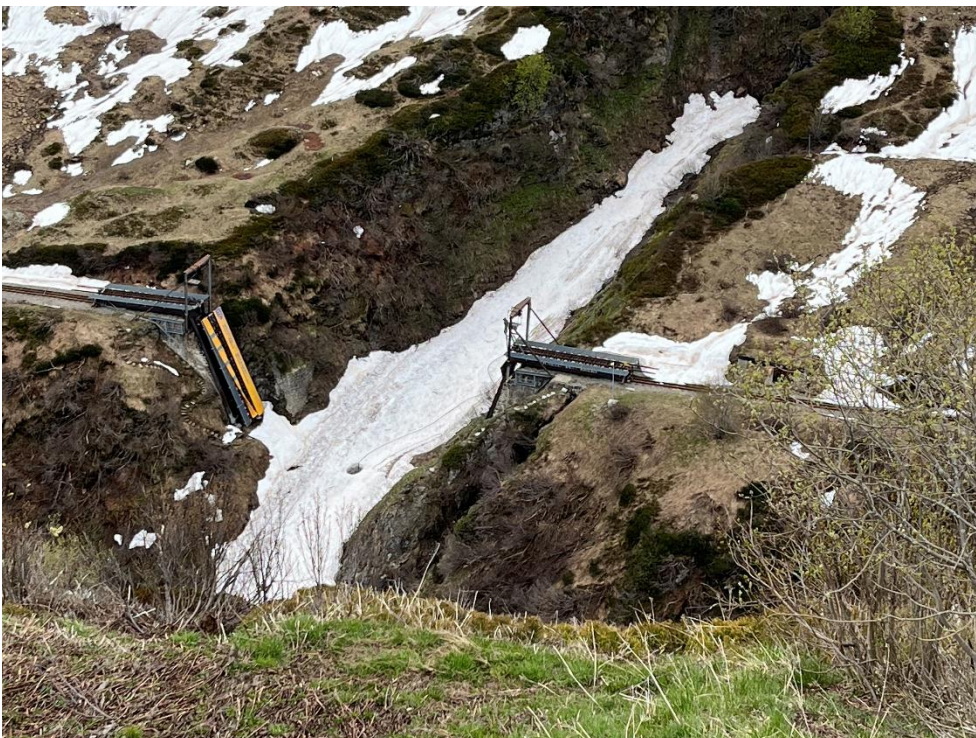
Das Steffenbachtobel im Bereich der gleichnamigen Klappbrücke. Der Wassereintrag, den Stephan Stauber vier Tage vorher mit Feuerwehrschräuchen montiert hat, hat ein Loch durch den rund 3 m mächtigen Lawinenschnee «gefressen». Bild: Patrick Smit
