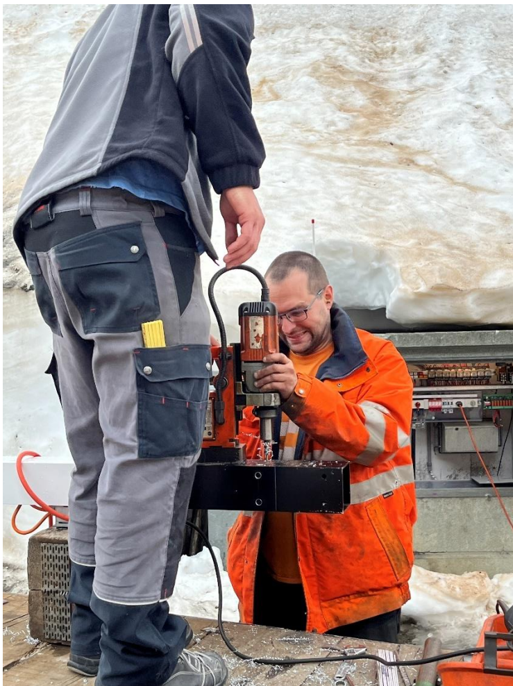
Marcel Gwerder und Gabriel (Kollege von Oliver Rusterholz) beim Kürzen der neuen Signale des Bahnübergangs Furkastrasse.
