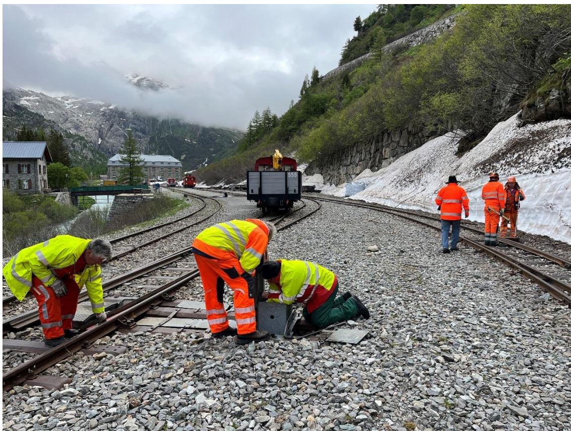
Guido Tresp (von links), Werner Spahni und Daniel Feyer montieren den letzten Bolzen eines Weichenbocks im Bahnhof Gletsch.
