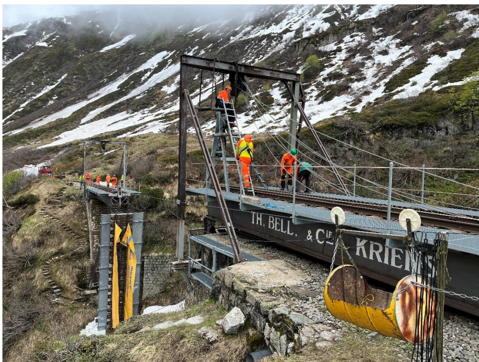
... zieht ein anderes Team die Seile in die Rollen des bergseitigen Brückenelements ein. Bild: Patrick Smit
