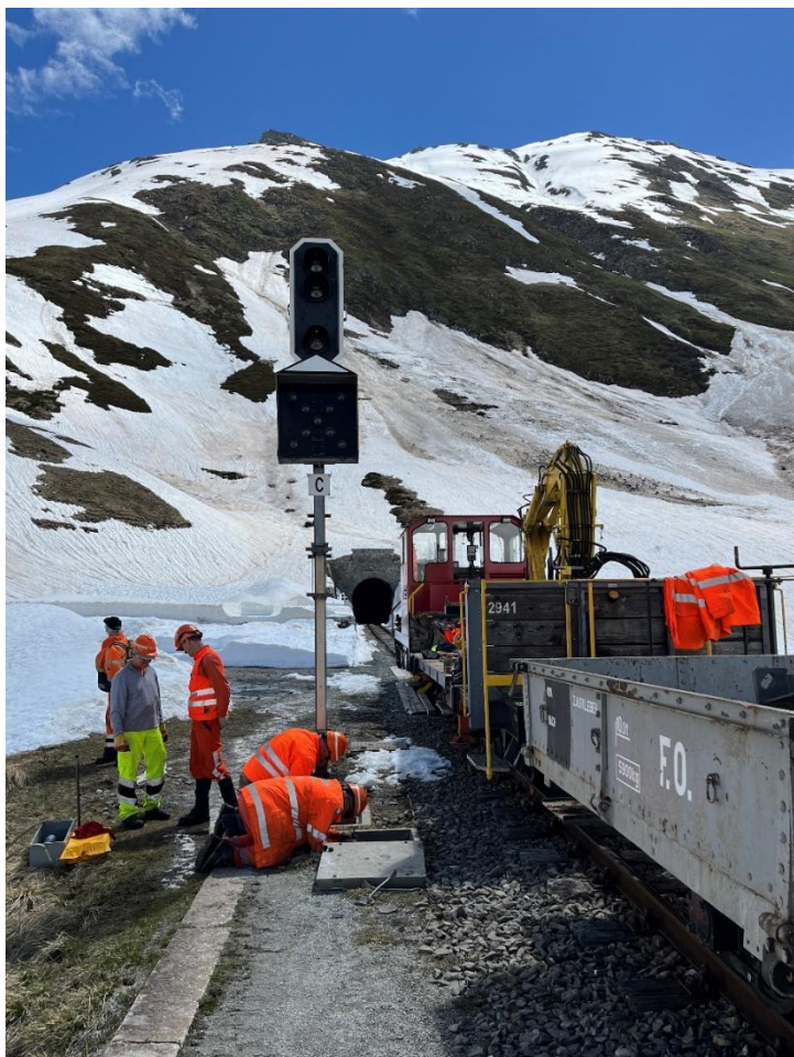
Montage des Ausfahrsignals des Bahnhofs Muttbach-Belvédère.
