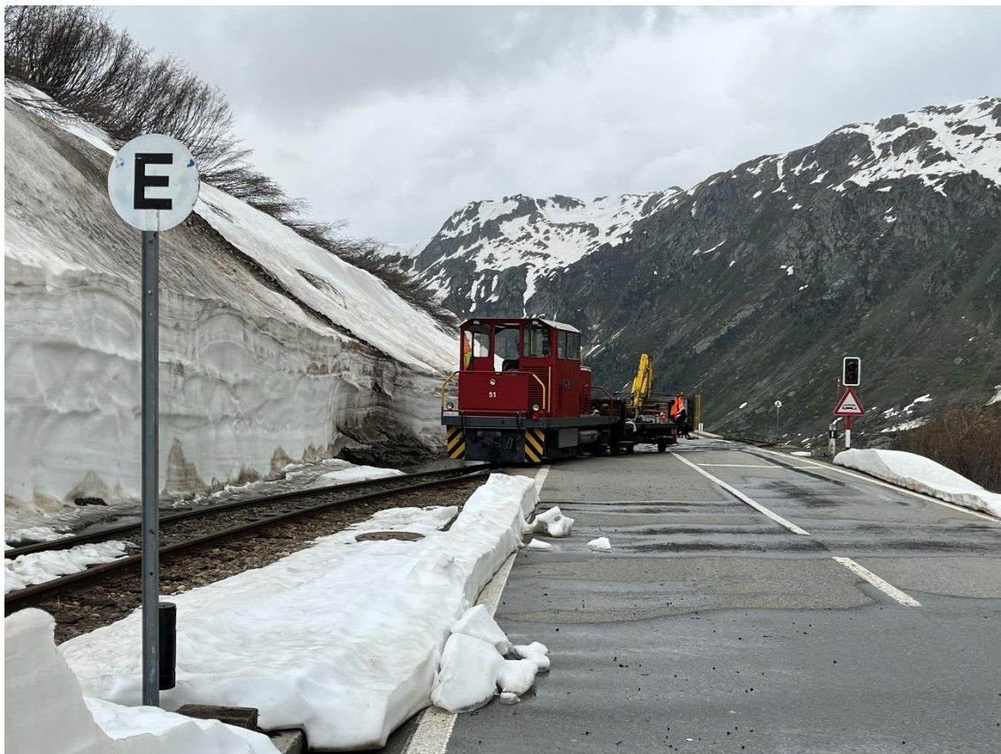
Während den Montage- und Auswinterungsarbeiten fahren rund ein Dutzend Velofahrer Richtung Furkaspas vorbei. Da die Passstrasse noch nicht fertig geräumt und für den Privatverkehr freigegeben ist, sehen wir die Velofahrer nach kurzer Zeit wieder. Bild: Patrick Smit
