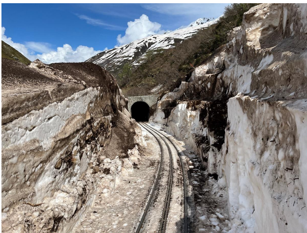
... «dreckiger» Schnee zwischen Tunnel 2 und Tunnel 3.
