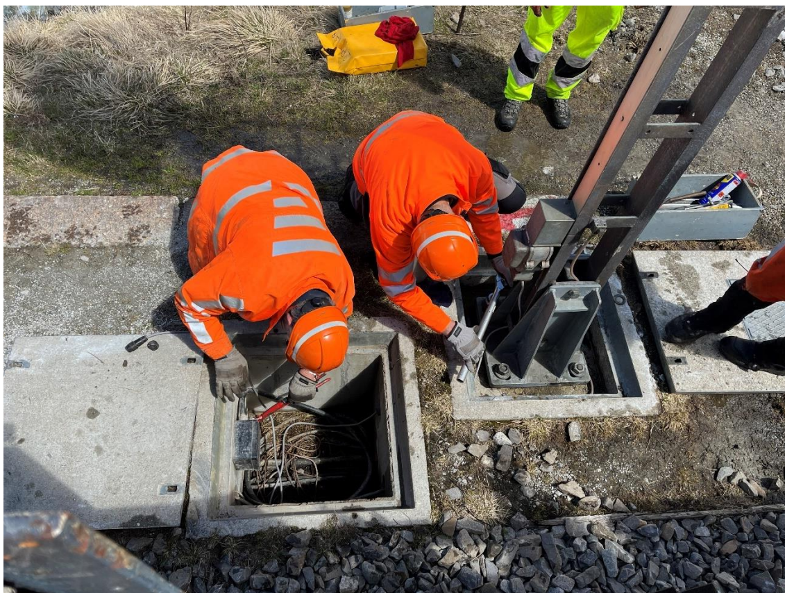
Guido Tresp und Andreas Kessler bei der Montage des Ausfahrsignals des Bahnhofs Muttbach-Belvédère.
