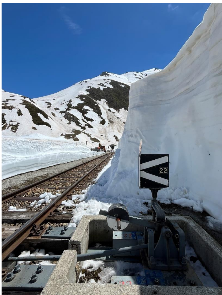
Das Weichensignal der Weiche 22 hinter einer noch knapp 2 m mächtigen Schneedecke.
