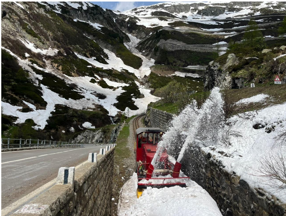
Um die Mittagszeit schliesst die HGm 51 mit Anbaufräse die Schneeräumung der Bahnleise beim bergseitigen Portal des Kehrtunnels ab. Bild: Koen de Decker
