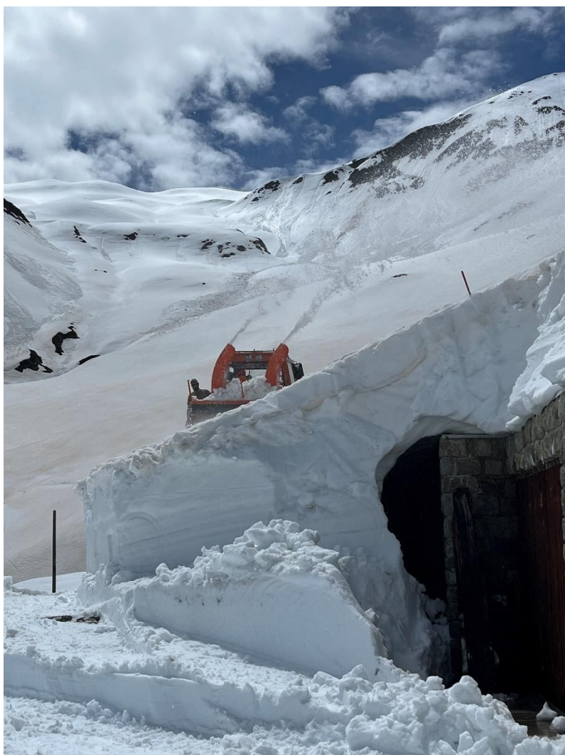
Der Hohlraum zwischen Relaisgebäude, die Neigung, die Platzverhältnisse und der wenig tragfähige Frühjahrsschnee macht die Räumung auf der «Empore» anspruchsvoll.
