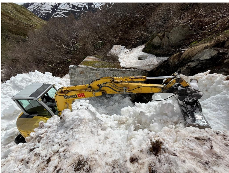
Am bergseitigen Portal des Tunnels 1 baggert Alexander Briner eine Rampe für die INTRAC Raupe. Bild: Patrick Smit
