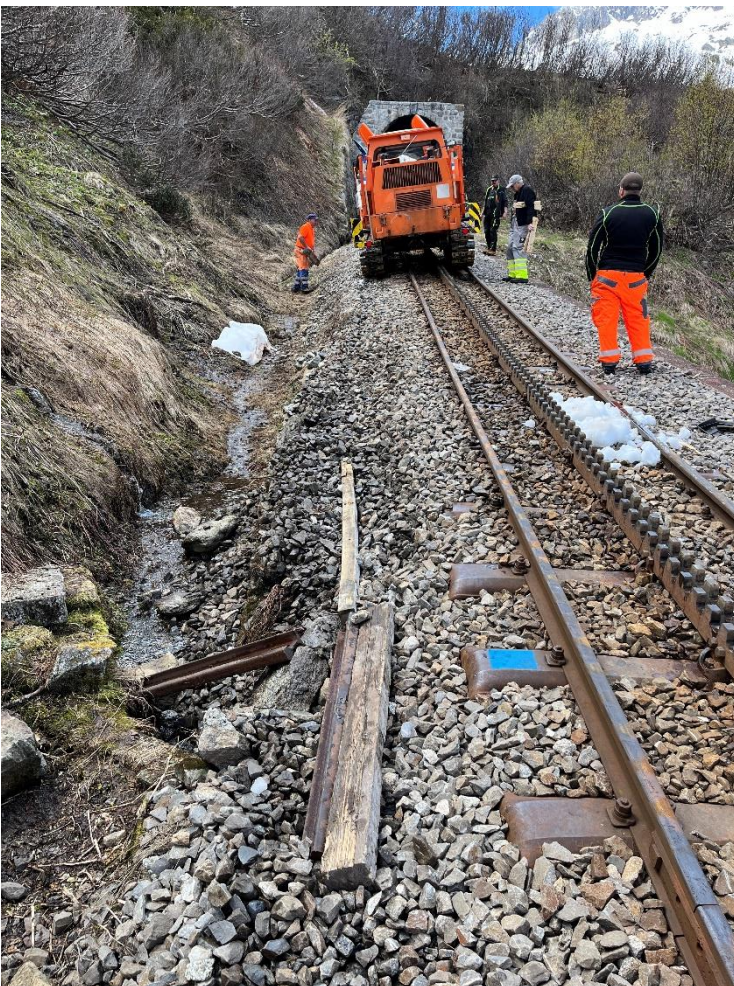
Die INTRAC Raupenfräse auf dem beschwerlichen Weg zum nächsten Einsatzort oberhalb des Tunnels 1.
