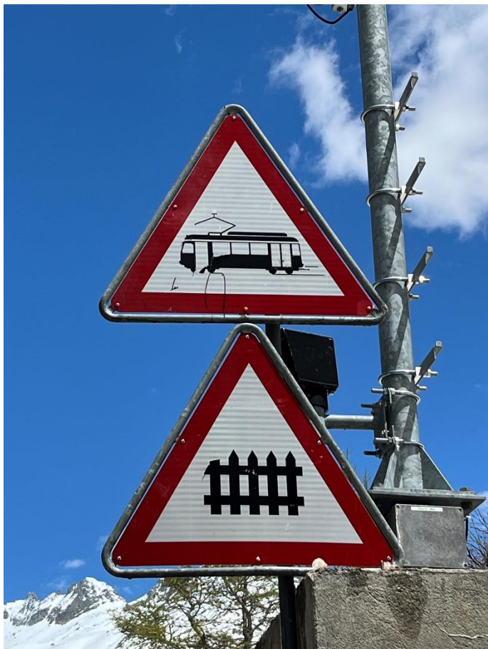
Das Verkehrssignal des Bahnübergangs Rotten wurde vom Schnee ramponiert. Bild: Patrick Smit
