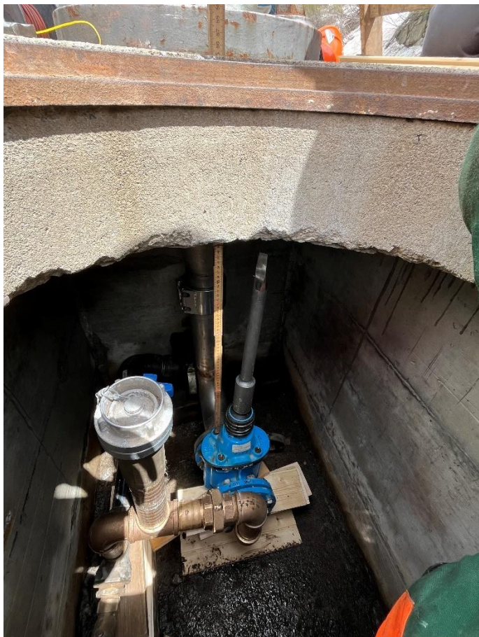
Der Doppel-Meter markiert die Soll-Lage des Spindels. Bild: Patrick Smit
