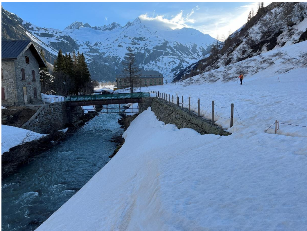
Die Fussgängerbrücke des Bahnhofs Gletsch. Bild: Patrick Smit
