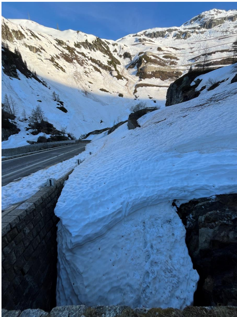
Blick vom bergseitigen Portal des Kehrtunnels Richtung Grimsel-Passhöhe.
