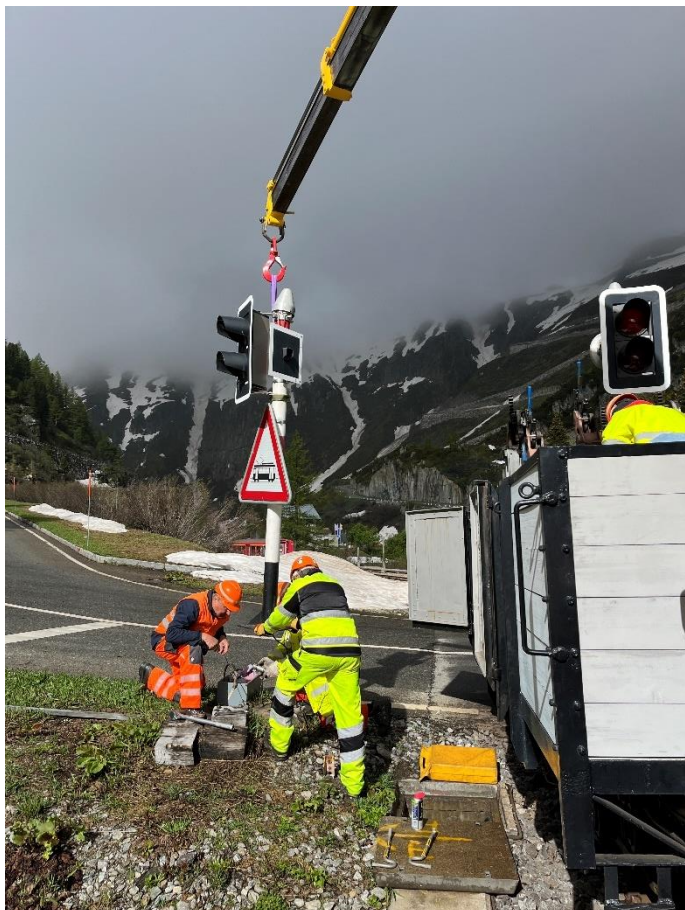
Montage des bergseitigen Signals des Bahnübergangs Blauhaus. Bild: Patrick Smit
