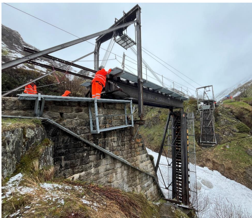
Langsam bewegt sich das talseitige Brückenelement in die Endlage.
