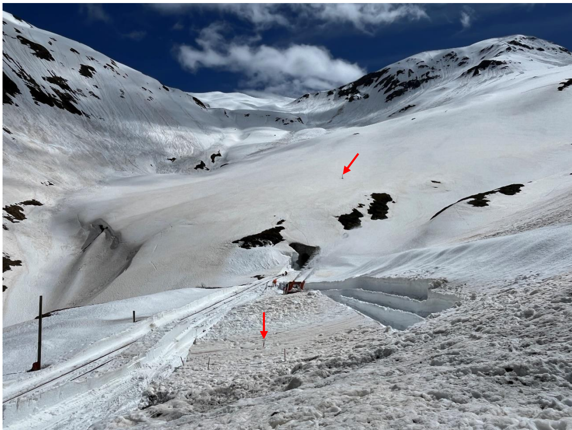
Der untere rote Pfeil markiert den Mittelpunkt der Drehscheibe, die unter 3 m Schnee liegt. Der obere Pfeil zeigt den Standort des Reservoirs der Wasserversorgung des Bahnhofs Furka. Bild: Patrick Smit
