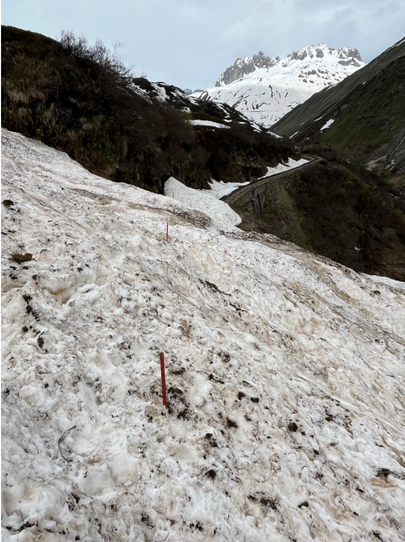
Auf dem ca. 5 m hohen Lawinengegels vor dem bergseitigen Portal des Tunnels 1 haben die Vermesser Hans-Ludwig Schneider und Luc Wullschleger die Gleisachse bereits eingemessen und mit Holzpflocken markiert. Bild: Patrick Smit
