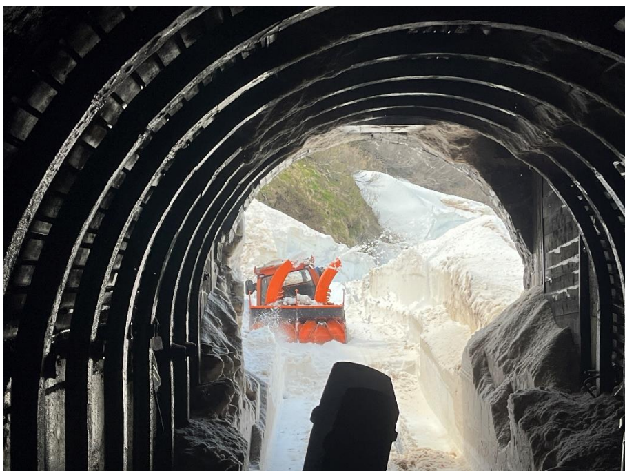
Währenddessen warten Andreas Schuler und Patrick Smit mit der HGm 51 mit Anbaufräse im Tunnel 2 auf ihren Einsatz.
