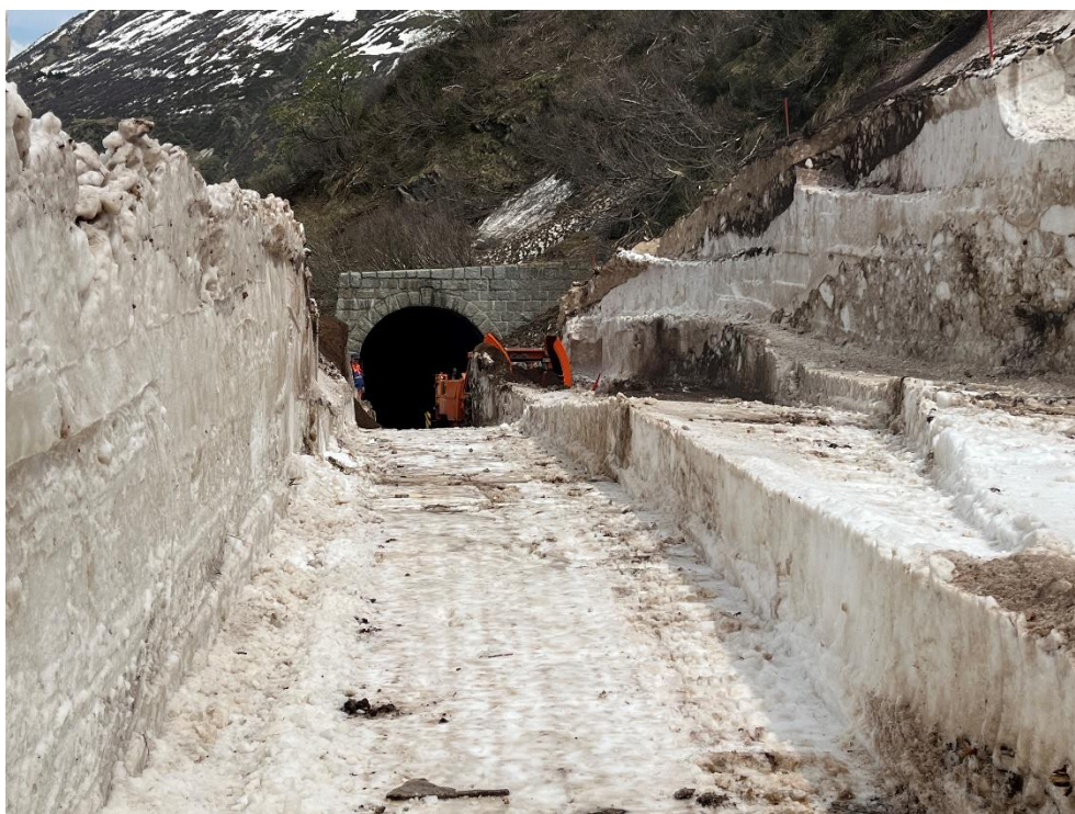
Die geräumte Oberfläche besteht aus stark vereistem Lawenschnee. Entsprechend gross ist die Sturz- und Rutschgefahr. Bild: Patrick Smit
