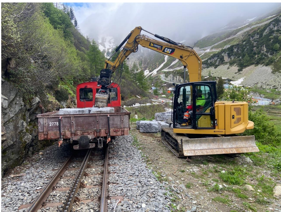
Tobias Hardmeier führt die Granitquader für die Reparatur der beschädigten Trockenmauer auf. Mit einem Mietbagger platziert Beat Suter die Steinquader. Bild: Tobias Hardmeier
