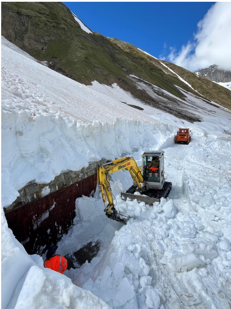
Der mit braunen Holzbohlen verrammelte Eingang zu den Toiletten des Bahnhofs Furka. Auf den Gebäudedächern liegt 3 m Schnee. Bild: Patrick Smit
