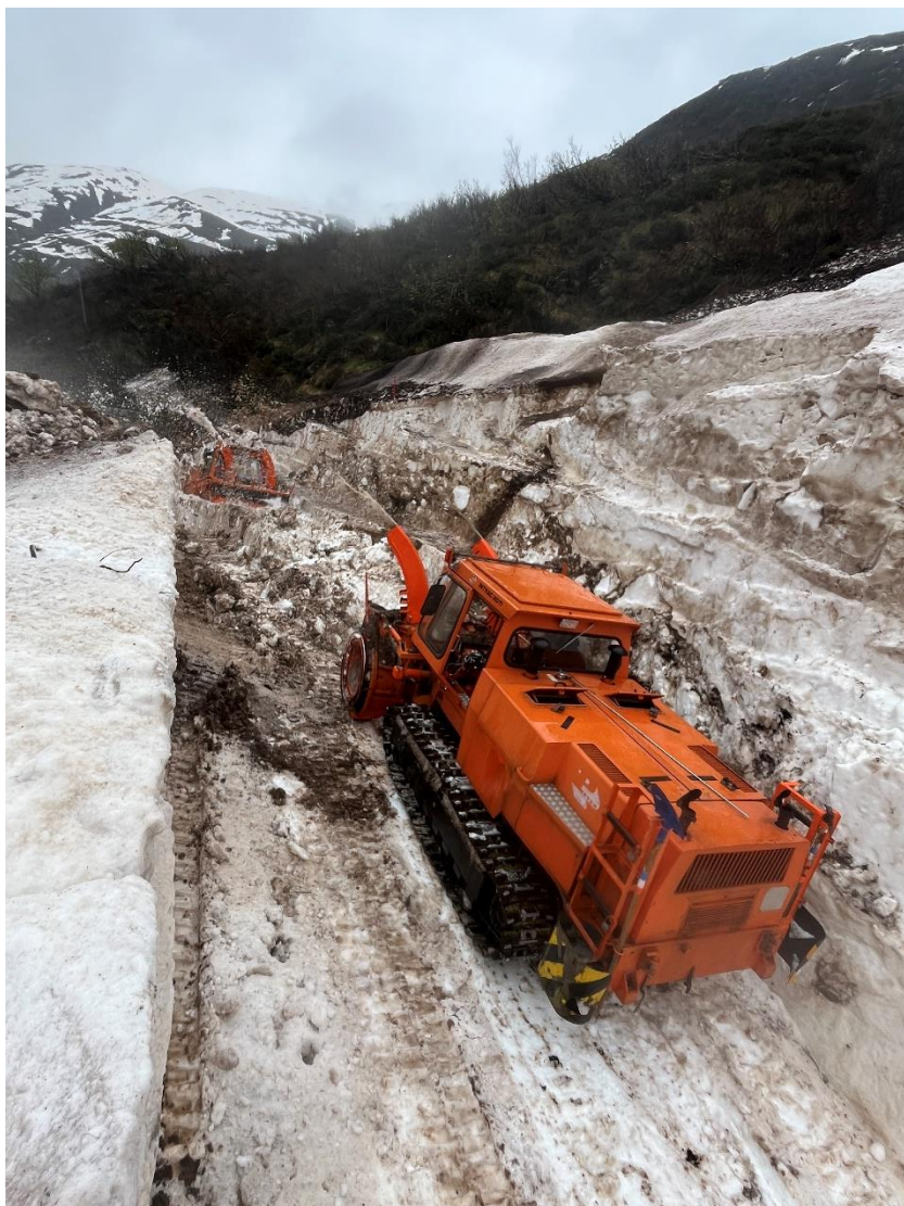
Zentimeter um Zentimeter «wühlen» sich die beiden INTRAC's zwischen Tunnel 3 und Tunnel 2 durch den «dreckigen» Lawinschnee. Bild: Patrick Smit
