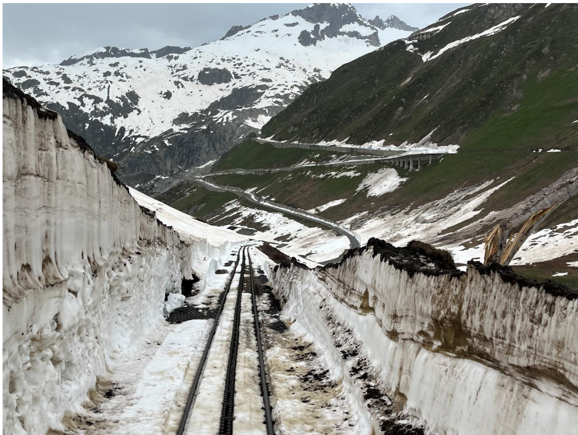
Zwischen Bahnhof Muttbach-Belvédère und Bahnübergang Furkastrasse. Bild: Patrick Smit
