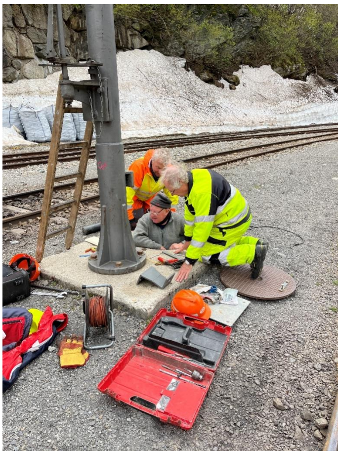
Die Montage des Wasserkrans 1 und der neuen Spindel hat viel Zeit gekostet, weil der Schieber zuerst gerichtet werden musste. Bild: Patrick Smit
