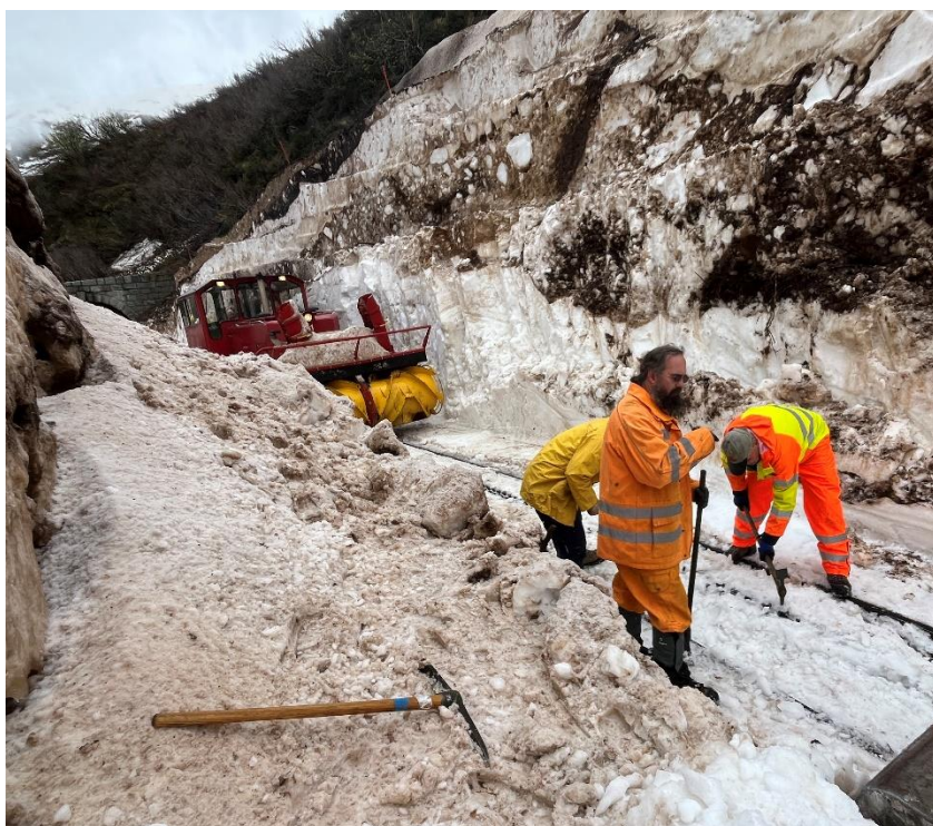
Immer wieder müssen Zahnstange und Schiene von Hand vom Eis befreit werden. Bild: Patrick Smit
