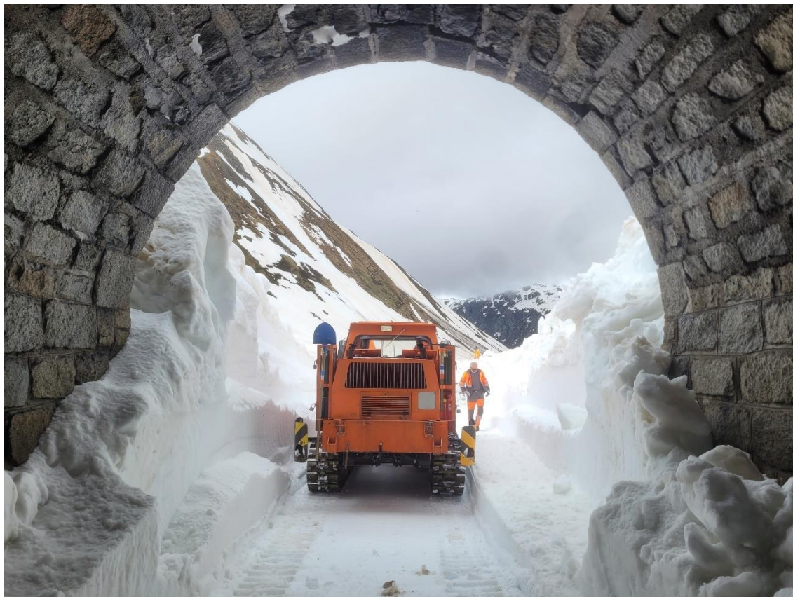
Blick aus dem Westportal des Scheiteltunnels. Bild: Eric Fornallaz
