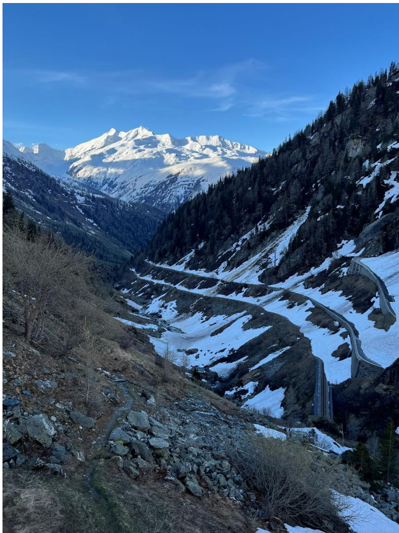
Blick von der Spitzkehre der Kantonsstrasse beim bergseitigen Portal des Kehrtunnels in die Rottenschlucht. Die schneebedeckten Gipfelregionen des Blashorns, Mittagorns und Pizzo Gallina in der Morgensonne. Bild: Patrick Smit
