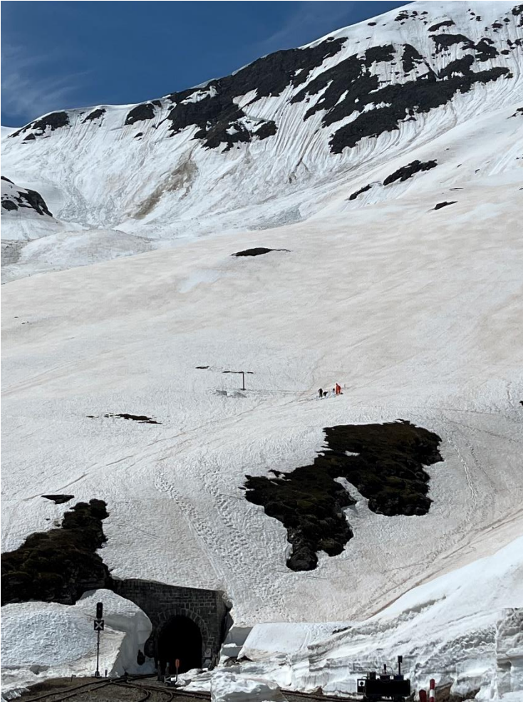
Peter Fietz, Werner Spahni, Christoph Suter und sein Kollege sowie Alphonse Teuffer suchen das Wasserreservoir des Bahnhofs Furka unter einer bis 3 m mächtigen vereisten Schneedecke. Da ein Schneefahl des Wasserreservoirs umgestürzt ist, können sie das Wasserreservoir nicht einmessen. Bild: Patrick Smit
