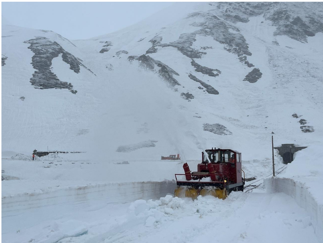
Die HGm 51 mit Anbaufräse räumt den mit dem Bagger aufgebrochenen vereisten Schnee vom Gleis 1 des Bahnhofs Muttbach-Belvédère weg. Bild: Patrick Smit
