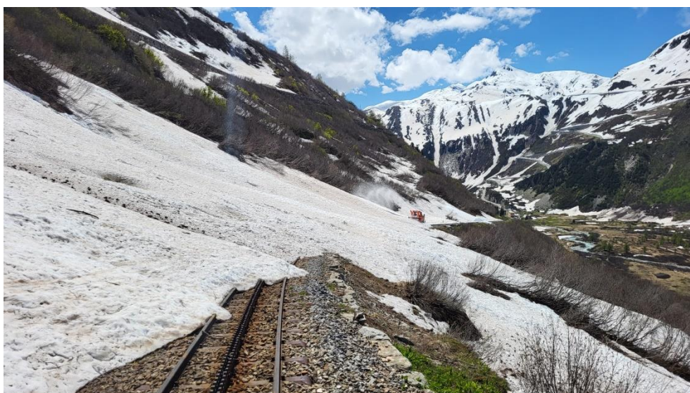
Der Lawinenkegel unterhalb der Hilfsbrücke.
