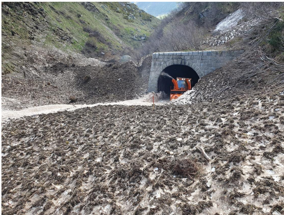
Das bergseitige Portal des Tunnels 3.
