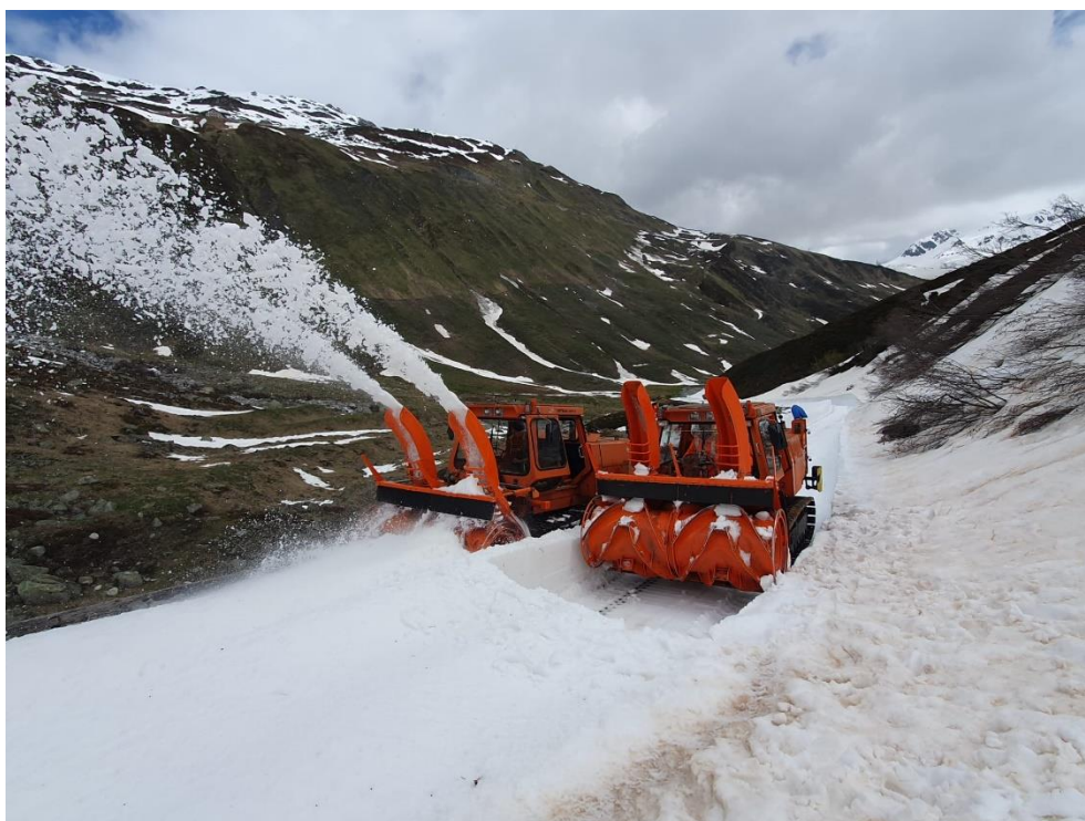
Zwischen Tiefenbach und Steinstafelviadukt. Bild: Michael Bühler
