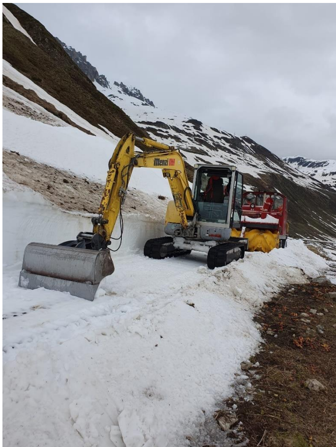
Bagger und HGm 51 mit Anbaufräse kurz vor der Sidelenbachbrücke. Bild: Bruno Zimmermann
