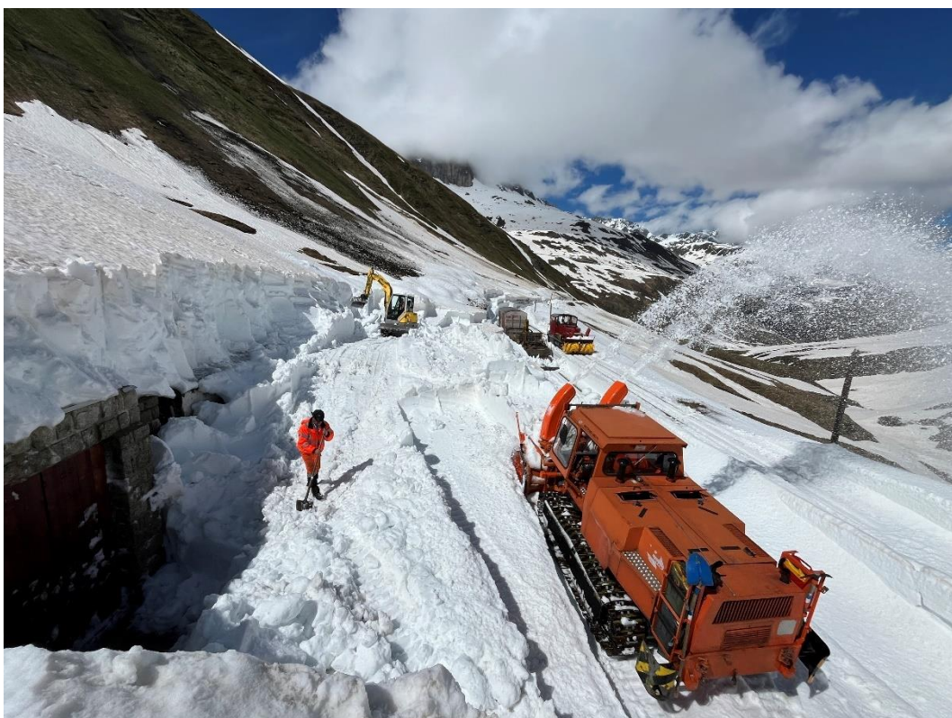
Bagger und INTRAC Raupenfräse beim Räumen des Vorplatzes des Bahnhofs Furka. Bild: Patrick Smit
