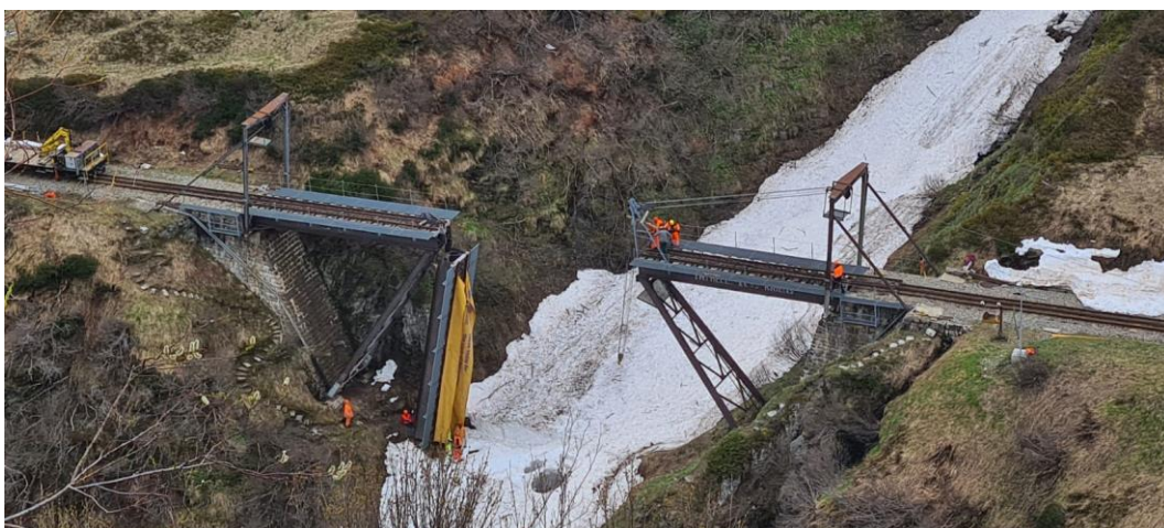
Das bergseitige Brückenelement ist ebenfalls in der Sommerposition.
