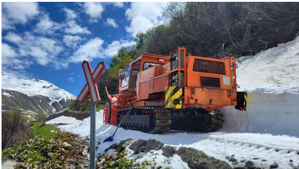
Die INTRAC Raupenfräse beim Wanderweg-Übergang oberhalb von Gletsch.
