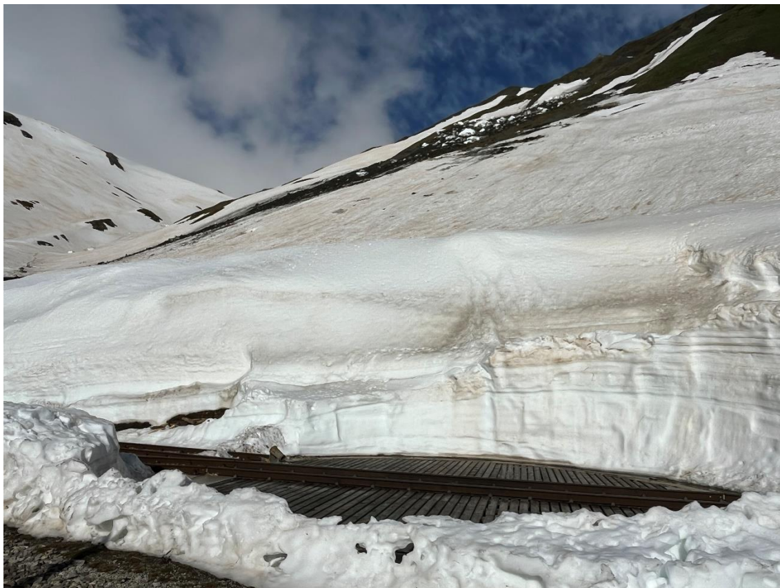
Die Drehscheibe des Bahnhofs Furka.
