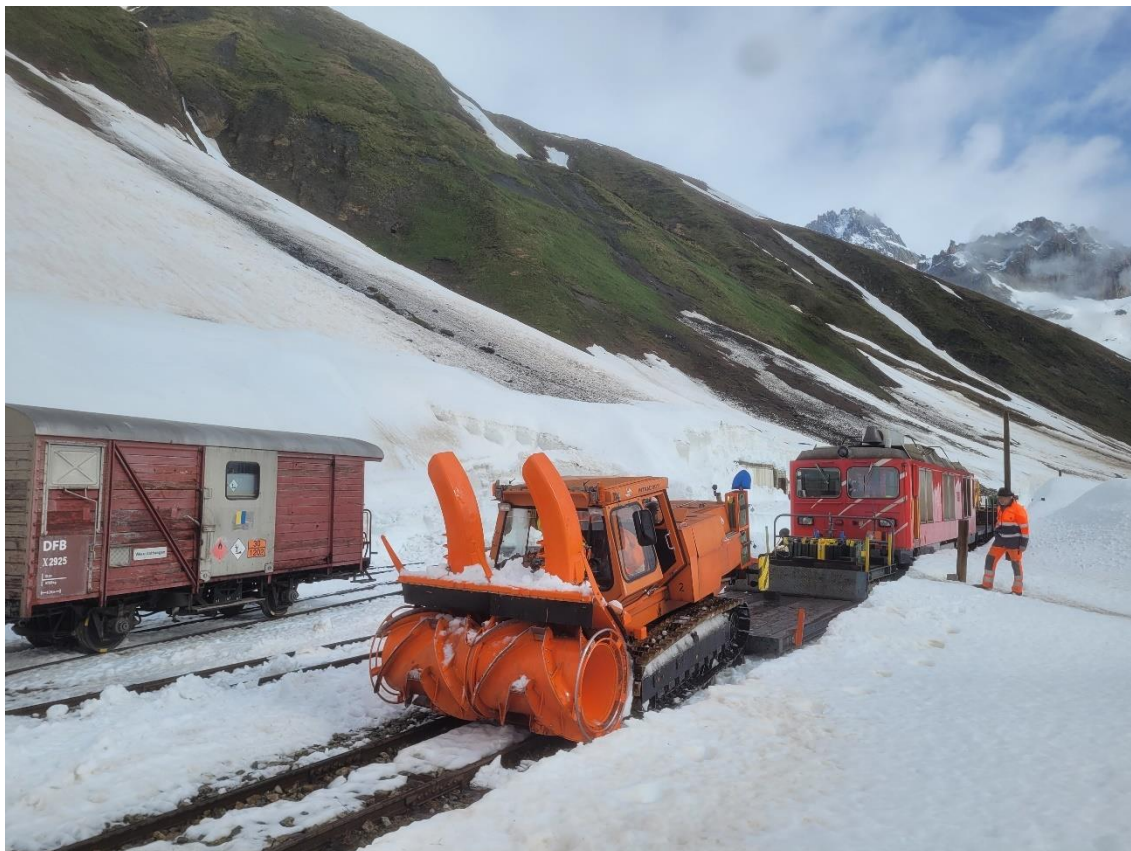
Zwischenzeitlich verladen Eric Fornallaz und Ernst Demonti die INTRAC Raupenfräse von Michael Bühler und Thomas Holder auf den Tiefgänger und überführen diese vom Bahnhof Furka zum Westportal des Scheiteltunnels. Bild: Eric Fornallaz
