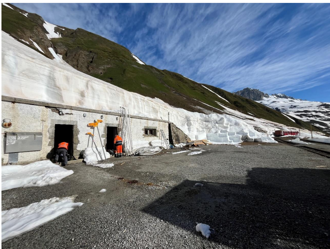
Der geräumte Vorplatz des Bahnhofs Furka. Bild: Patrick Smit
