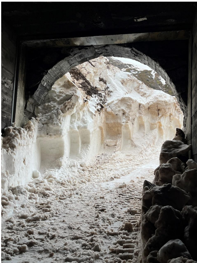
Das bergseitige Portal des Tunnels 2 bei Arbeitsabbruch um 15 Uhr. Bild: Patrick Smit
