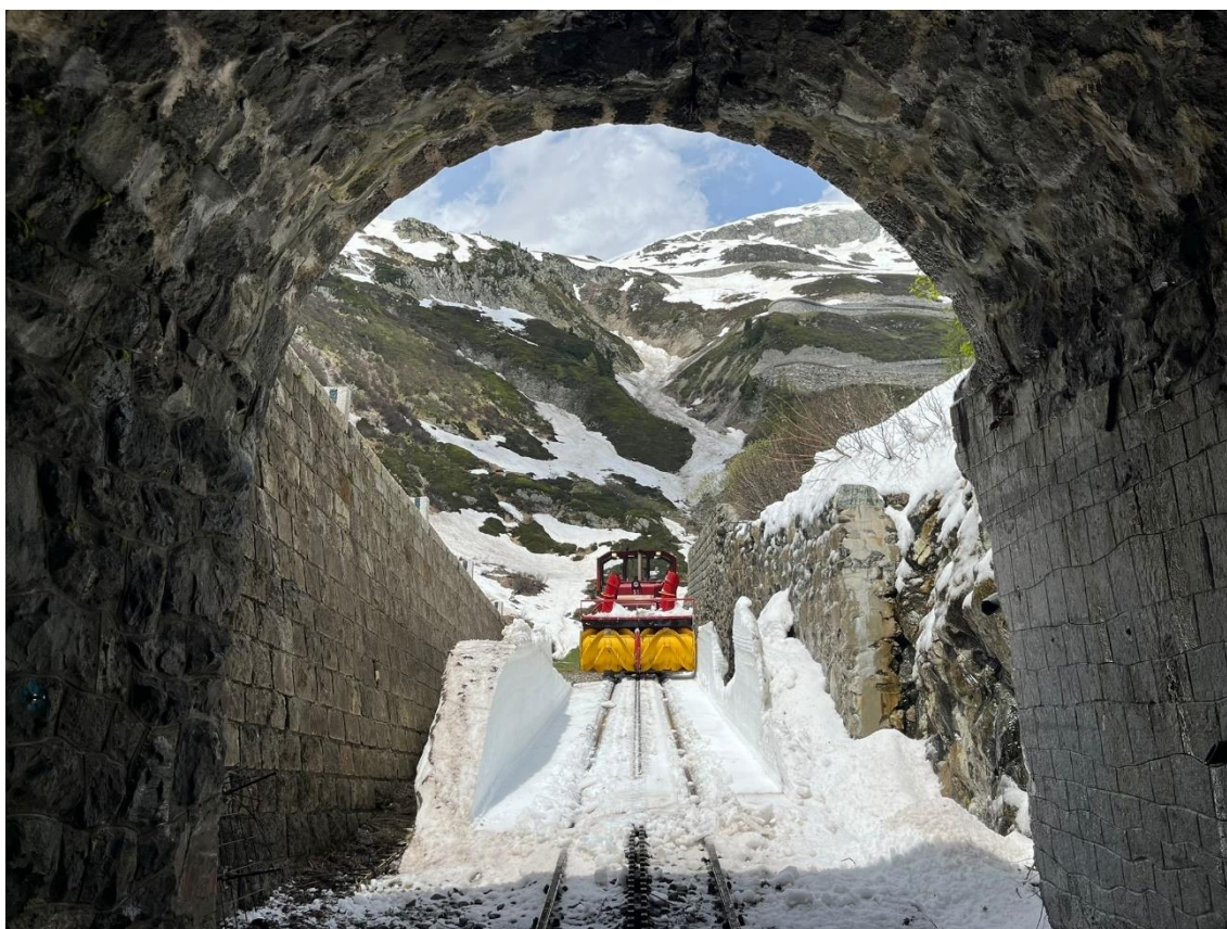
Geschafft! Die Strecke Realp-Kehrtunnel ist schneefrei und befahrbar. Bild: Koen de Decker.
