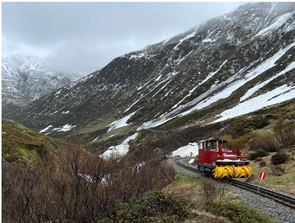
Geschafft! Die HGM 51 mit Anbaufräse steht vor der Steffenbachbrücke. Bild: Patrick Smit
