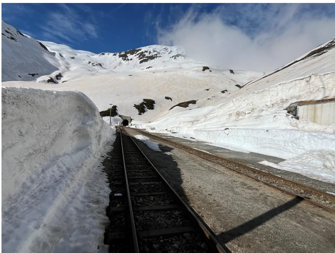
Blick vom Bahnhof Furka Richtung Portal des Scheiteltunnels.
