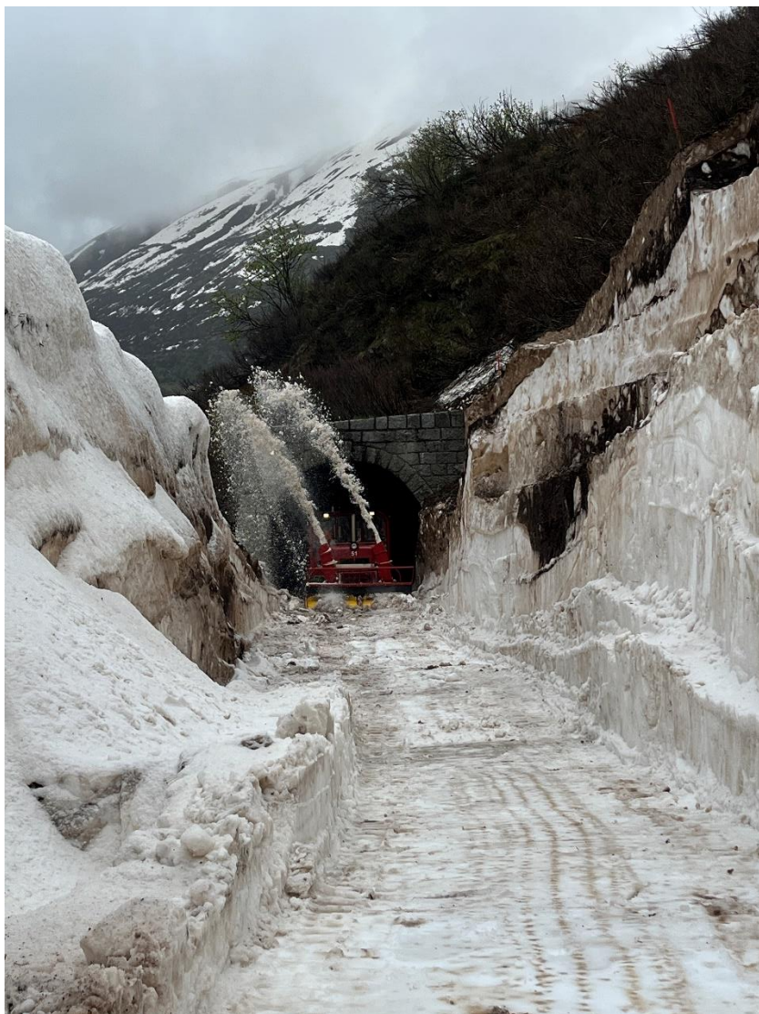
Die HGm 51 mit Anbaufräse kämpft sich durch den stark vereisten Lawinenschnee zwischen Tunnel 3 und Tunnel 2. Bild: Patrick Smit
