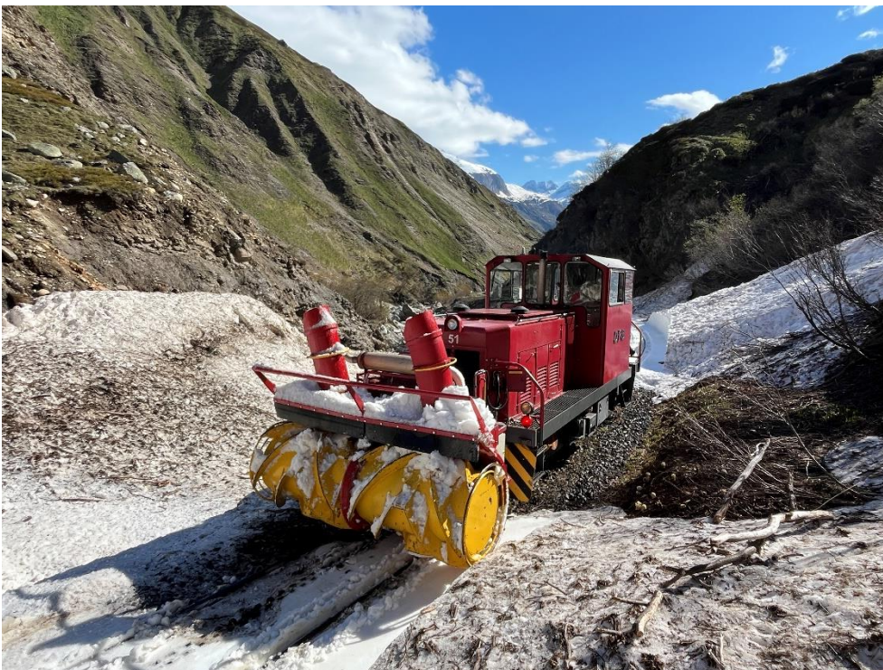
Die HGm 51 mit Anbaufräse kurz vor dem Tunnel 3.
