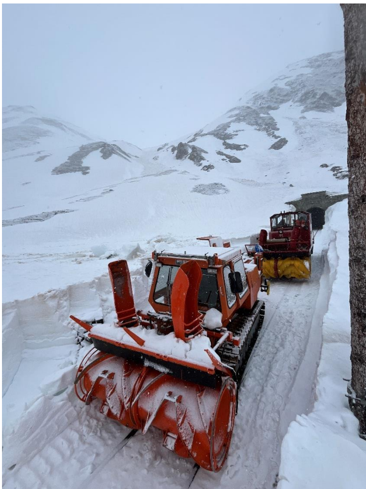
Bei stürmischem Schneefall machen die Maschinen in Muttbach-Belvédère die INTRAC Rau- penfräsen und den Bagger betriebsbereit.
