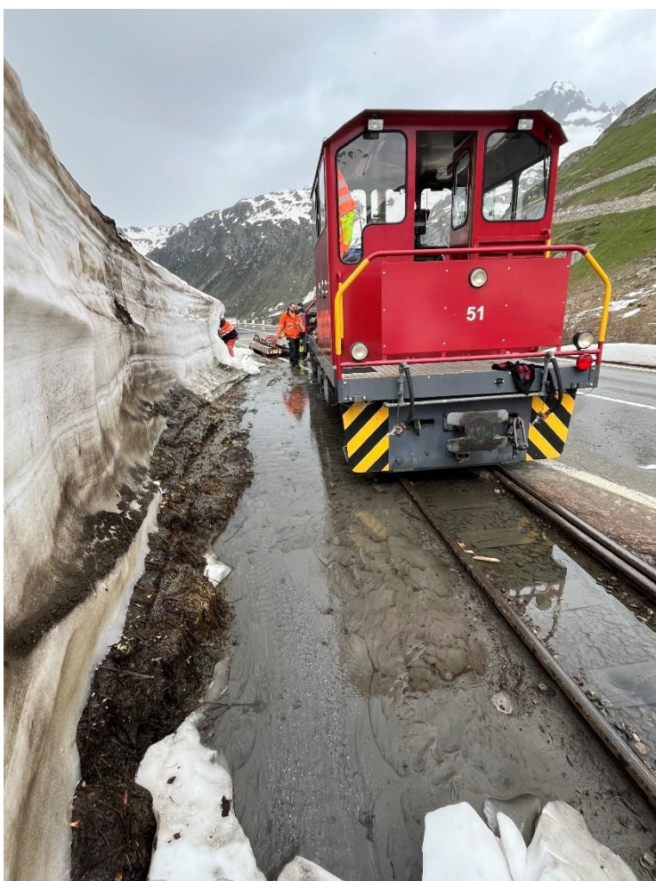
Weil ein Durchlass beim Bahnübergang Furkastrasse verstopft ist, läuft das Wasser nun über den Bahnübergang. Bild: Patrick Smit
