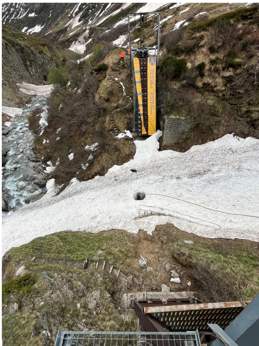
Dank der warmen Witterung der letzten Tage ist das Lichtraumprofil für das Aufstellen der Steffenbachbrücke nur an wenigen Ort noch knapp verletzt.
