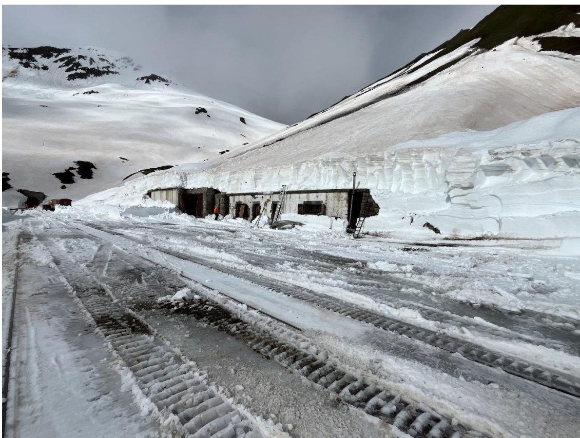
Der Vorplatz des Bahnhofs Furka nach 2 Tagen Fräs- und Räumarbeit.
