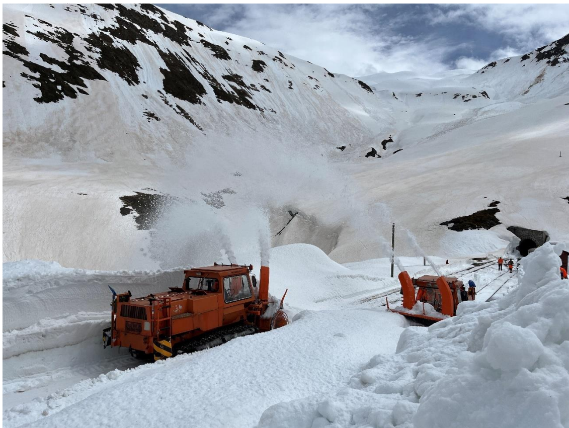
Die beiden INTRAC Raupenfräsen unterstützen die HGM 51 mit Anbaufräse bei deren Räumarbeit.
