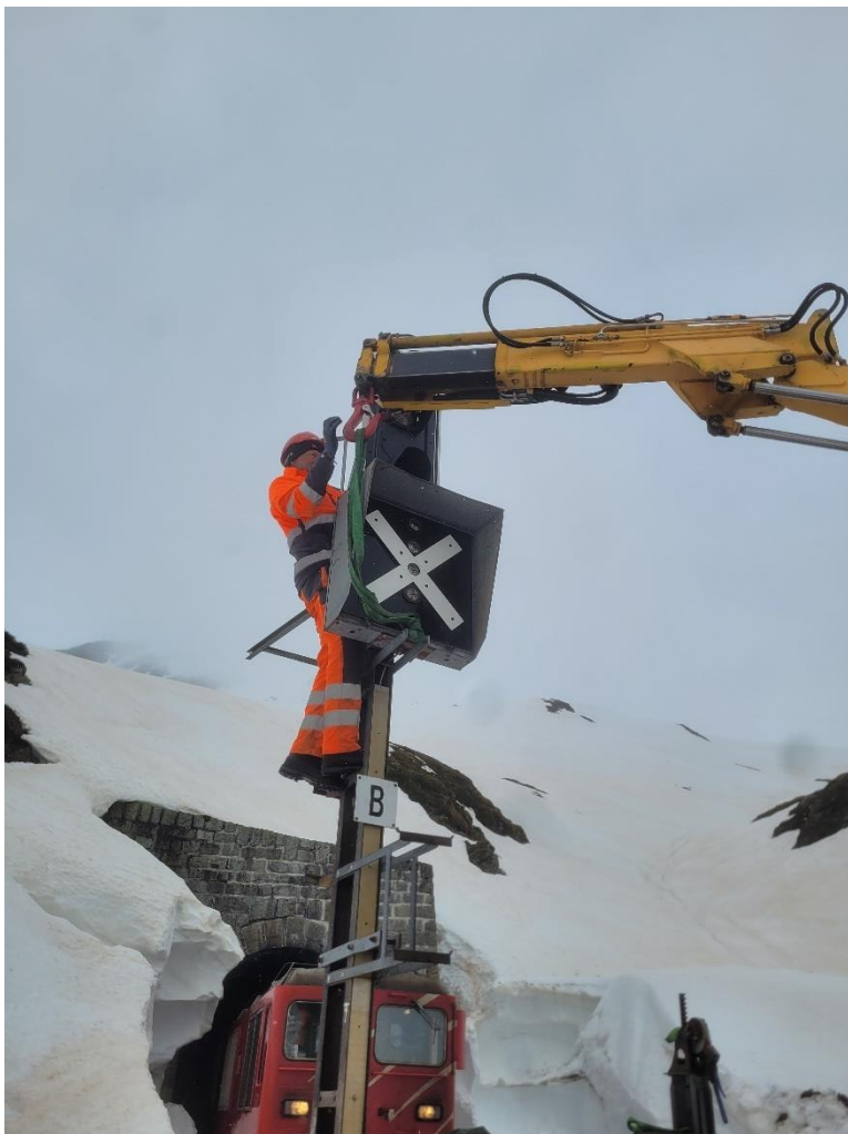
Ernst Demonti bei der Montage des Ausfahrtsignals Furka.
