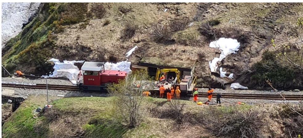
Der Bauzug erreicht um 16.30 Uhr das Windenhaus auf der Bergseite der Steffenbachbrücke. Bild: Ed Groenendijk
