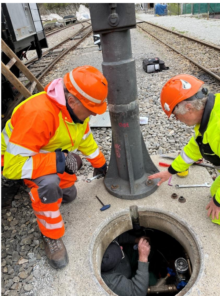
Montage des Wasserkrans 2 und der neuen Spindel.
