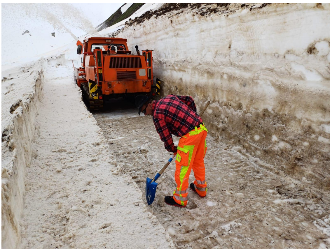
Im Lawinenkegel unterhalb der Seitenbachbrücke sondiert Thomas Holder die Zahnstange.
