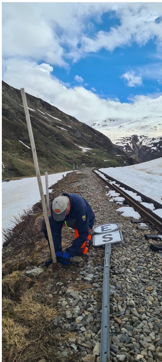
Ed Groenendijk und Beat Mühlemann montieren ein Weichensignal und das talseitige A/E-Signal des Bahnhofes Tiefenbach. Bild: Ed Groenendijk
