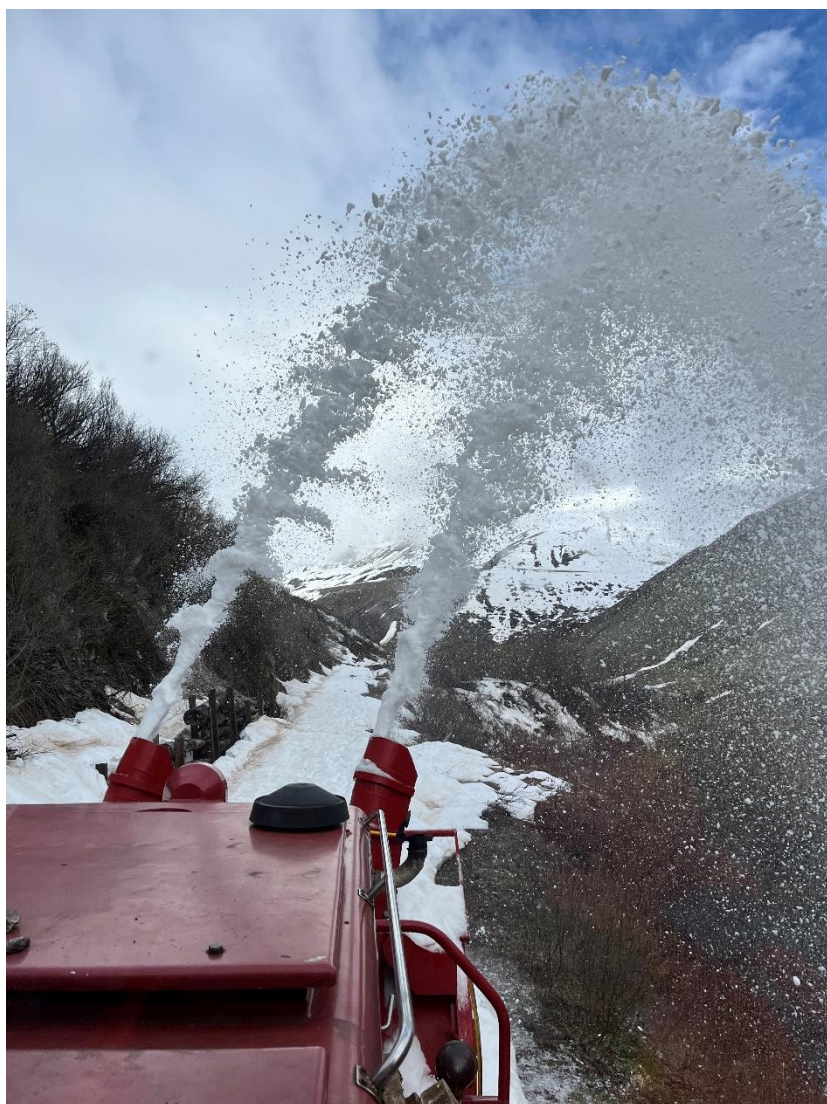
Michael Bühler (Helfer), Thilo Fock (Fräsmaschinist), Pascal Rauber (Helfer) und Patrick Smit (Lokführer) fräsen mit der HGm 51 mit Anbaufräse den Frühjahrschnee zwischen Steffenbachbrücke und bergseitigen Zahnstangeneinfahrt des Bahnhofs Tiefenbach. Bild: Patrick Smit
