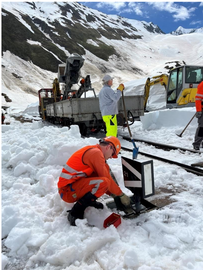
Andreas Kessler montiert das Weichensignal der Einfahrweiche 21.
