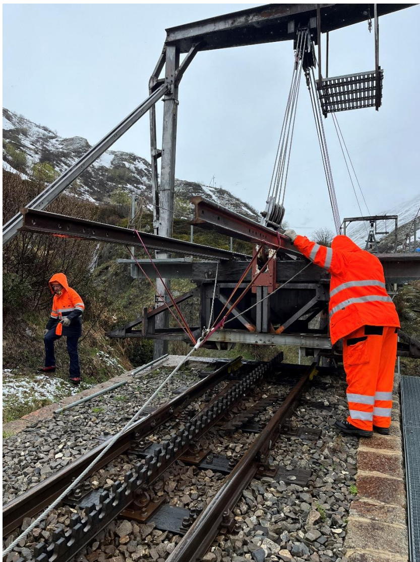
Unter der Leitung von Christoph Spinnler wird das talseitige Brückenelement der Steffenbachbrücke in die Sommerposition gebracht.
