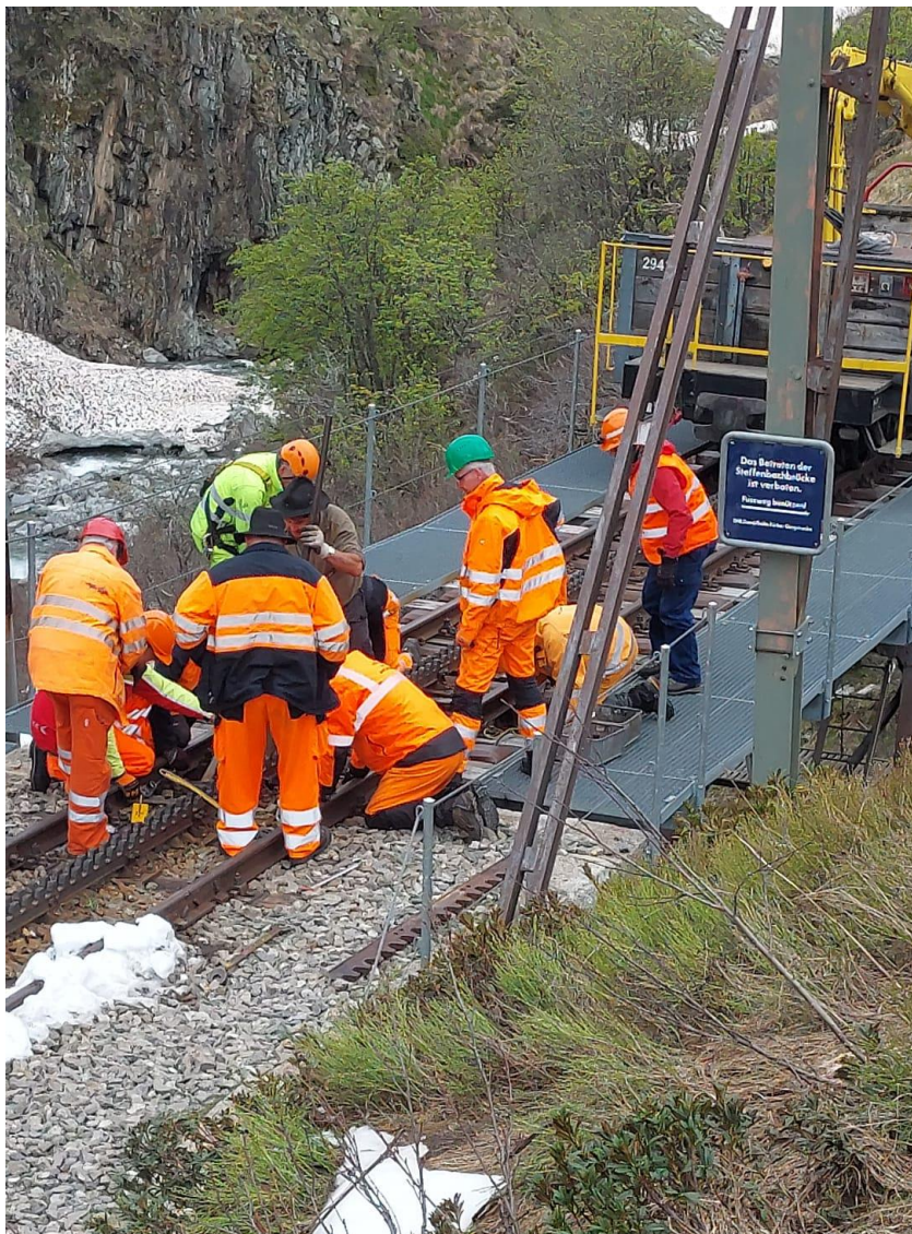
Montage der Zahnstange am bergseitigen Widerlager der Steffenbachbrücke. Bild: Martin Fischer
