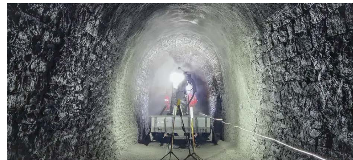
Foto Sammlung SFB: Gunitierarbeiten im Scheiteltunnel
